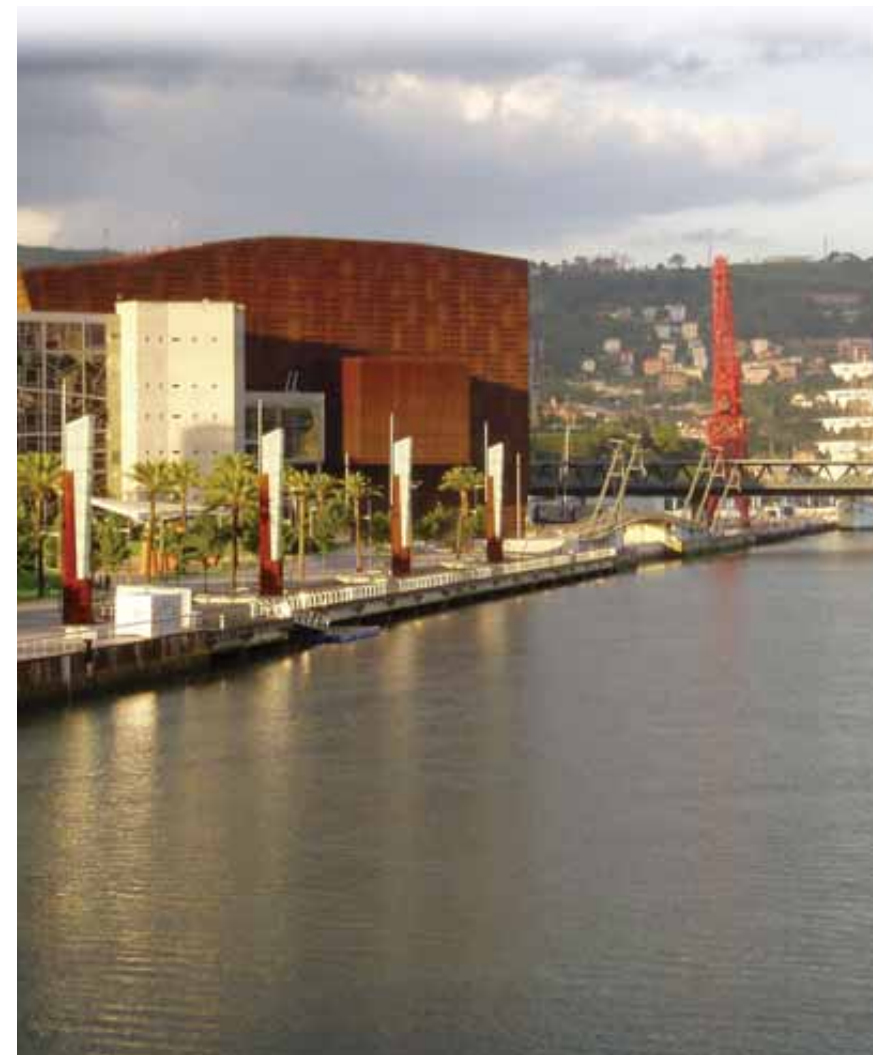
Palatul Congreselor și al Muzicii “Euskalduna” , construit pe locul vechilor instalații aparținând șantierului naval cu același nume. Bilbao.
