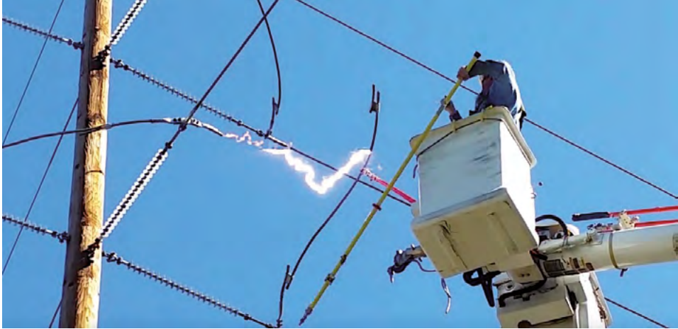
Figura 7.18. PEMP aislada para trabajos en tensión
