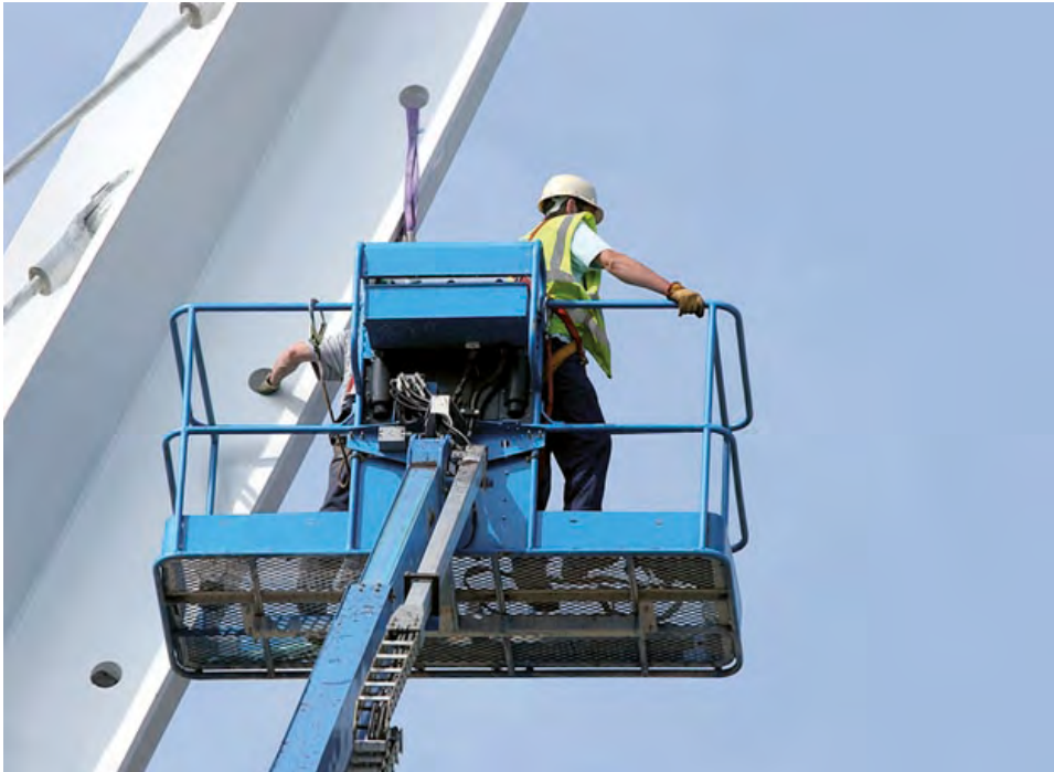
Figura 7.7. ¿Por qué no se ha anclado la eslinga del arnés en el lugar específico?
