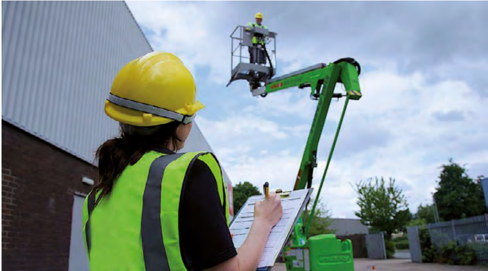
Figura 6.10. Supervisión uso correcto de una PEMP
