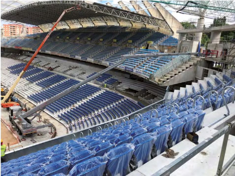
Figura 5.2. Ajuste del uso de la PEMP a las condiciones del entorno
