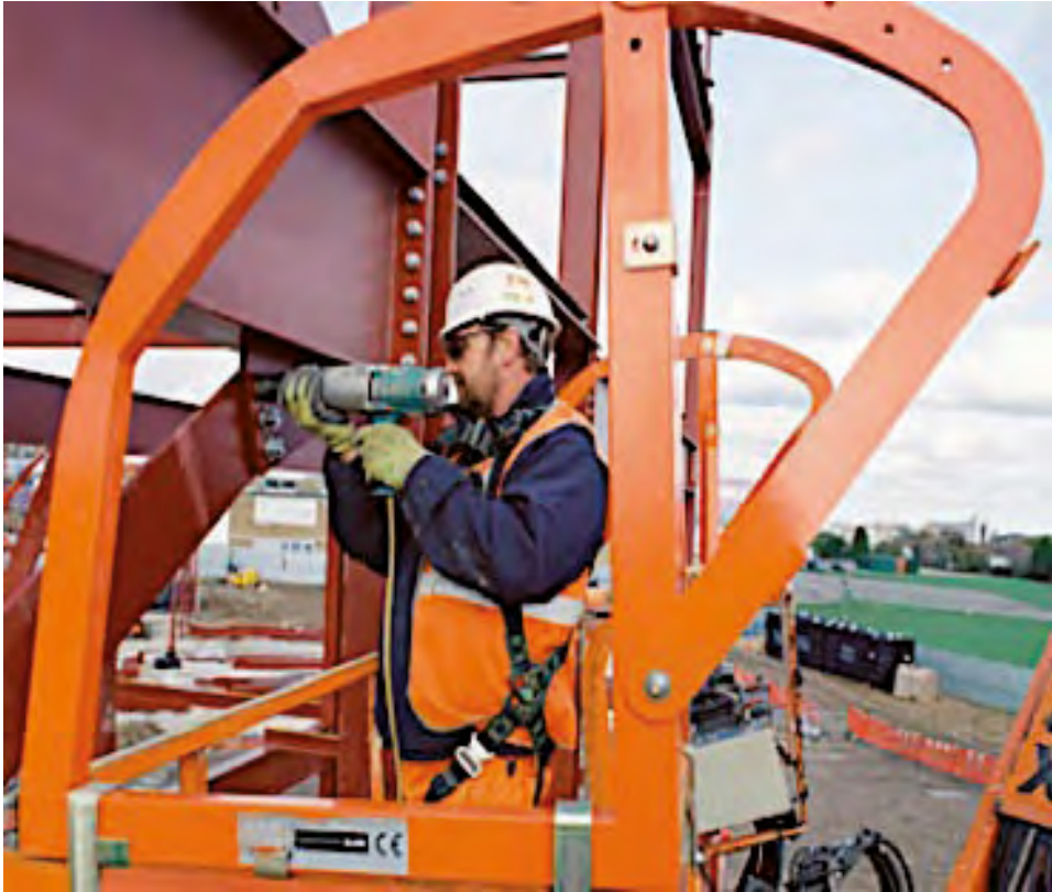
Figura 5.29. Dispositivo antiatrapamiento en cesta
