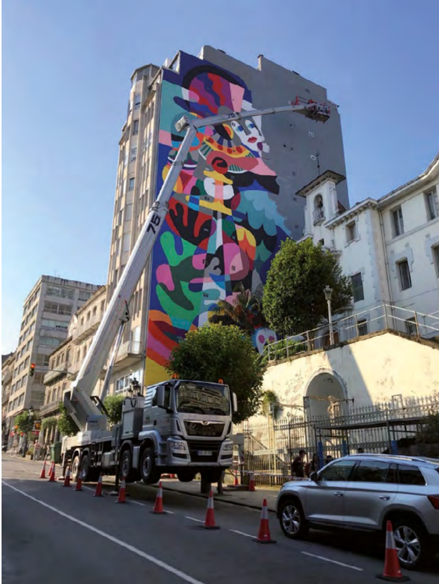
Figura 5.22. Trabajos de gran altura con exigencia mental
