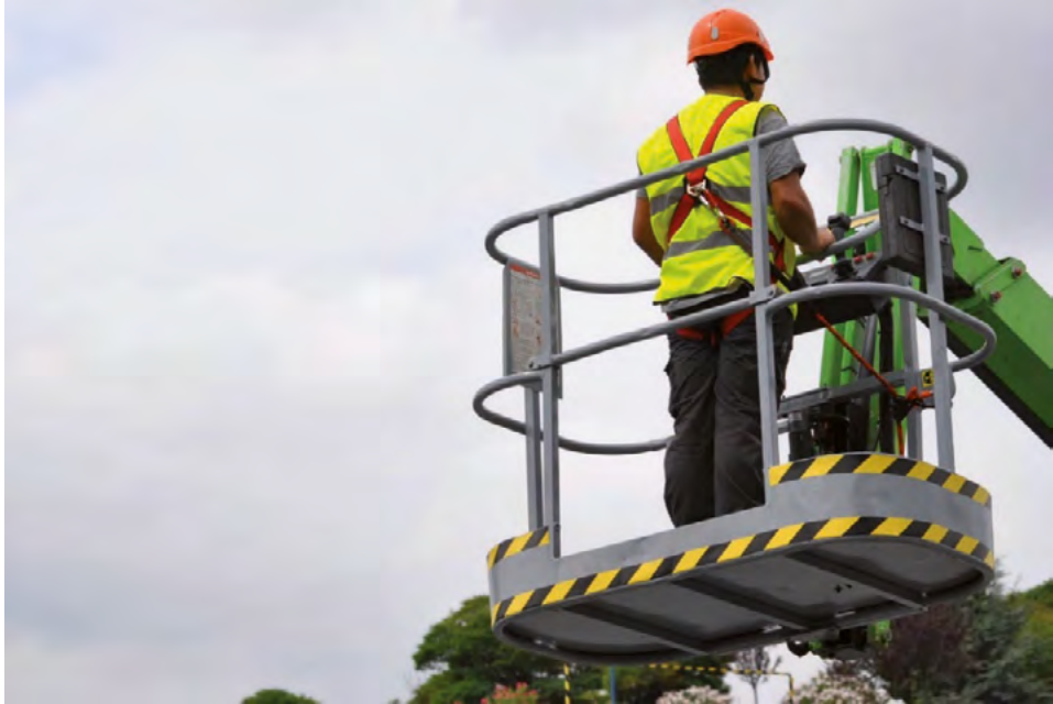
Figura 7.23. Operador con el arnés correctamente ajustado
