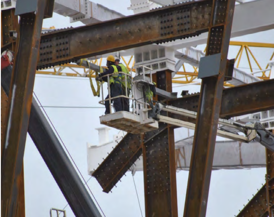
Figura 5.21. Trabajos de montaje con exigencia física
