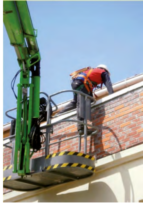
Figuras 7.8 y 7.9. Arnés correctamente ajustado, y abandono de la cesta en posición elevada, respectivamente
