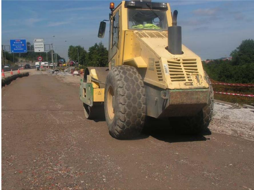
**Figura 17:** Compactación de la explanada. Tramo de prueba del Txorierrri
