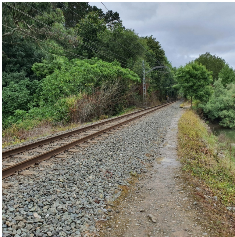
Imagen 3.VIII: Itinerario actual Fase A junto a las vías del tren
