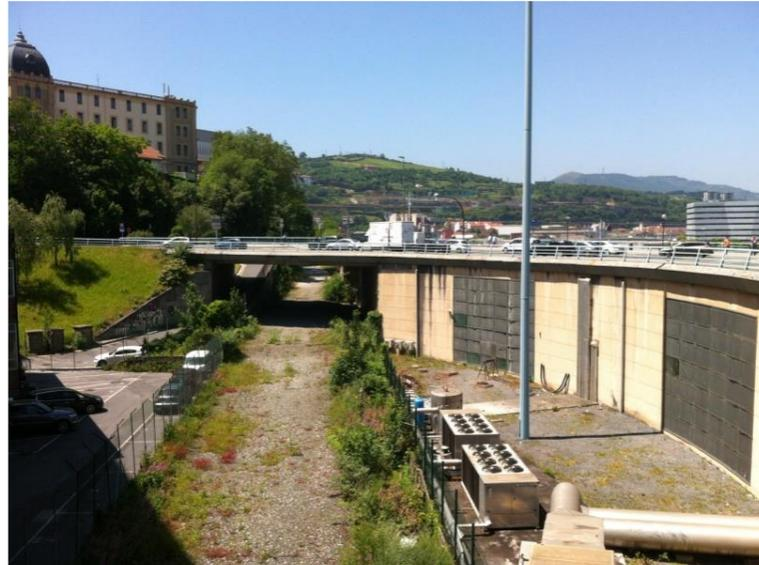
Imagen tomada hacia el Oeste de la fachada trasera el Museo Marítimo que mira hacia el interior de la rotonda de Euskalduna. Se aprecian las instalaciones y huecos en fachada a compatibilizar con la estructura portante del recrecido de acera y calzada en cubierta del edificio que la bordeará. Se aprecia el tablero Oeste (lado Olabeaga) a recrecer sobre la plataforma ferroviaria.
