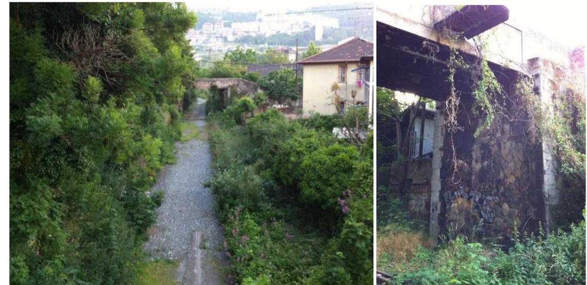
En la imagen de la izquierda se aprecia la plataforma ferroviaria de Adif sobre la que se instalará la nueva plataforma tranviaria. Al fondo de la imagen se encuentra la posición de la parada de Olabeaga a la altura de la pasarela existente que se afectará y será necesaria su reposición. En la imagen de la derecha se puede observar el apoyo de fábrica de lado ría y el tablero de la pasarela existente.
