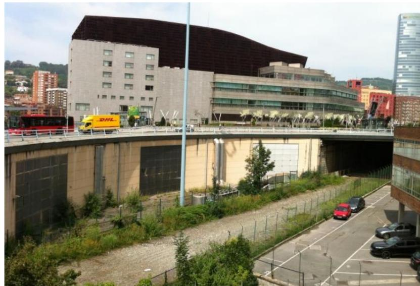
Imagen tomada hacia el Este de la fachada trasera el Museo Marítimo que mira hacia el interior de la rotonda de Euskalduna. Se aprecian las instalaciones y huecos en fachada a compatibilizar con la estructura portante del recrecido de acera y calzada en cubierta del edificio que la bordeará. Se aprecia el tablero Este (lado Plaza del Sagrado Corazón) a recrecer sobre la plataforma ferroviaria.
