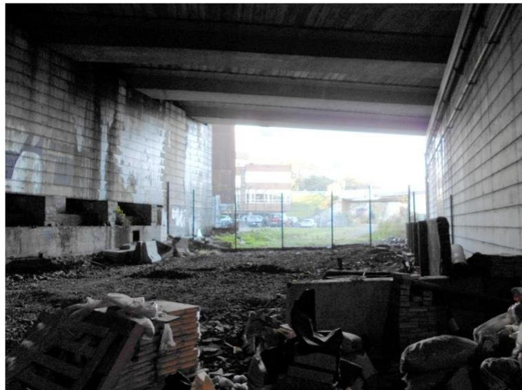
Vista de la estructura de soporte de la glorieta desde la plataforma ferroviaria abandonada. Se aprecia la tipología de vigas doble T. Tablero Este (lado Plaza Sagrado Corazón).
