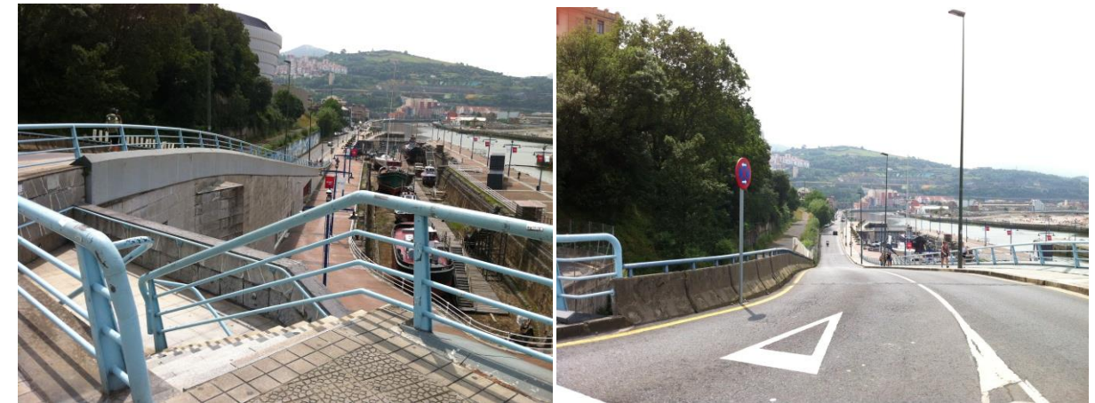
A la izquierda, imagen desde la rotonda de Euskalduna a las escaleras del Museo Marítimo y el muelle Ramón de la Sota. A la derecha, imagen desde la misma glorieta hacia el acceso al Muelle de Olabeaga.
