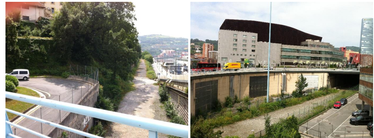
Imágenes desde la rotonda de Euskalduna. A la izquierda, hacia el acceso al parking del edificio Euskalduna y a la derecha hacia la fachada trasera del Museo Marítimo.
