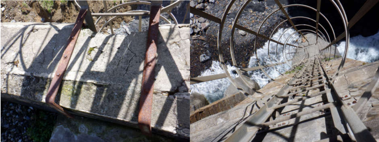
73. irudia. Lotura gailurrean
