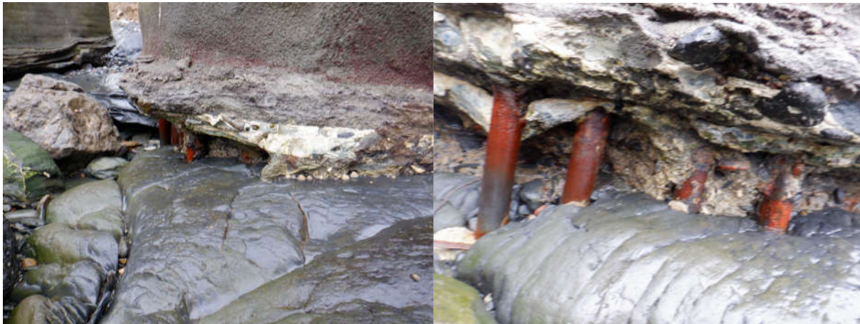
42. irudia. 6. Pilarean agerian dauden mikropiloteak
