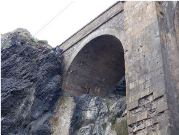
27. irudia. E1 zimenduen xehetasuna
