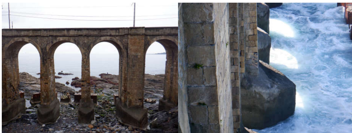
24. irudia. Erdiko altxaeren zimenduak
