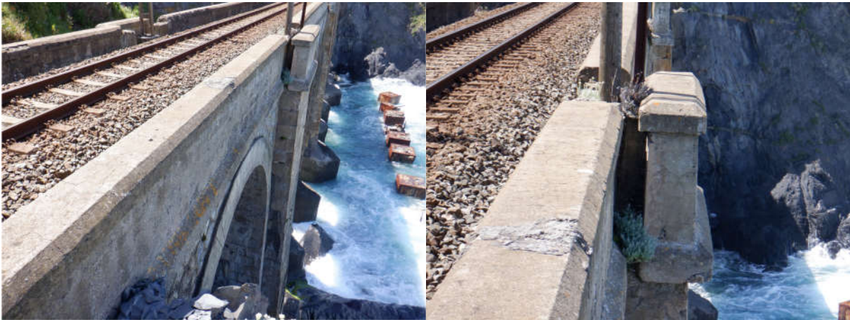
39. irudia. Balastoa babesteko hormatxoaren xehetasuna
