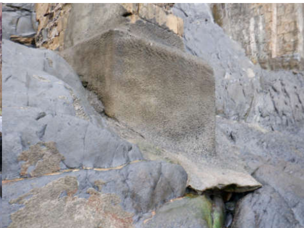
30. irudia. P9 zimenduen xehetasuna
