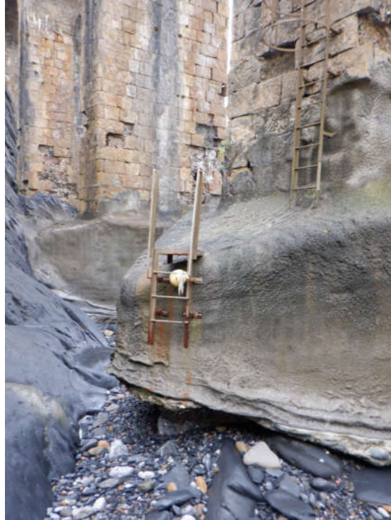
Figura 55. Escalera en canto de zapata
