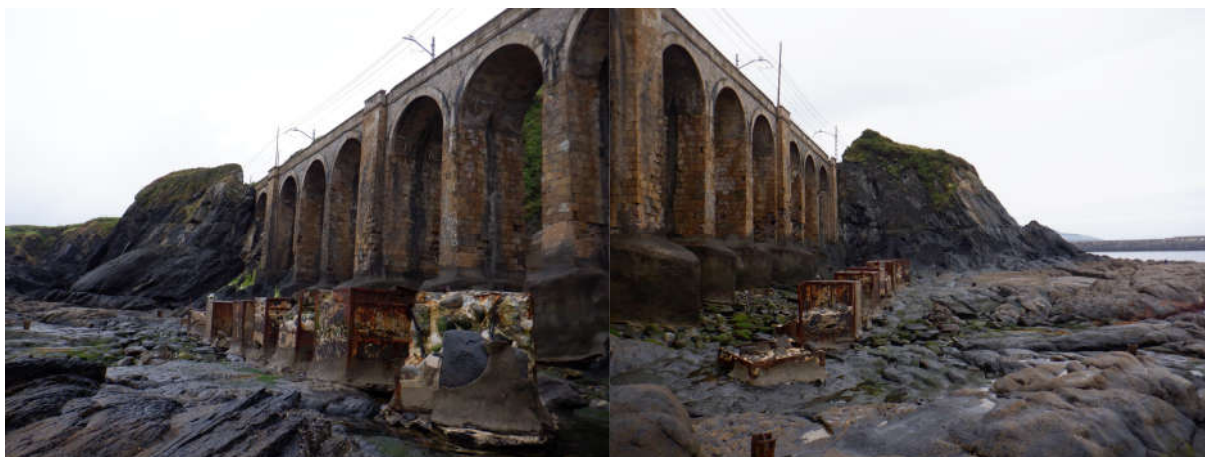
Figura 61. Aspecto de bloques frente al oleaje
