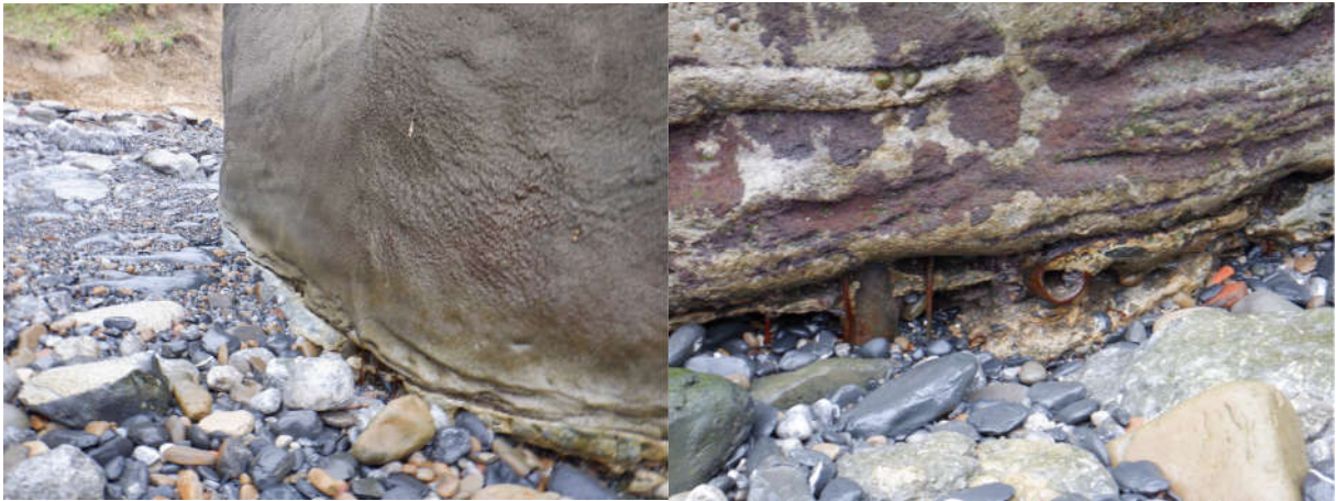
Figura 43. Armadura enresinada a terreno, en pila 5
