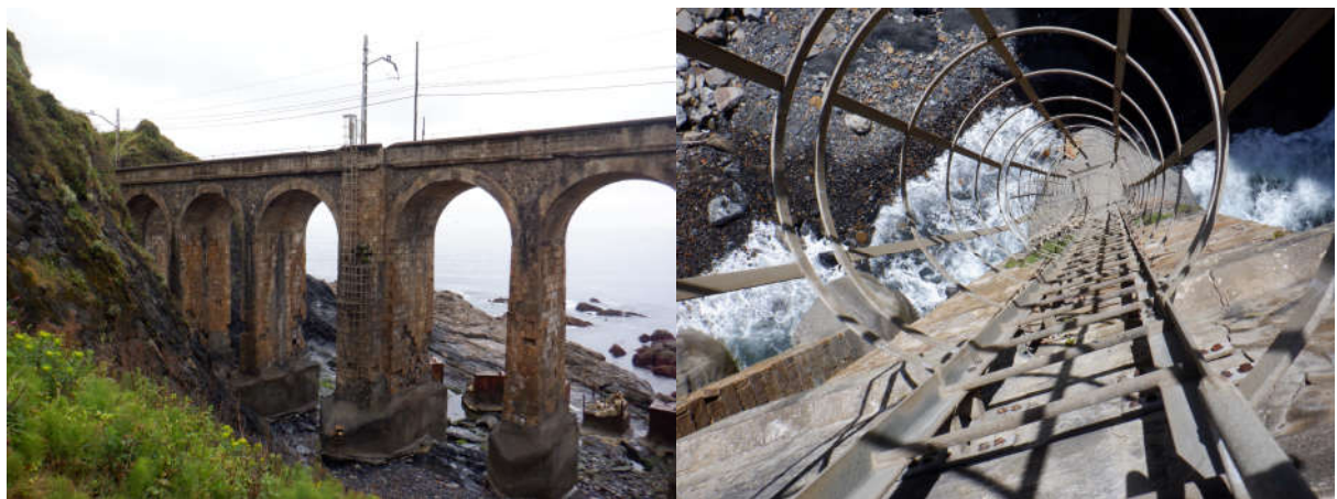
Figura 18. Escaleras acceso desde cala a plataforma
