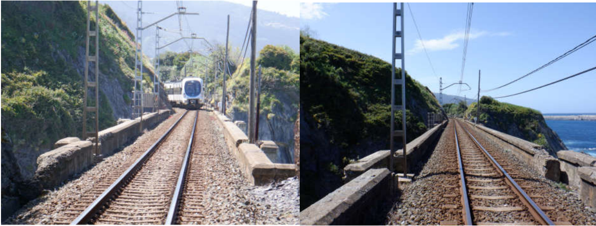
Figura 38. Vista desde tablero
