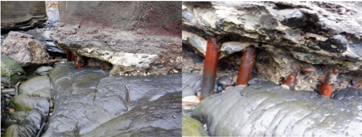
Figura 42. Micropilotes vistos en pila 6
