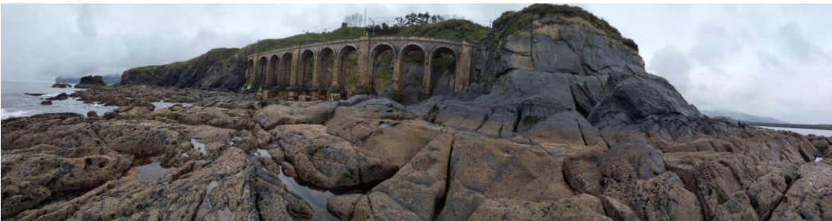
Figura 16. Cala donde se ubica el viaducto
