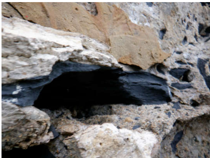
Figura 51. Cavidades en alzado (I)
