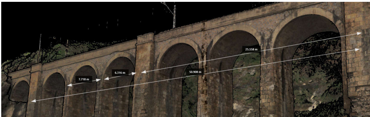
Figura 20. Acotaciones alzado
