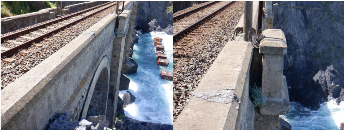
Figura 39. Detalle de muretes guardabalasto
