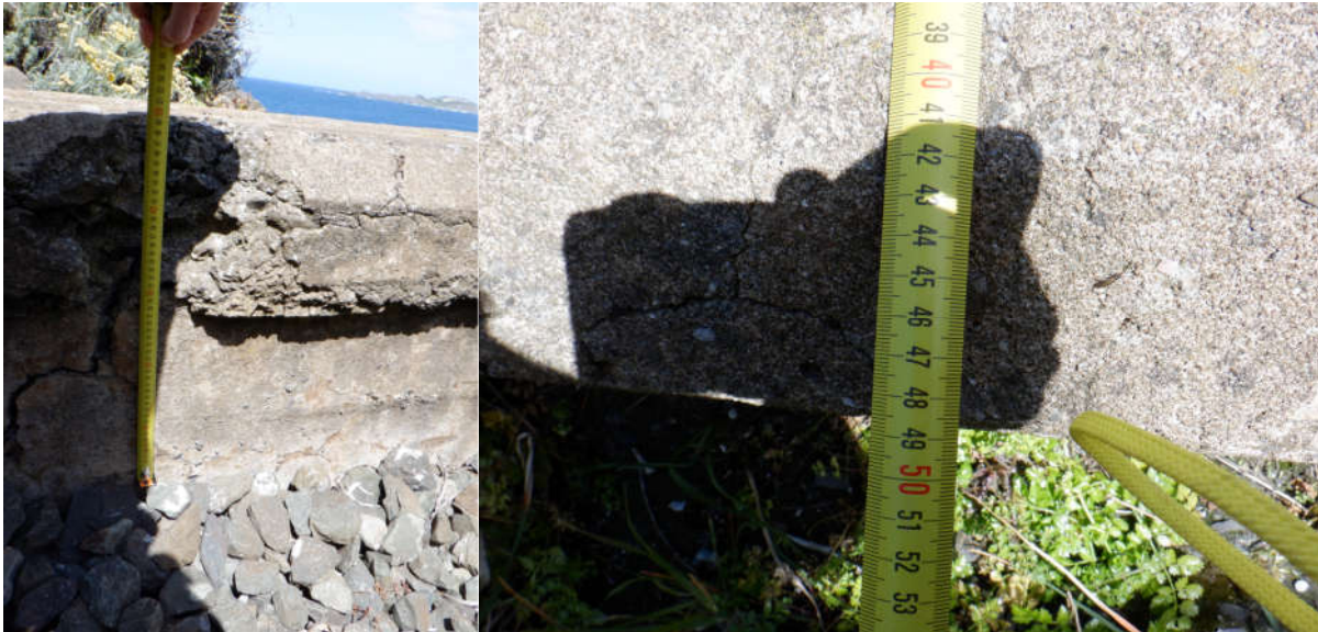
Figura 40. Acotaciones murete guardabalasto
