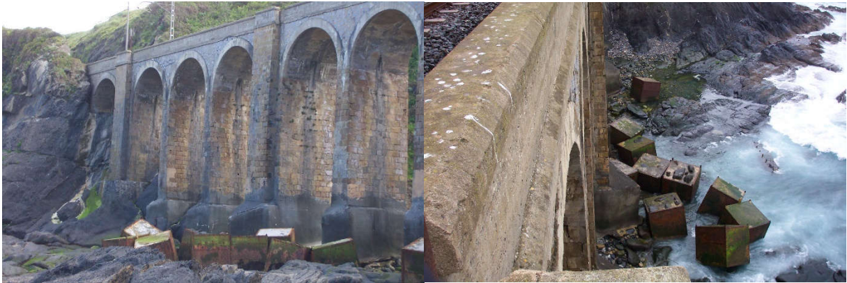
Figura 3. Cubos desplazados en 2003
