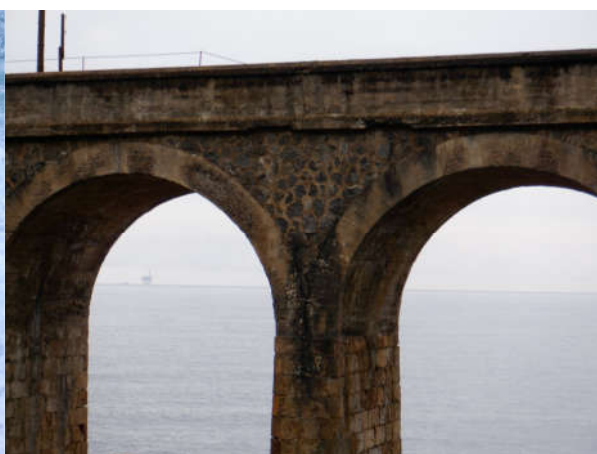
Figura 37. Bóveda y tímpanos
