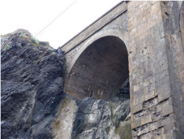
Figura 27. Detalle cimentación E1
