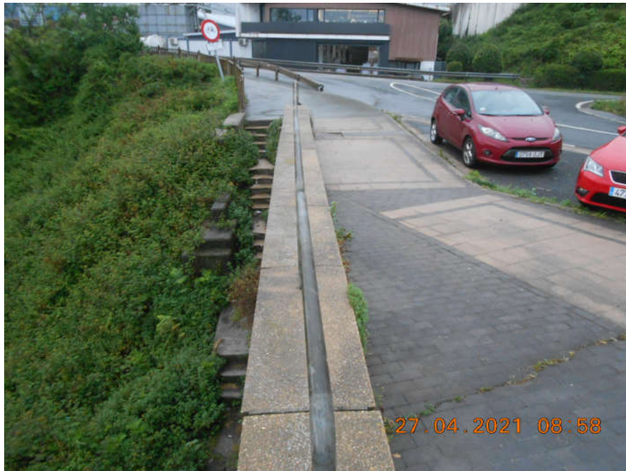
Figura 9. Acceso desde mirador a itinerario sobre emboquille
