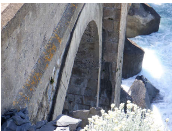
Figura 36. Bóveda de hormigón
