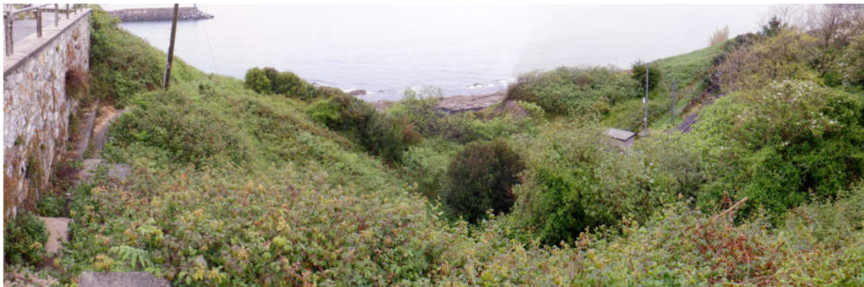
Figura 10. Panorámica desde acceso a camino sobre emboquille
