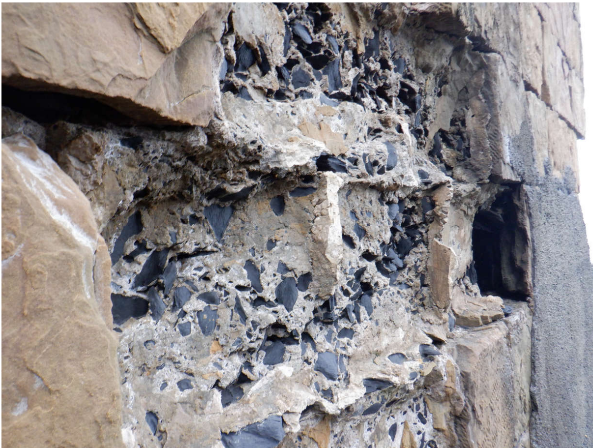
Figura 35. Aspecto interior de las pilas
