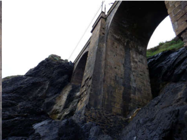
Figura 28. Detalle cimentación P1
