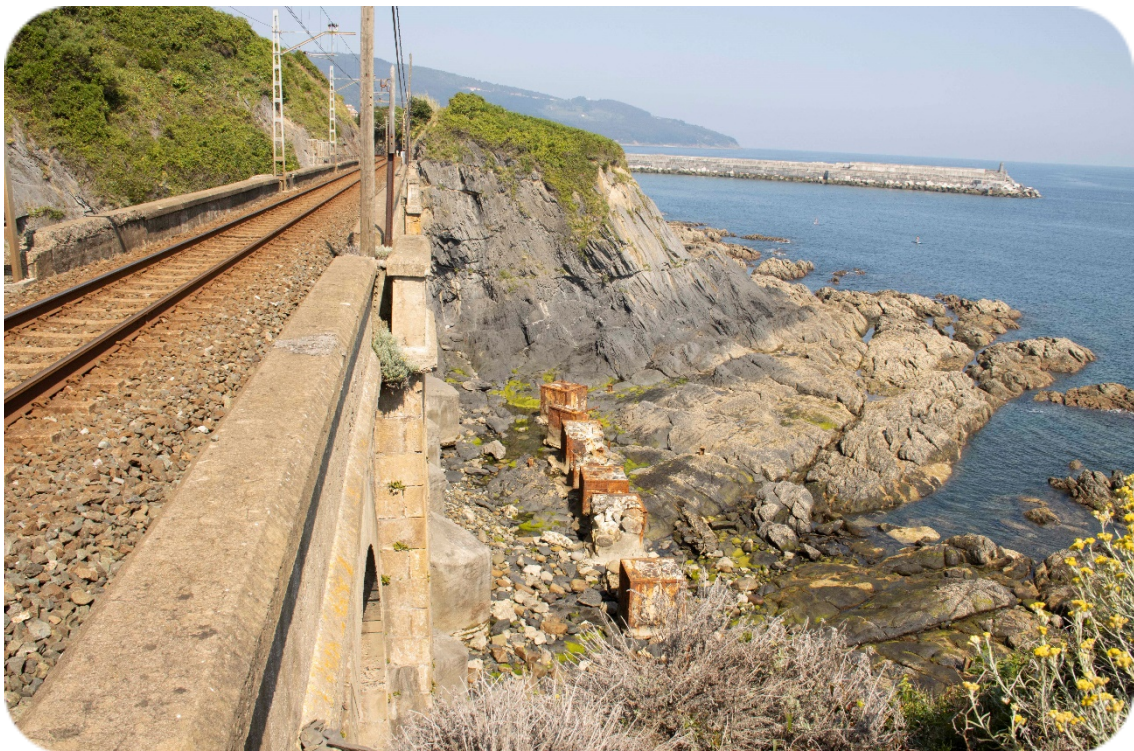
Foto 2. Vista del viaducto desde encima.
