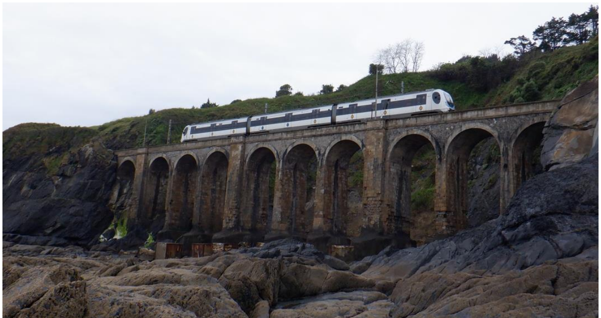
Figura 7. Vista general del alzado lado mar
