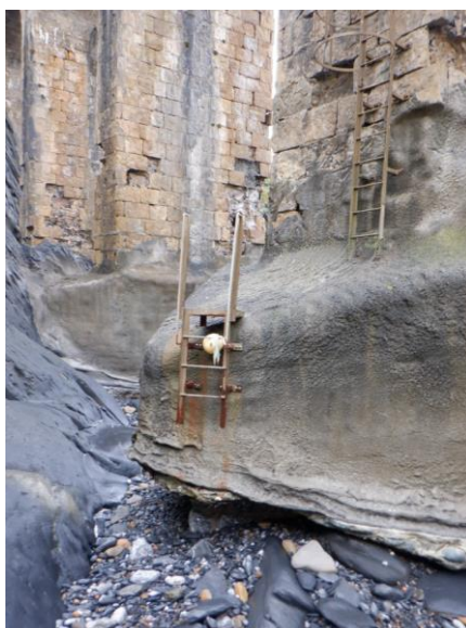
Figura 17. Escalera en canto de zapata
