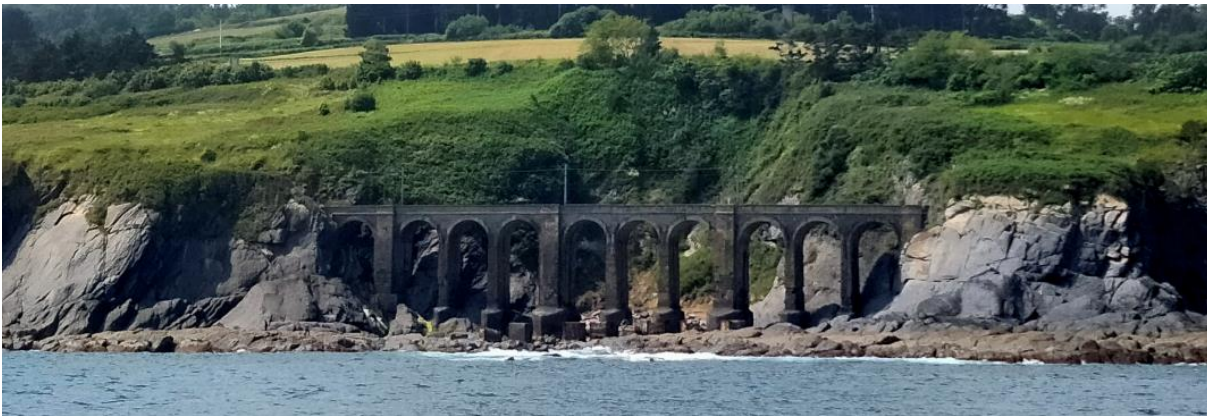
Figura 8. Ubicación viaducto de Lamiaran visto desde el mar
