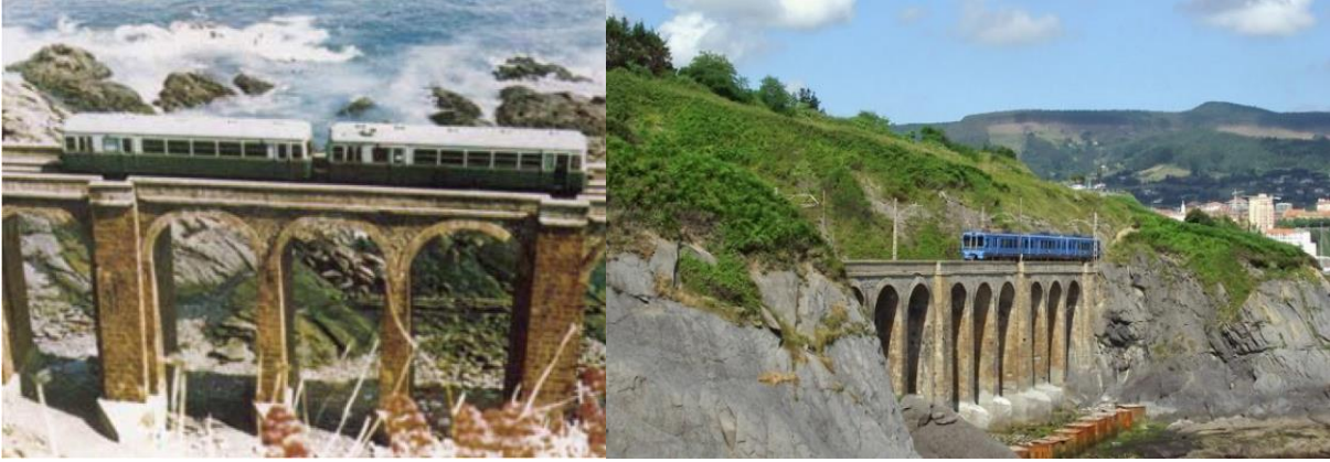
Figura 2. Imágenes del viaducto de Lamiaran, antes y después de disponer de bloques contra el oleaje
