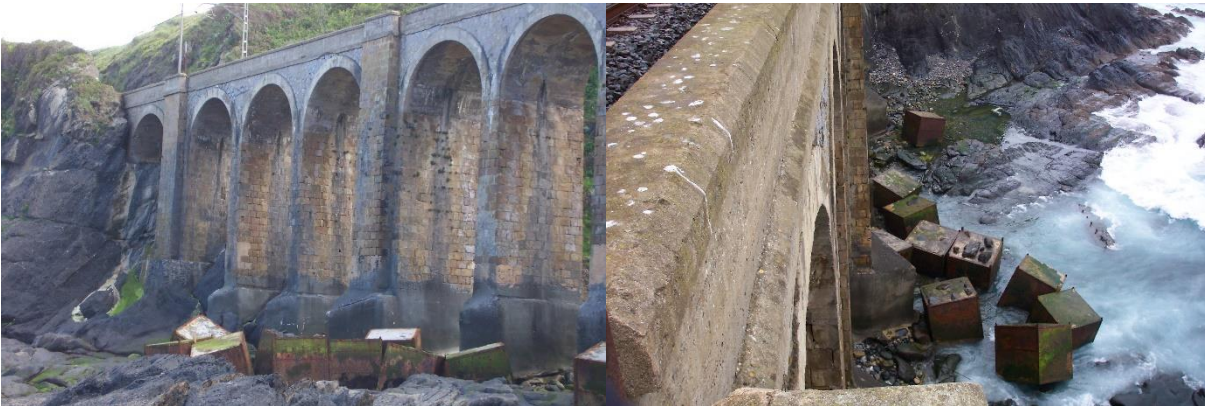
Figura 3. Cubos desplazados en 2003
