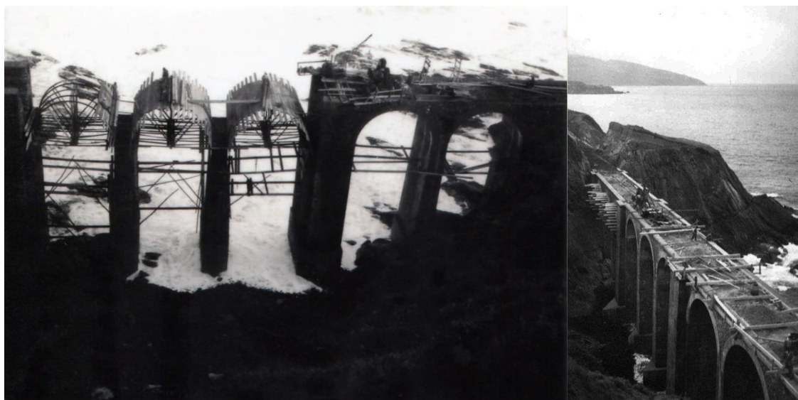
Figura 1. Cimbras de madera para ejecución de bóvedas de hormigón
