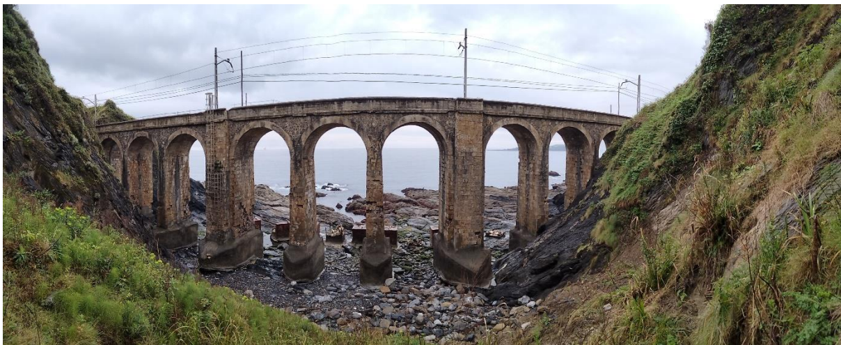
Figura 29. Entrante de costa en el lado tierra del viaducto de Mundaka.
