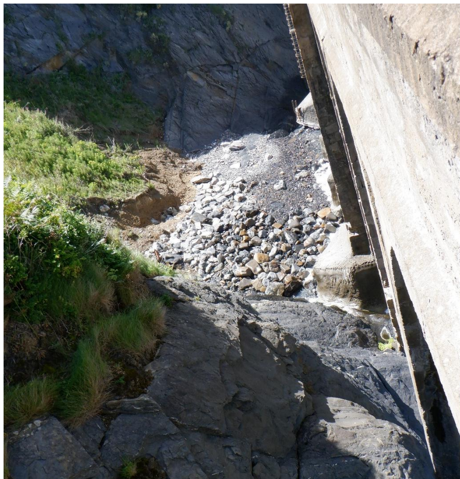
Figura 30. Tamaño de los cantos rodados en el entrante de costa en el lado tierra del viaducto de Mundaka.
