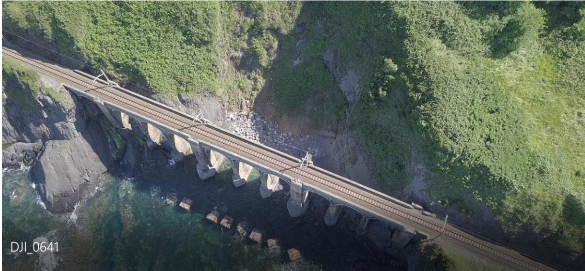
Figura 28. Ladera situada en el lado tierra del viaducto de Mundaka.
