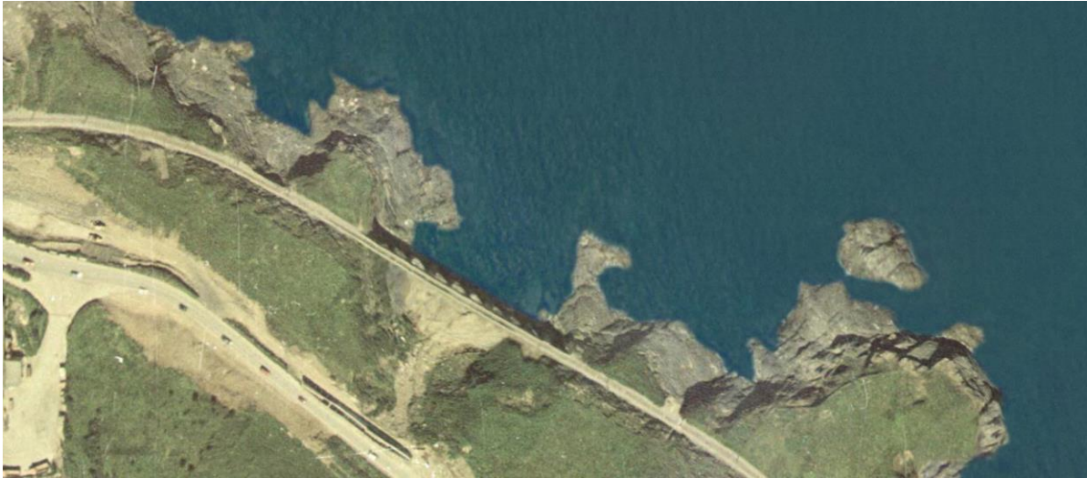
1990. Posible derrumbe de material por la construcción de la carretera
