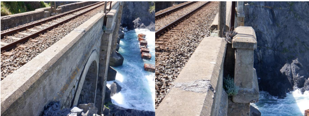
Figura 39. Detalle de muretes guardabalasto
