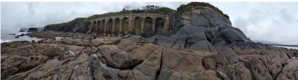
Figura 16. Cala donde se ubica el viaducto
