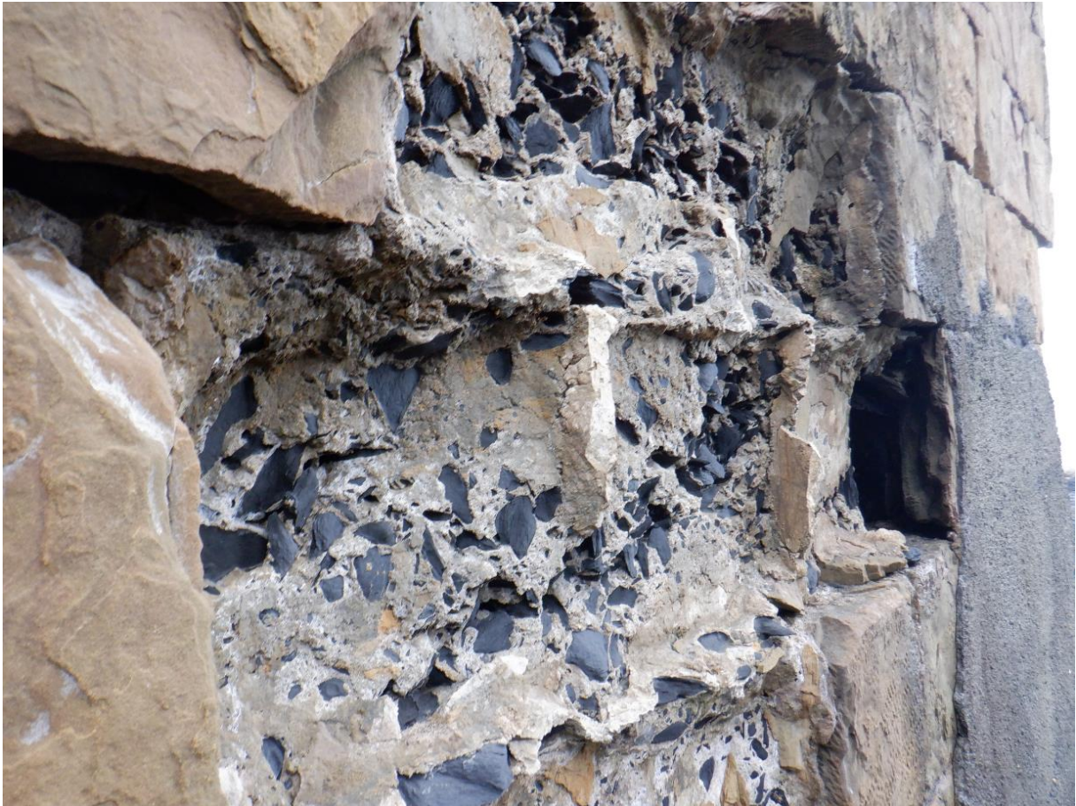
Figura 35. Aspecto interior de las pilas
