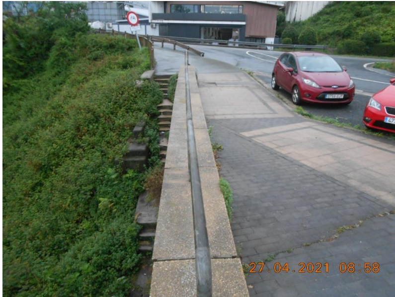
Figura 9. Acceso desde mirador a itinerario sobre emboquille
