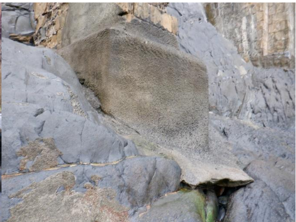
Figura 30. Detalle cimentación P9
