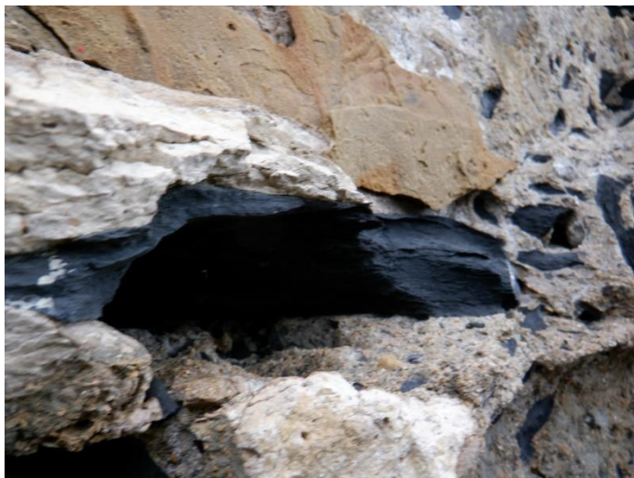
Figura 51. Cavidades en alzado (I)
