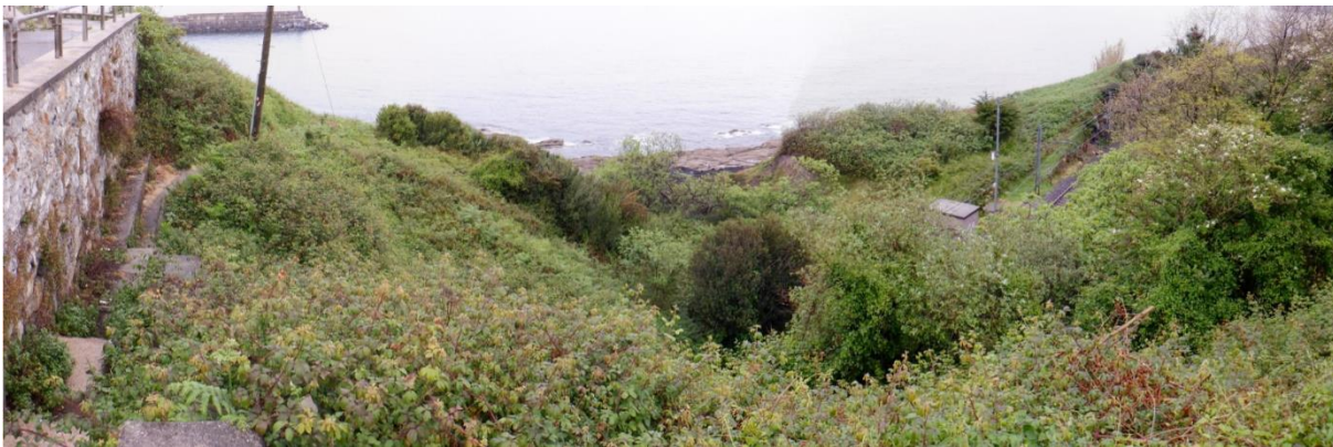
Figura 10. Panorámica desde acceso a camino sobre emboquille
