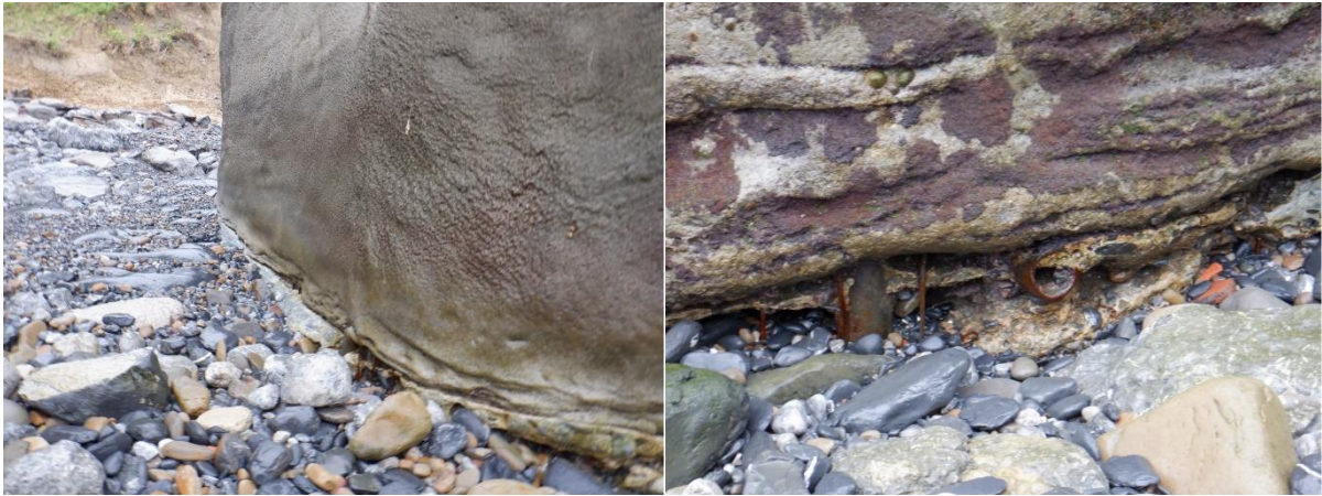
Figura 43. Armadura enresinada a terreno, en pila 5
