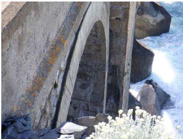
Figura 36. Bóveda de hormigón
