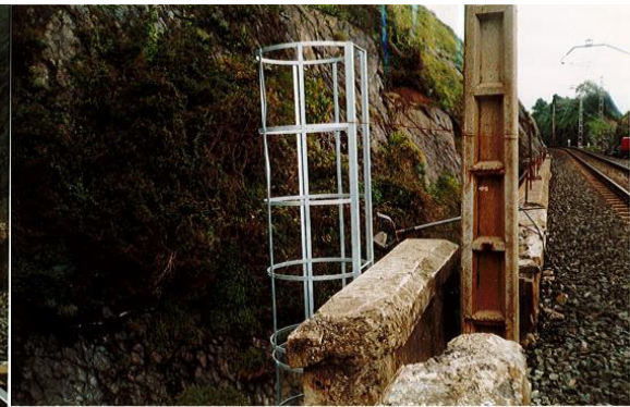
Figura 83. Escalera provisional de acceso en Estribo 2
