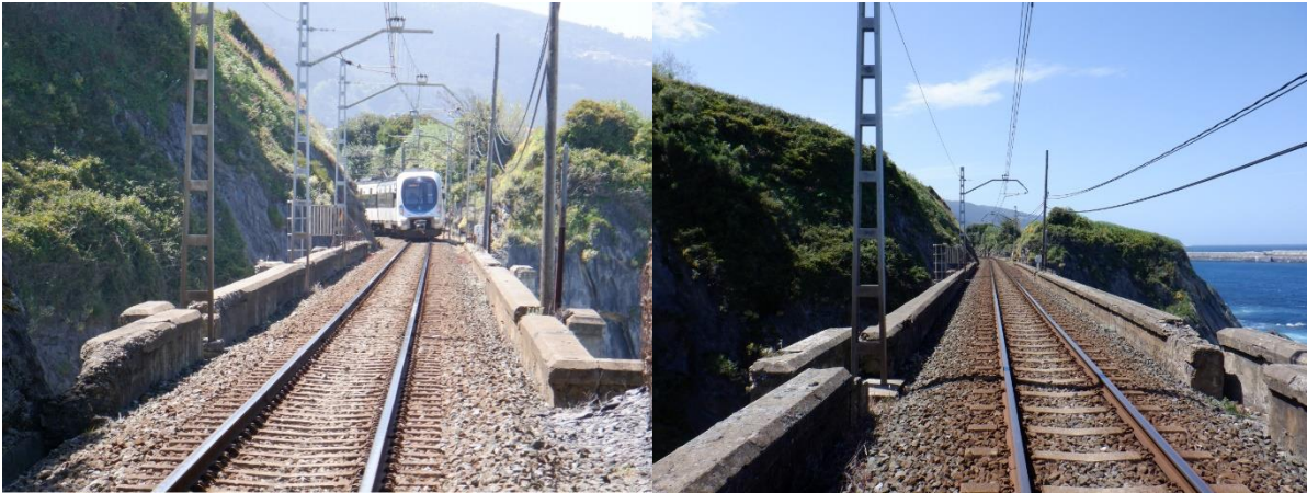
Figura 38. Vista desde tablero
