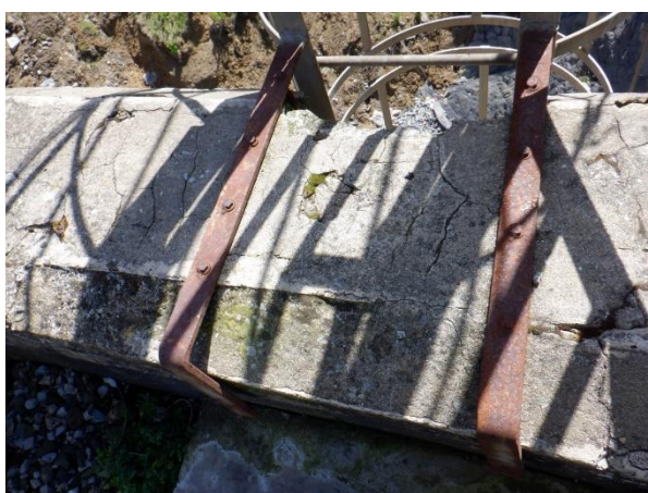
Figura 53. Unión en coronación
