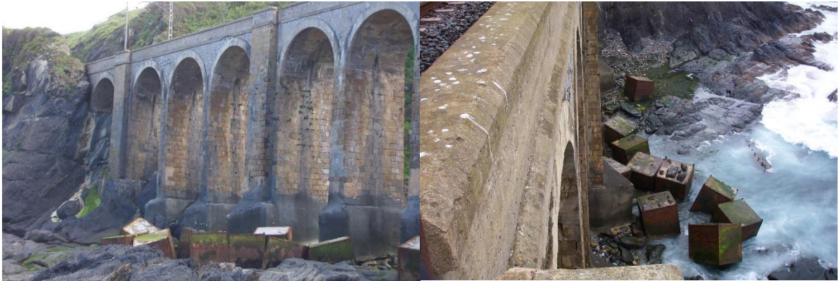
Figura 3. Cubos desplazados en 2003
