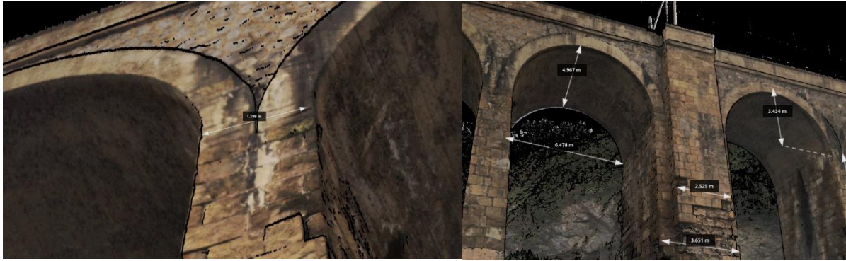
Figura 32. Acotación cabeza de pila
