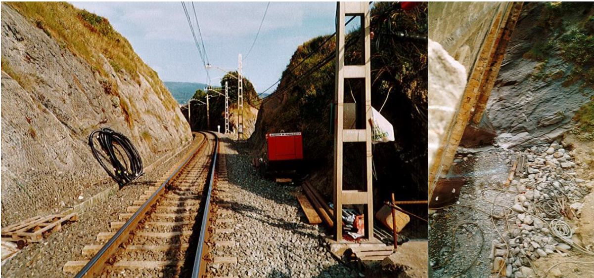
Figura 86. Acopios en plataforma
