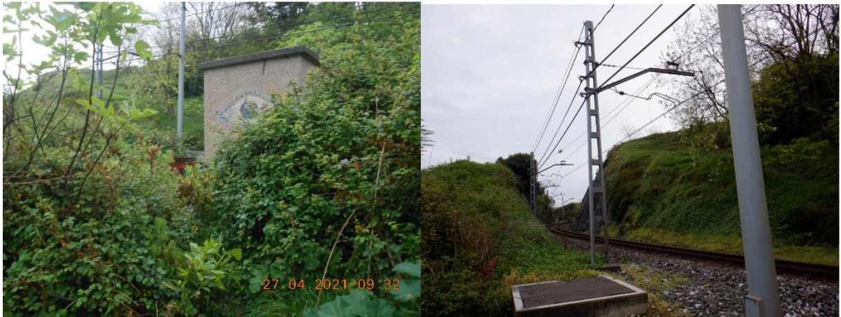
Figura 17. Acceso a plataforma
