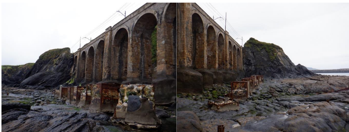
Figura 61. Aspecto de bloques frente al oleaje
