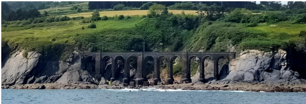
Figura 8. Ubicación viaducto de Lamiaran visto desde el mar
