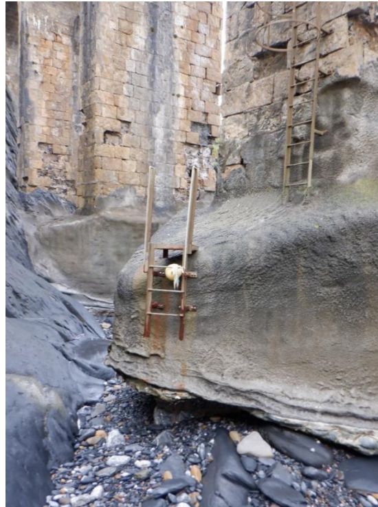
Figura 55. Escalera en canto de zapata
