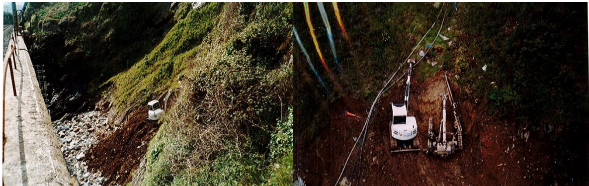
Figura 84. Excavación de refugio frente a pleamares de maquinaria
