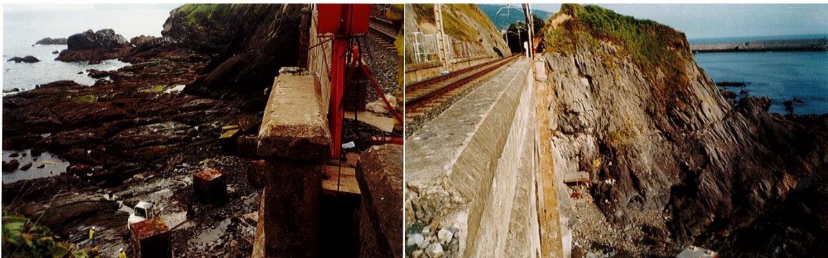
Figura 79. Polipasto eléctrico y plataforma de descenso de material
