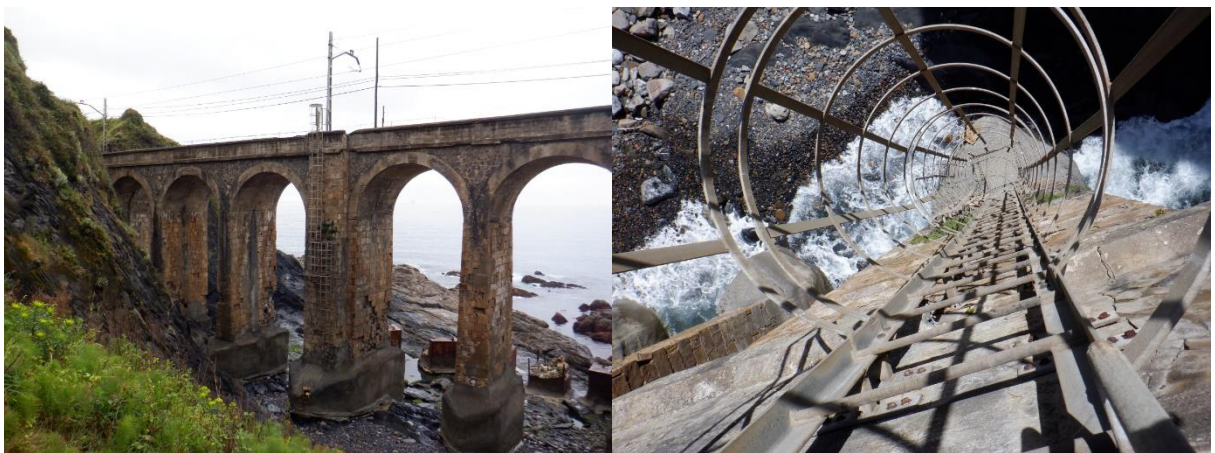
Figura 18. Escaleras acceso desde cala a plataforma
