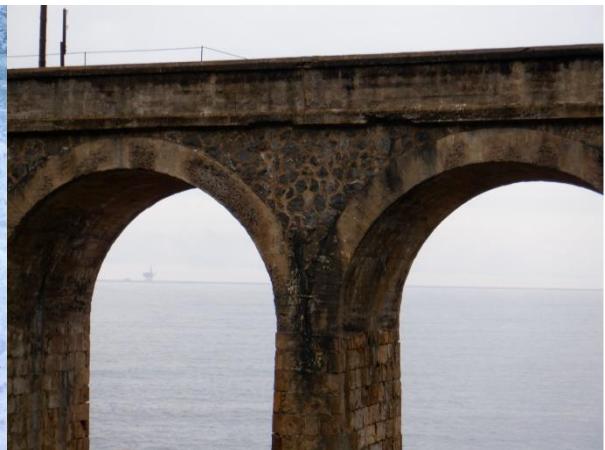
Figura 37. Bóveda y tímpanos
