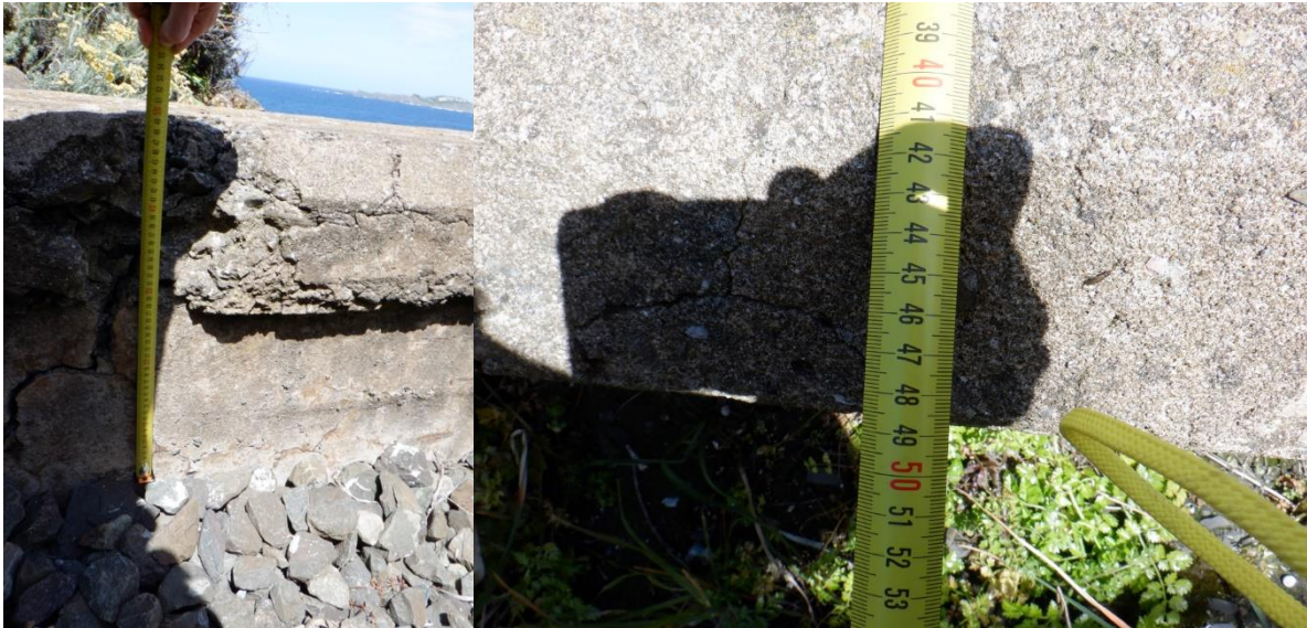
Figura 40. Acotaciones murete guardabalasto
