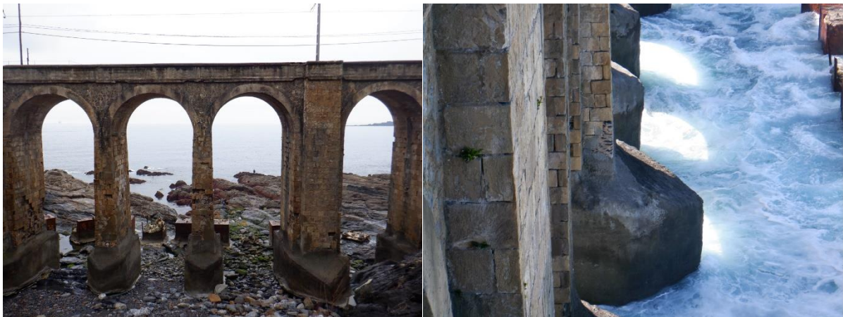
Figura 24. Cimentaciones alzados centrales
