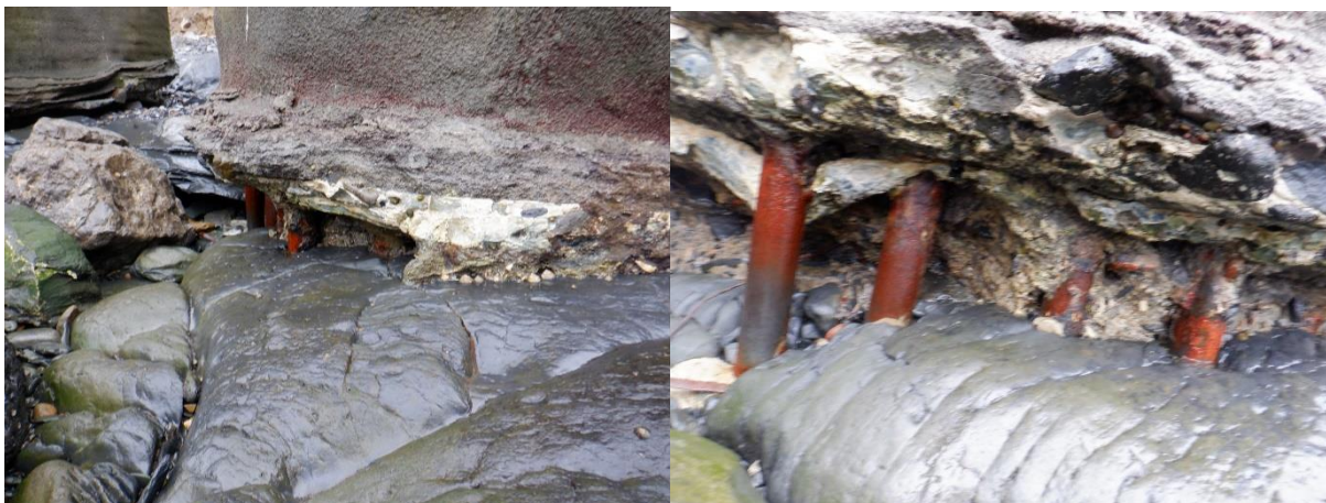
Figura 42. Micropilotes vistos en pila 6
