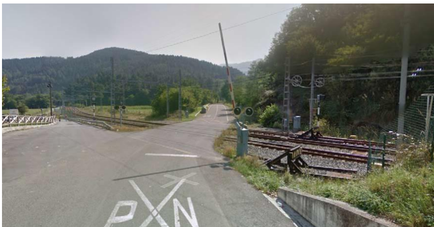
Paso a nivel existente a eliminar sobre la BI-4337
