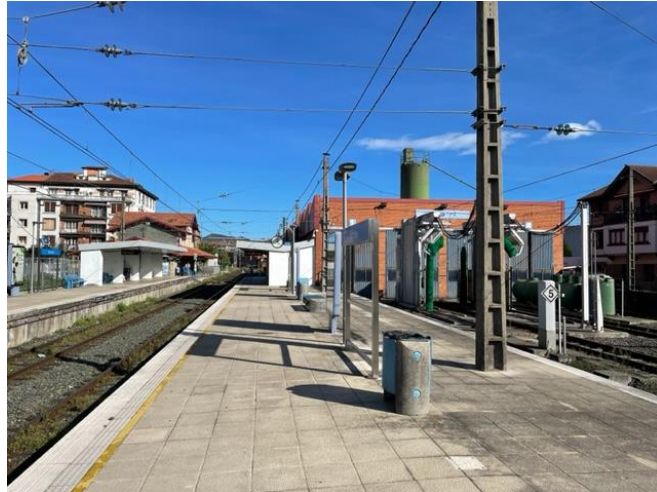
Imagen de los andenes de la estación tomada en dirección Norte. Se aprecia el andén sentido Bermeo a la izquierda y el andén sentido Amorebieta a la derecha.
