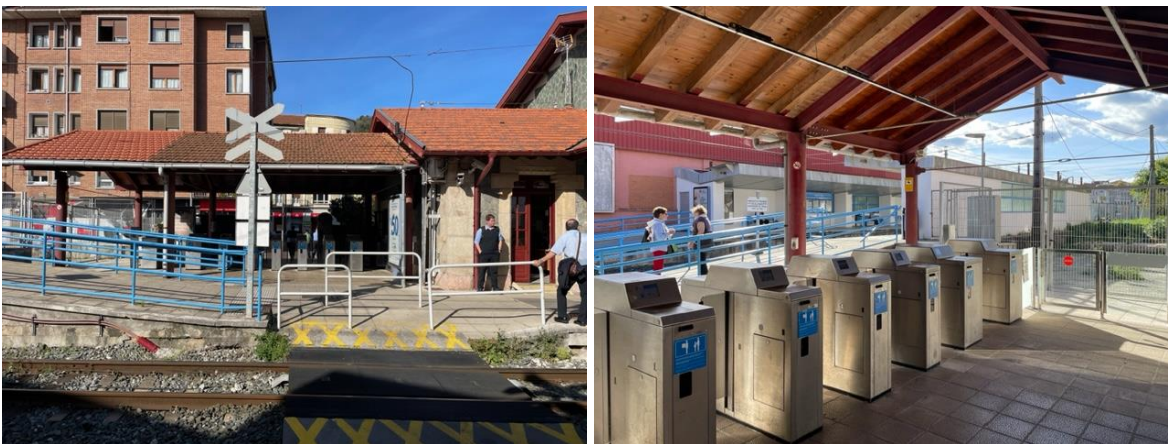
Imagen del paso a nivel entre andenes, alineado con la línea de cancelación de billetes y acceso desde la calle Loizaga. Se puede observar la marquesina o cubierta exenta que cubre y protege de la intemperie las canceladoras. También se observa en las imágenes la reciente ampliación de la cubierta.
