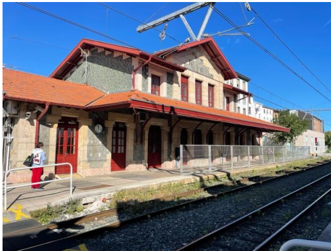
Vista de la fachada lado vías del edificio histórico de la estación de Gernika tomada desde el andén sentido Bilbao. Se observa el cierre parcial del antiguo andén y las puertas de acceso al mismo desde las dependencias de atención al público y del técnico de red de ETS.
