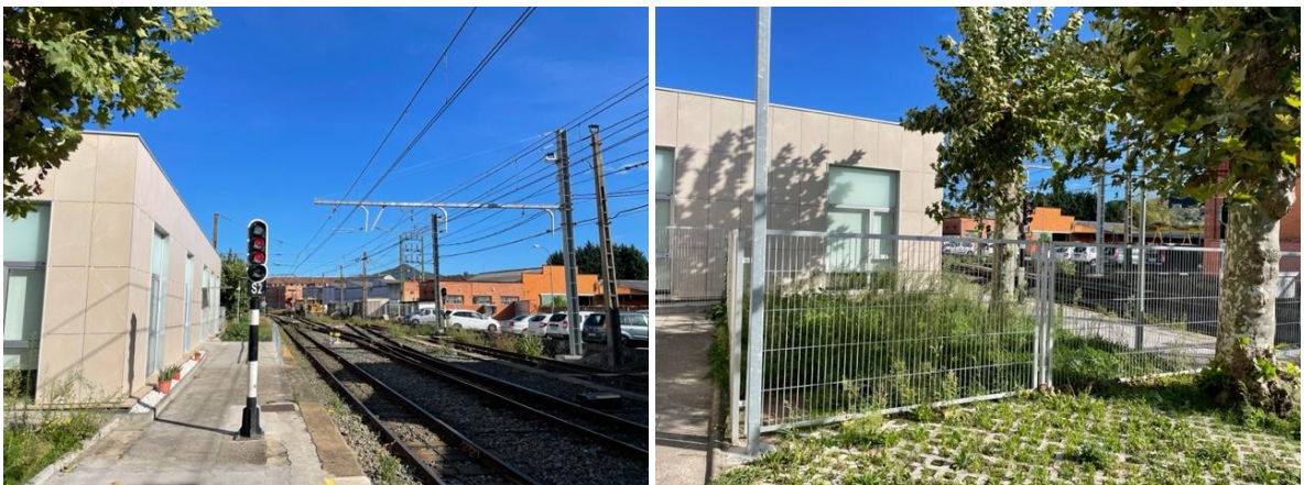
Vistas generales del edificio auxiliar
