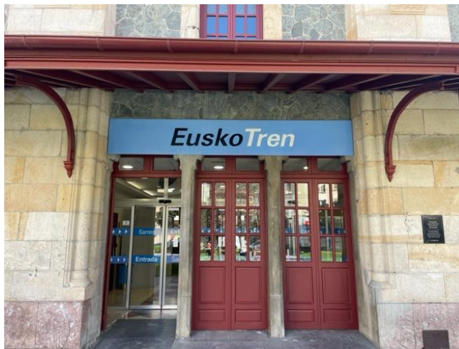
Vista de la puerta de acceso en la fachada principal del edificio histórico en la Plaza de la Estación. Dicha puerta de acceso está protegida por una marquesina con cubierta en pendiente, de estructura metálica y recogida de agua por canalón en borde de cubierta
