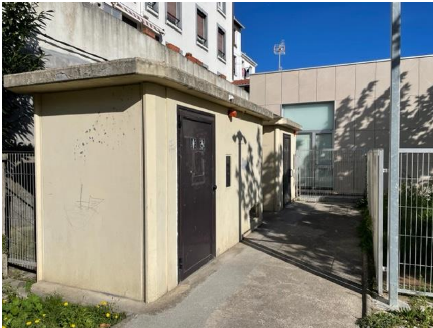
Foto 20. Locales situados en el espacio al Norte del edificio de estación y camino de acceso hasta ellos desde la Plaza de la Estación. Se trata de dos módulos que alojan servicios sanitarios públicos. Al fondo de la imagen el edificio auxiliar de la estación recientemente construido.
