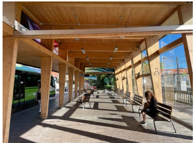
Fotos 7a y 7b. Imágenes del edificio exento de la estación de autobuses. Se observa que se trata de una estructura abierta en su mayor parte, compuesta de una sucesión de pórticos de madera. En el extremo Norte se realiza un cierre con paramentos de vidrio para protección de la intemperie de los pasajeros en espera.
