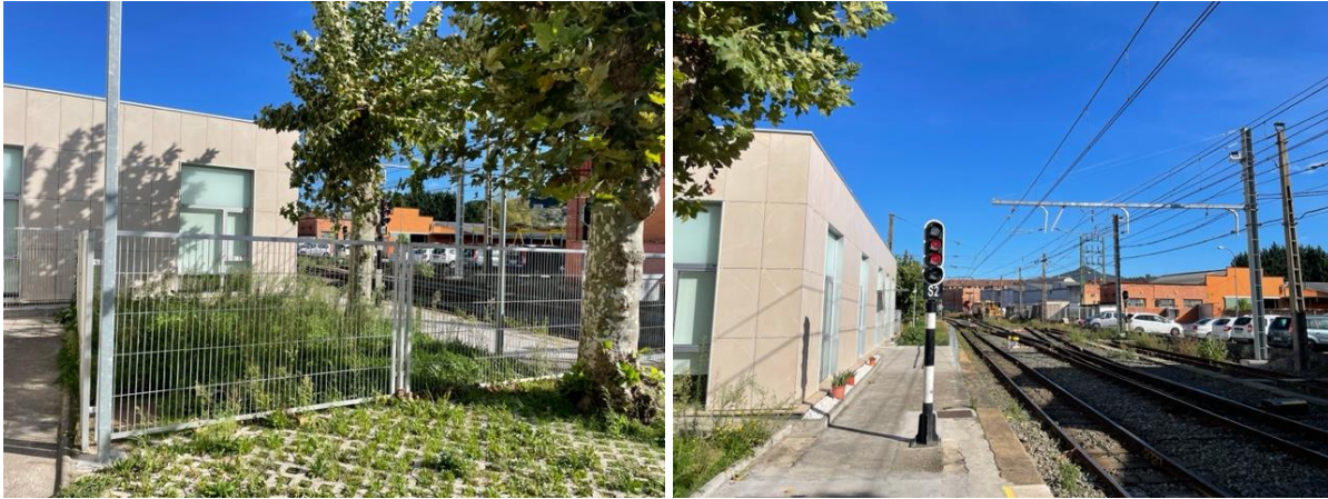
Fotos 18 y 19. Vistas del espacio existente al Norte del edificio histórico de la estación, situado entre la fachada Este de los edificios que bordean el lado Norte de la Plaza de la Estación y las vías. En esta ubicación se ha llevado a cabo la construcción del denominado edificio auxiliar de la estación, que acoge espacios destinados a vestuarios, estancia y descanso del personal laboral de ETS y Euskotren.
