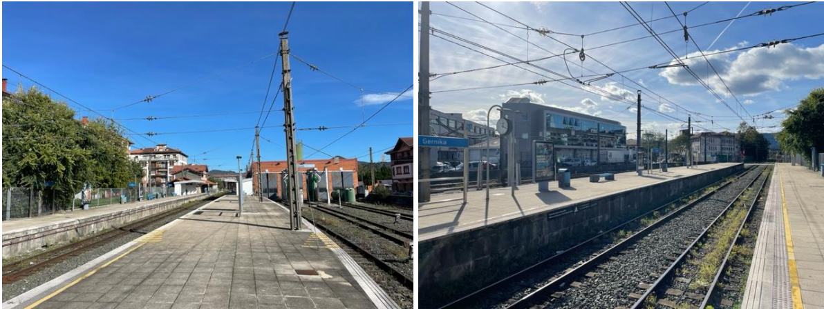
Fotos 30 y 31. Imágenes de los andenes actuales de la estación tomadas en dirección Norte (Bermeo), a la izquierda, y en dirección Sur (Amorebieta) a la derecha. Se aprecian los postes de los pórticos funiculares que sustentan la catenaria, tanto en la plataforma principal como en las vías de acceso a cocheras.
