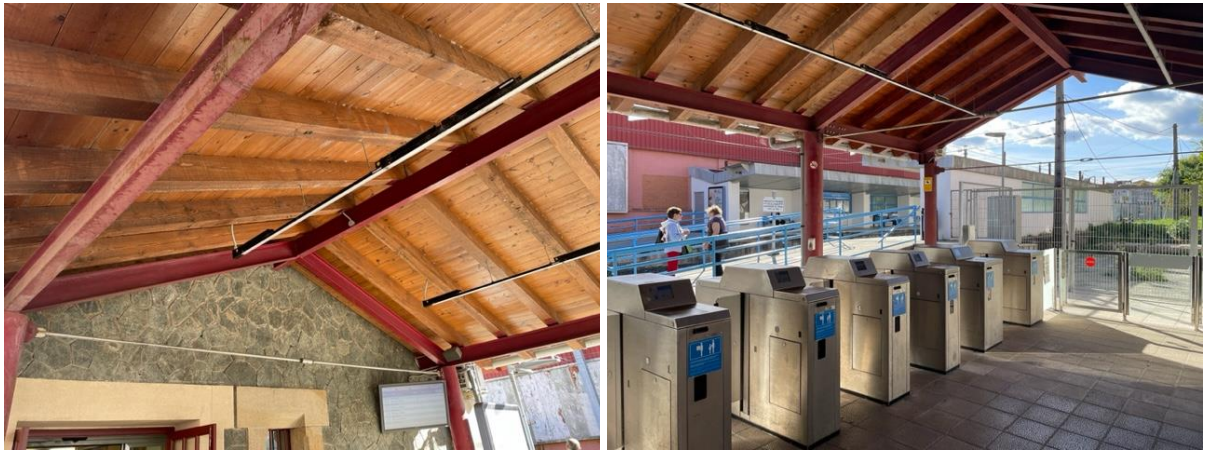
Fotos 14 y 15. Vistas de la cubierta que aloja la línea de cancelación que separa los espacios de bajo y fuera de control. En la imagen de la derecha se observa el solar que ocupaba el edificio de almacén demolido, así como la rampa de acceso a los andenes.
