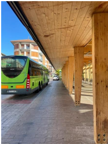
Fotos 7a y 7b. Imágenes del edificio exento de la estación de autobuses. Se observa que se trata de una estructura abierta en su mayor parte, compuesta de una sucesión de pórticos de madera. En el extremo Norte se realiza un cierre con paramentos de vidrio para protección de la intemperie de los pasajeros en espera.
