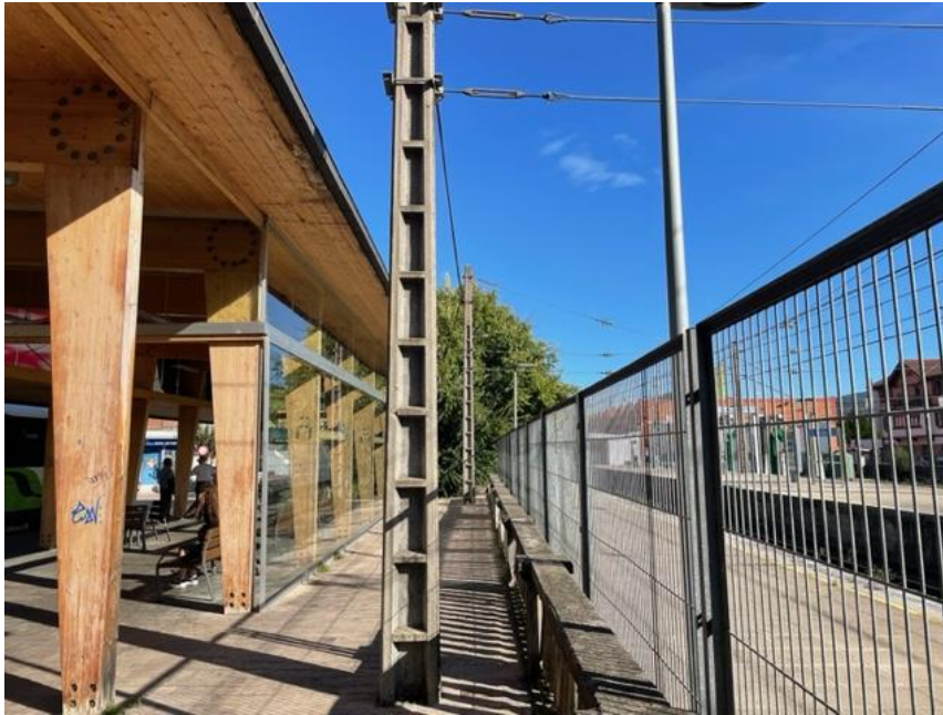
Foto 8. Vista de la zona trasera del edificio de la estación de autobuses. Se aprecia el cierre del espacio ferroviario contiguo.
