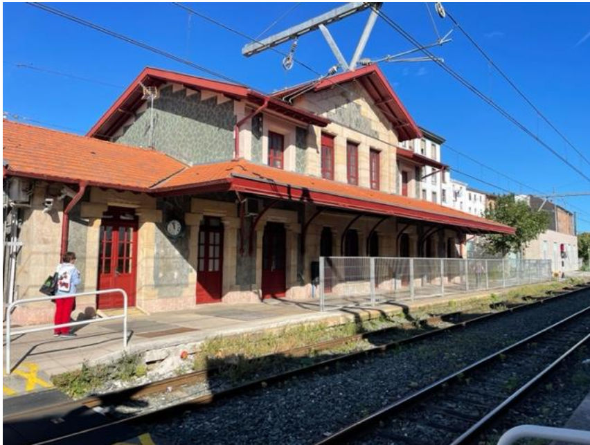
Foto 11. Vista de la fachada (Este); lado vías, del edificio histórico de la estación de Gernika tomada desde el andén sentido Bilbao. Se observa el cierre parcial del antiguo andén y las puertas de acceso al mismo desde el cuarto de atención al público y oficina del técnico de red de ETS. Fachadas y cubiertas rehabilitadas recientemente.
