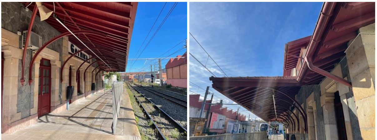
Fotos 22 y 23. Imágenes del antiguo andén contiguo al edificio histórico de la estación. El tramo de este andén aún visible se extiende de dicho edificio de estación hacia el Norte de la misma. El tramo de este andén fuera de control presenta un cierre en borde del mismo para impedir el acceso a la plataforma ferroviaria por seguridad. La imagen de la izquierda está tomada en dirección Norte (Bermeo) y la de la derecha en dirección Sur (Amorebieta-Bilbao). También se observa la marquesina de protección del andén original de la estación ya rehabilitada.
