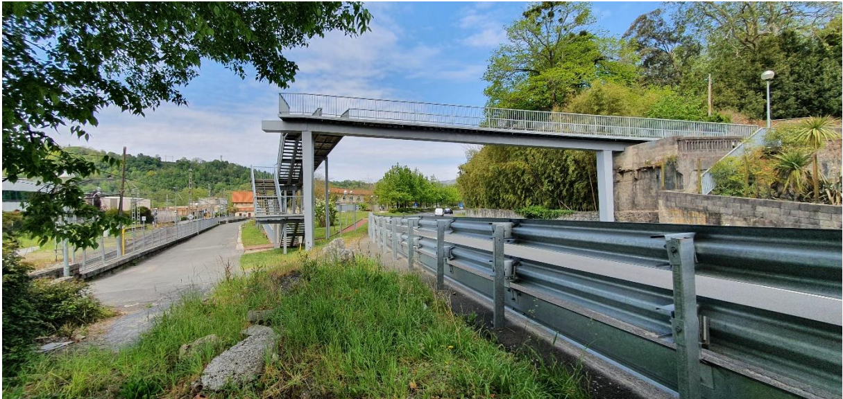
Figura 4. Vista pasarela sobre N-634 actual
