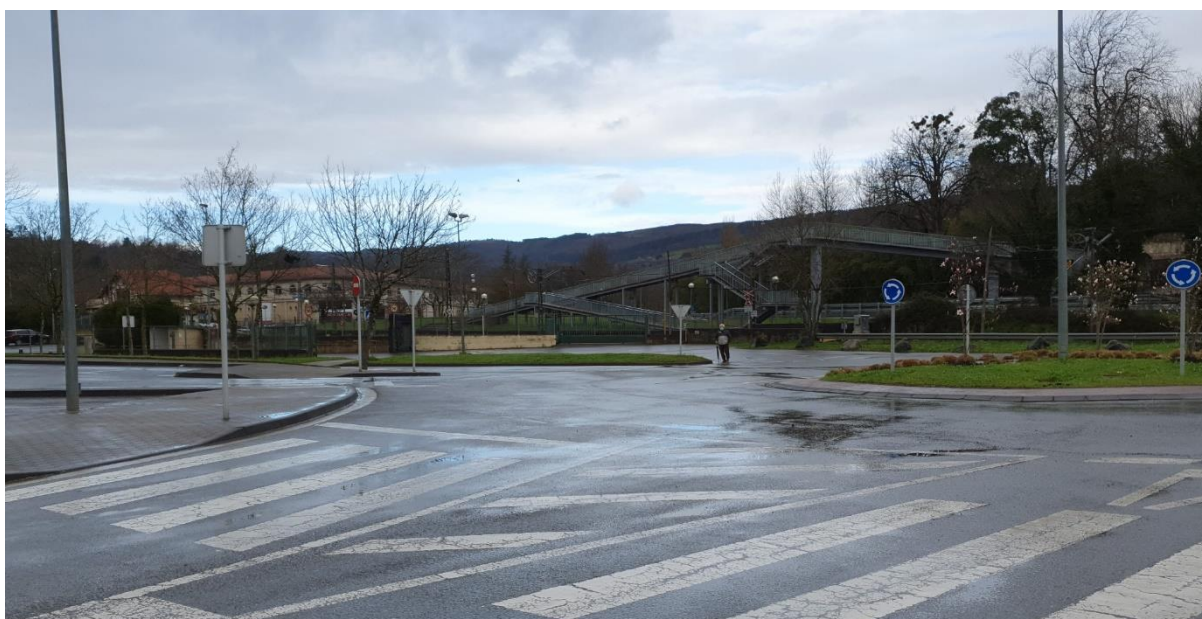
Figura 2. Vista general de la zona de actuación lado Sur
