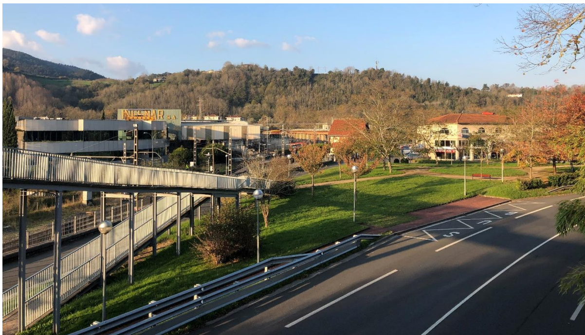
Figura 1. Vista general de la zona de actuación lado Norte
