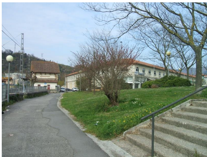
Fotografía 4. Camino hormigonado que se proyecta como zona verde
