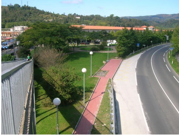
Fotografía 1. Perspectiva desde la pasarela.
