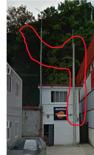
Línea de Iberdrola afectada
