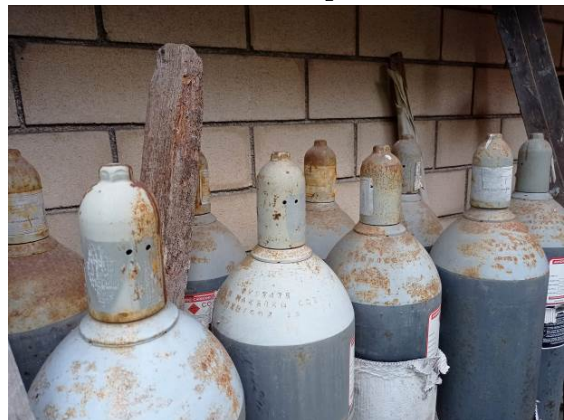
Bombonas de CO 2 en desuso.
