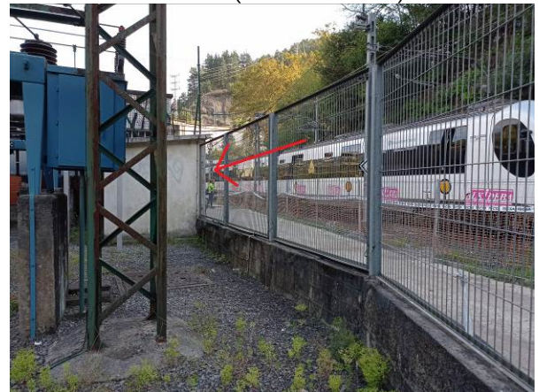
Anexo B (fachada este).
