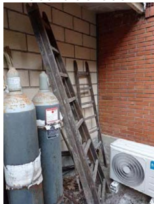
Escaleras, bombonas y salida de aire acondicionado.
