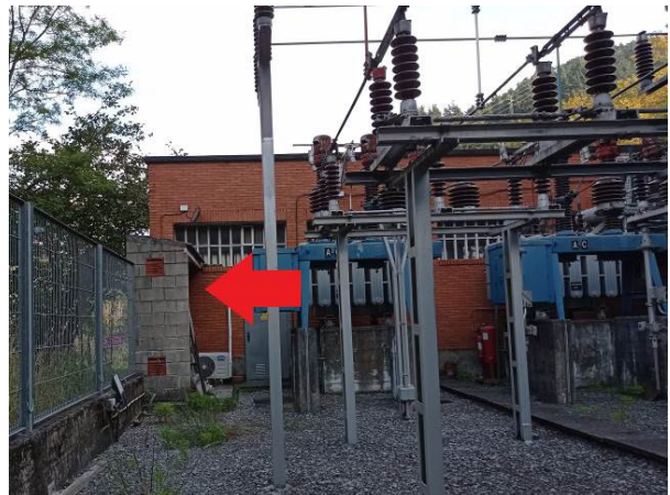
Foto 4. Aspecto del cobertizo D.
