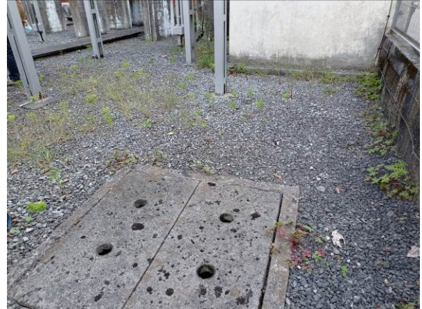
Arqueta de hormigón.
