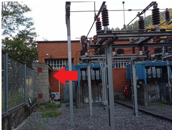
Estructura exterior del Cobertizo D.
