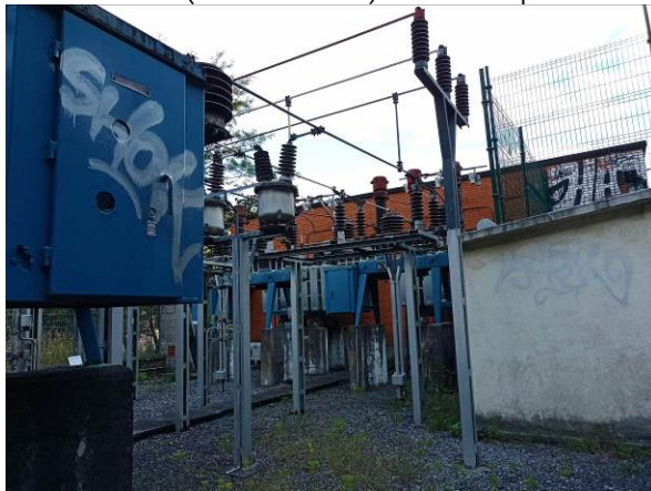
Anexo B (fachada sur) desde el patio.
