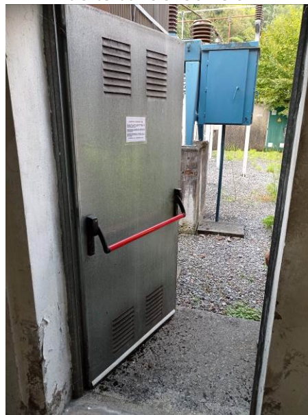
Puerta sur del edificio A
