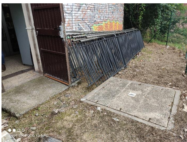
Fotografía 1. Localización y esquema de arqueta de FO existente (antes de ejecución obra SET móvil Maltzaga)
