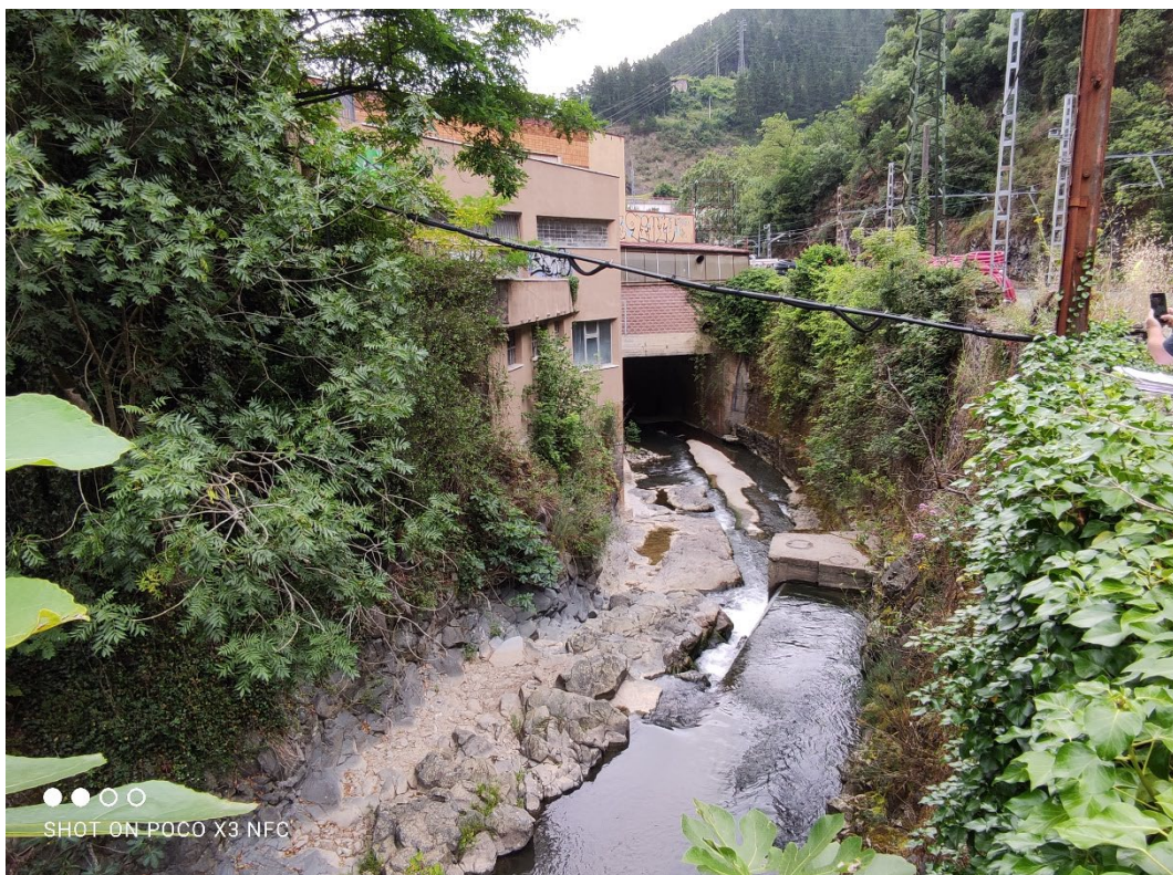
Fotografía 4. Río Ego y fábrica fuera de servicio junto a SET Maltzaga
