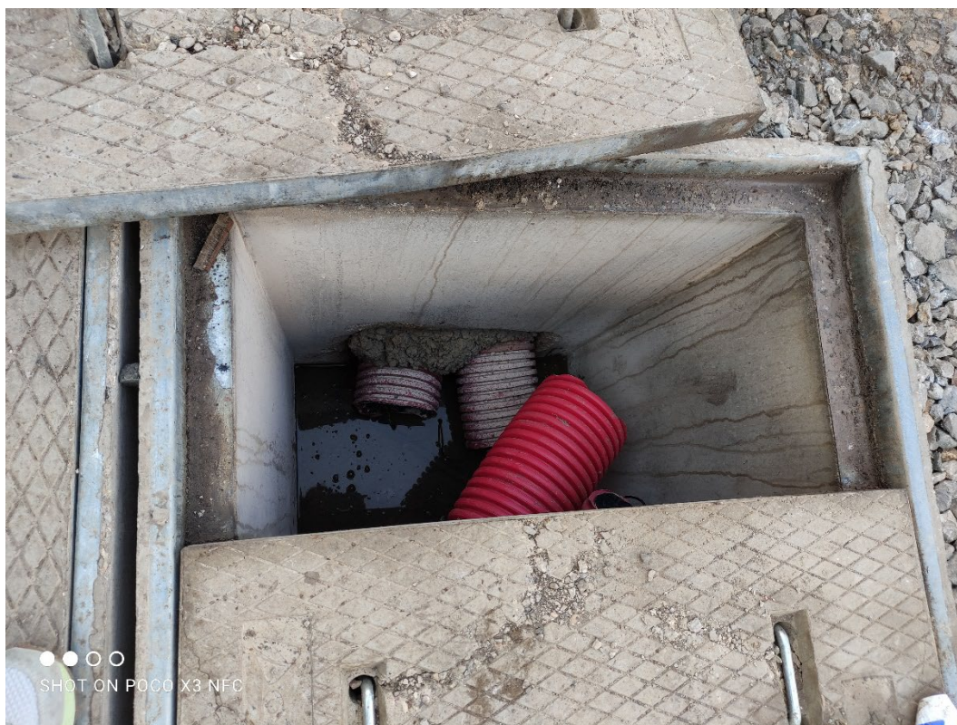
Fotografía 25. 2 nuevas arquetas junto a arqueta existente (3)
