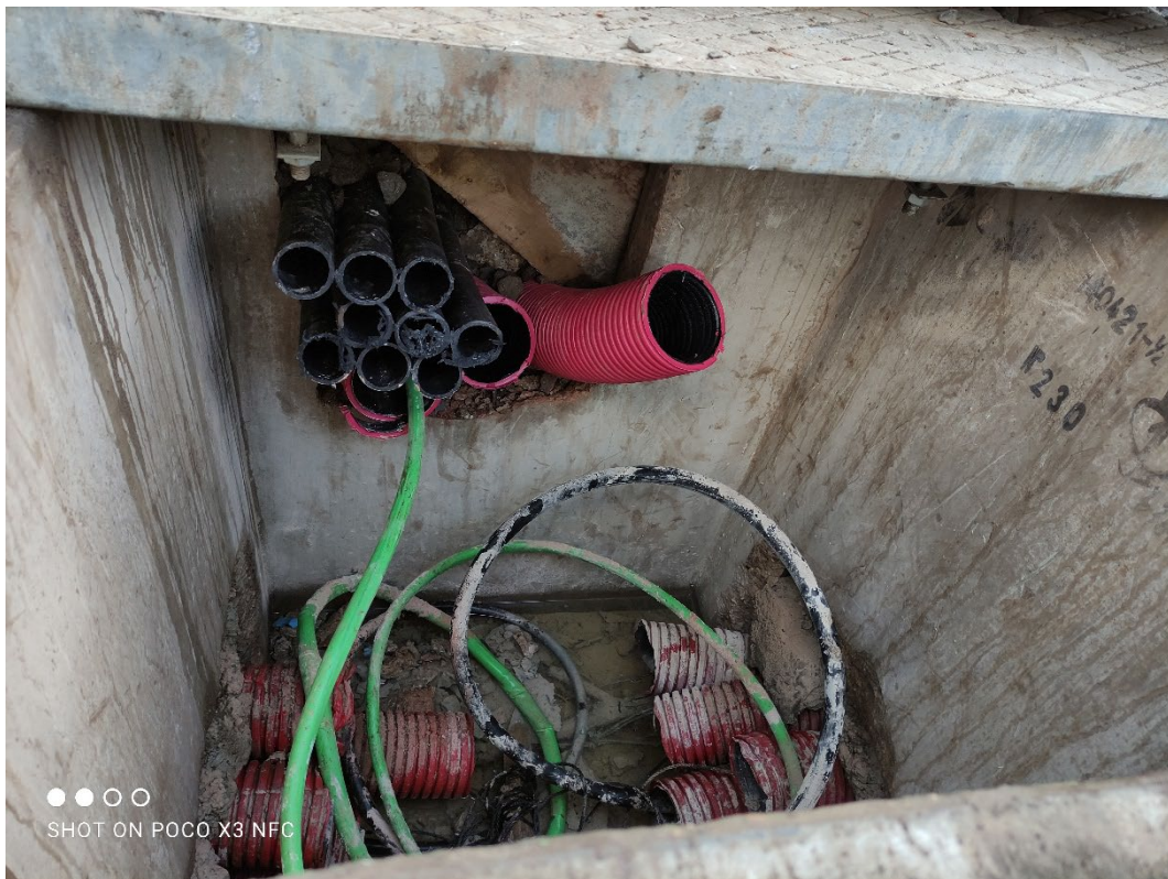
Fotografía 24. 2 nuevas arquetas junto a arqueta existente (2)
