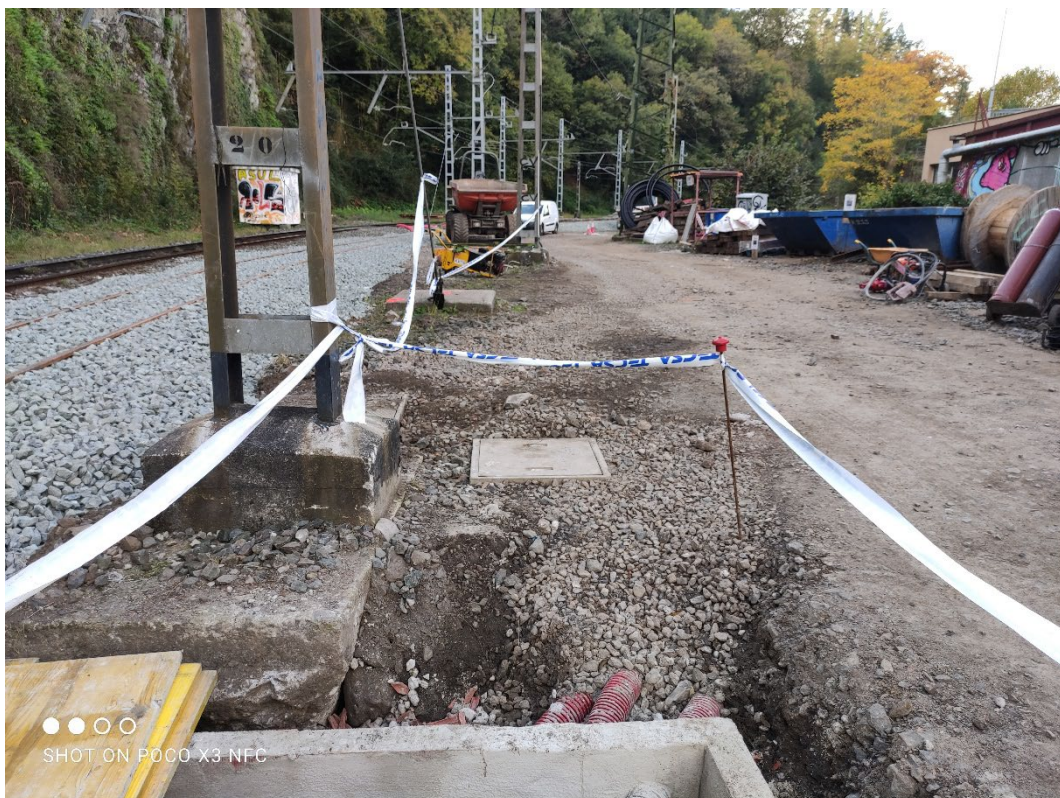
Fotografía 20. Nueva arqueta con tritubos FO (1)
