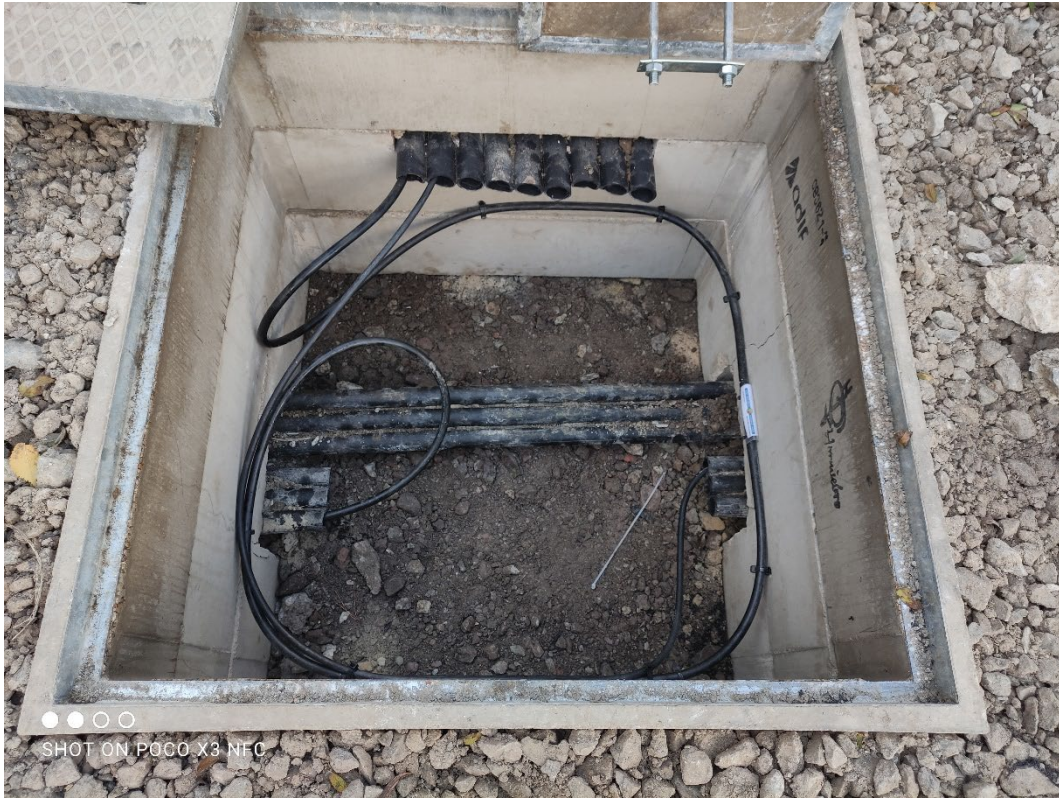
Fotografía 21. Nueva arqueta con tritos FO (2)
