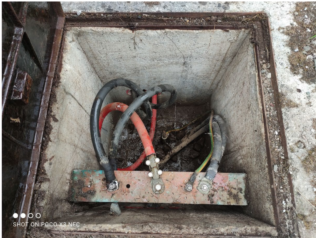
Fotografía 15. Pozo de negativos junto a vía
