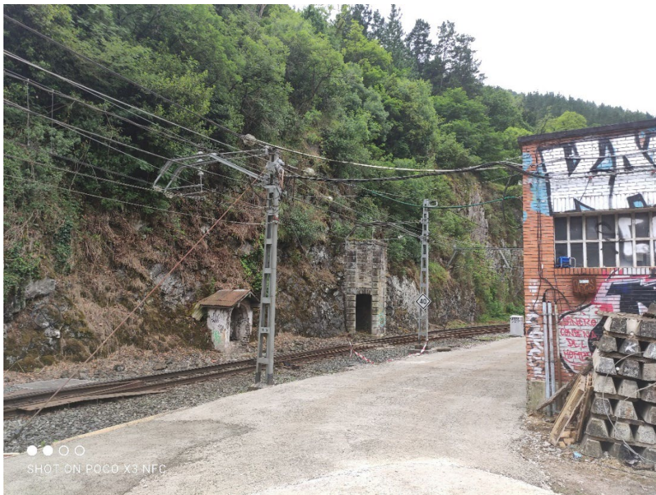
Fotografía 2. Vial acceso a playa de vías de Maltzaga
