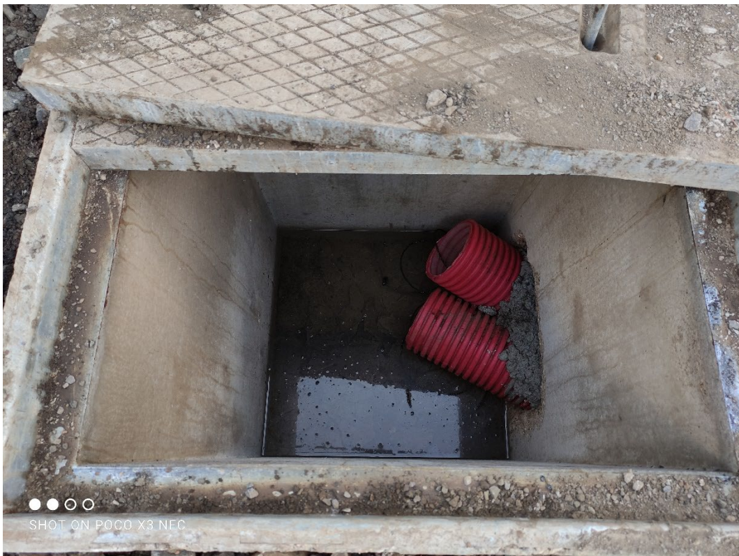
Fotografía 22. Nueva arqueta con 2 tubos 200 mm junto a poste 20
