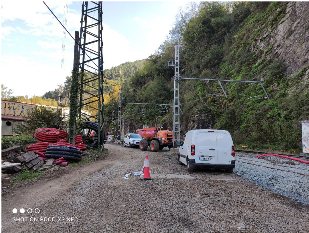
Fotografía 23. 2 nuevas arquetas junto a arqueta existente (1)
