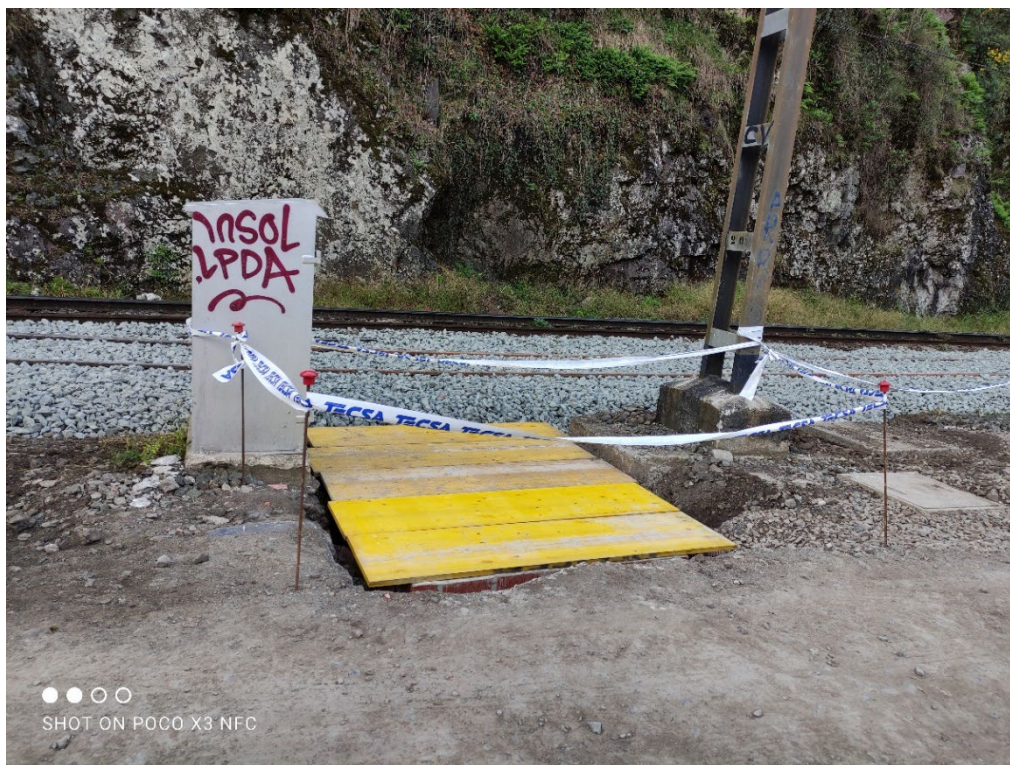
Fotografía 18. Recrecido arqueta junto a CR 3 kV (1)
