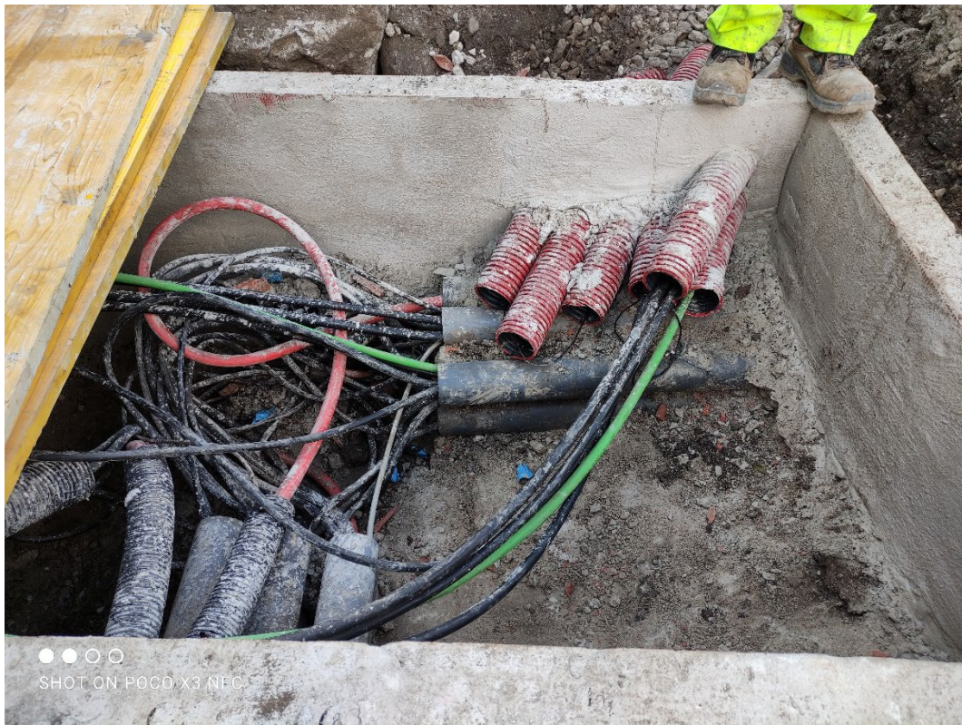
Fotografía 19. Recrecido arqueta junto a CR 3 kV (2)
