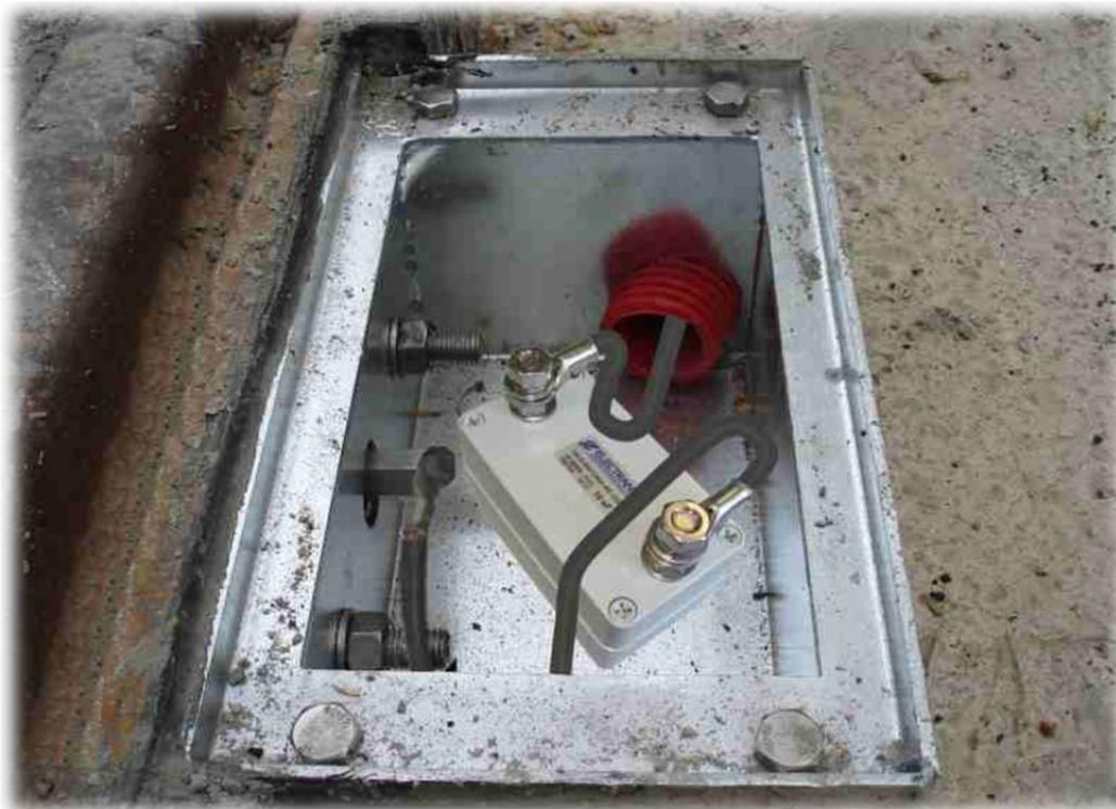
**Ilustración 4. Ejemplo de elemento de sintonía de circuito de vía**
