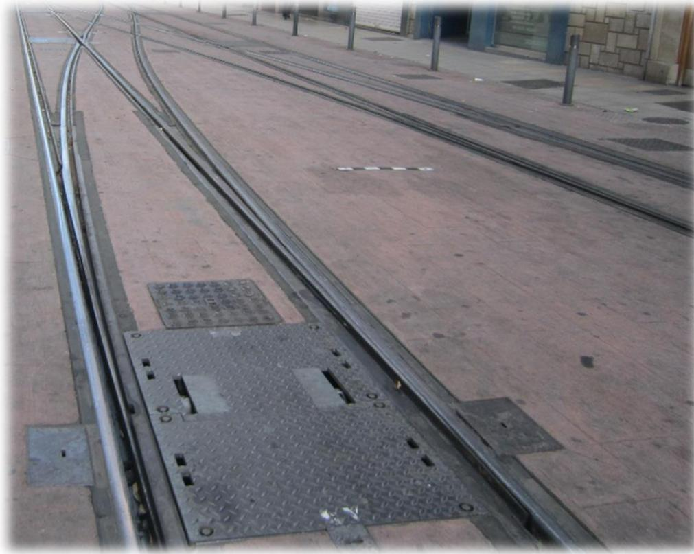
**Ilustración 9. Ejemplo de accionamiento tranviario embebido**
