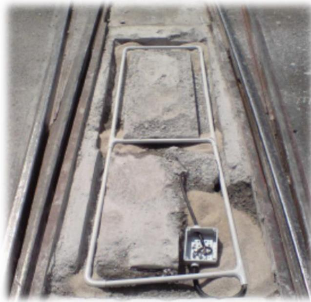
**Ilustración 6. Ejemplo de instalación de lazo tranviario**
