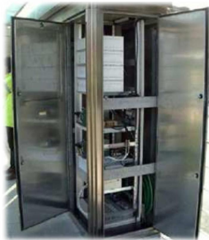
**Ilustración 12. Ejemplo de armario de enclavamiento en parada tranviaria**
