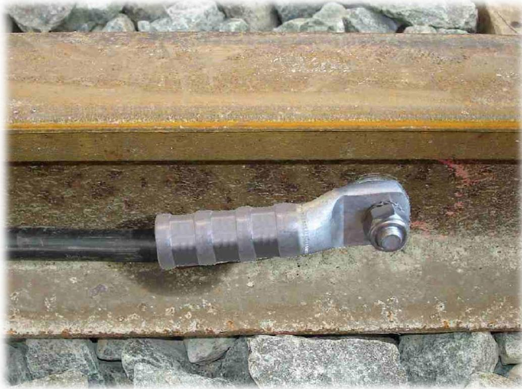
**Ilustración 5. Ejemplo de conexión a carril de circuito de vía**
