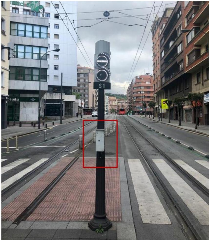
**Ilustración 8. Ejemplo de caja de botoneras de mando manual**
