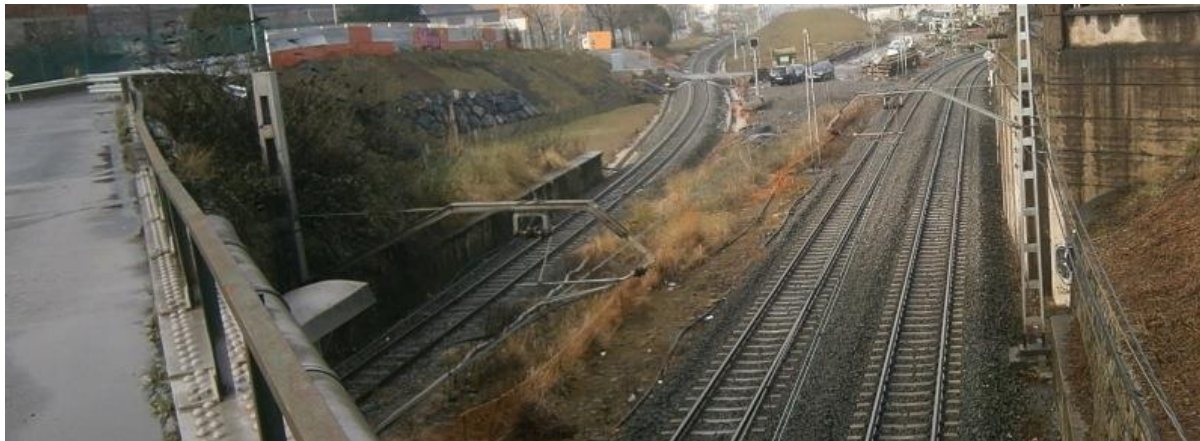
Foto 2. Vista del ramal de Aceralia con Paso a Nivel con señales electroacústicas y sin electrificación
