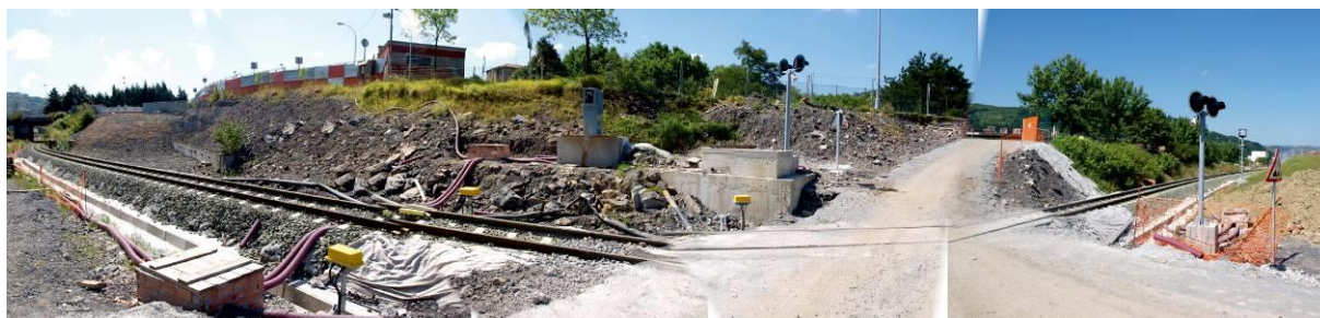
Foto 7. Paso a Nivel ramal aceraría.
