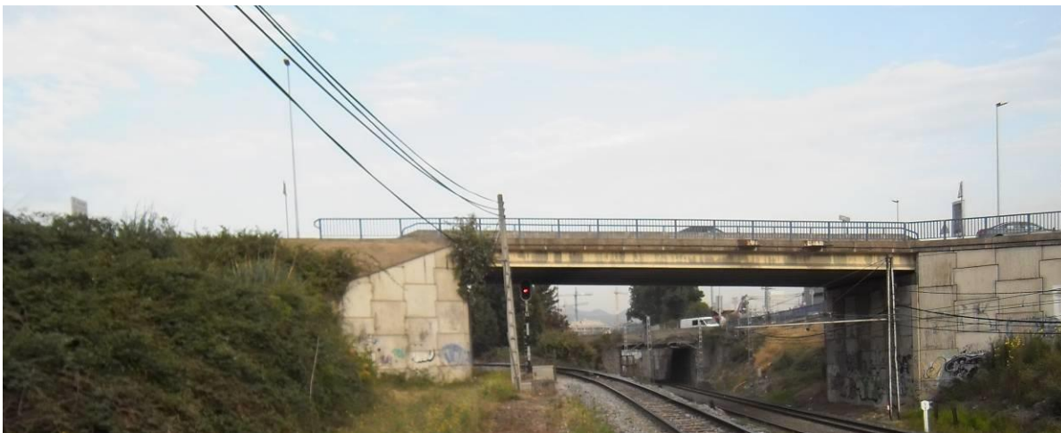
Foto 5. Señal S2 bajo viaducto
