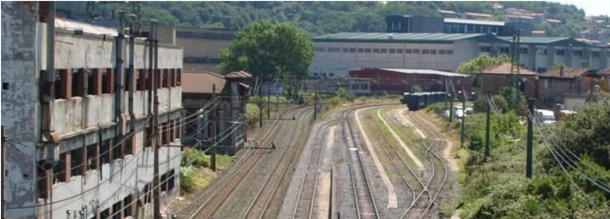
Foto 1. Vista subestación de Ariz, vías de ETS (izquierda), ramal de FEVE a Aceralia (centro) y playa de vías mercancías de FEVE
