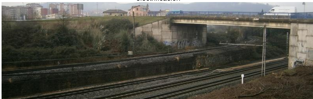
Foto 3. Ramal de feve en vía única desde La Peña sin electrificar. Cableado sobre postes de hormigón.
