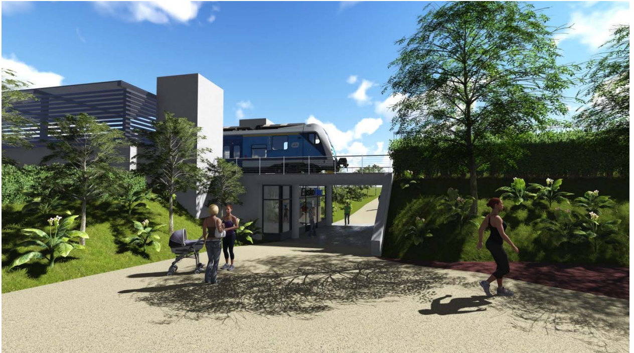
Acceso desde el lado norte. Imagen orientativa.
