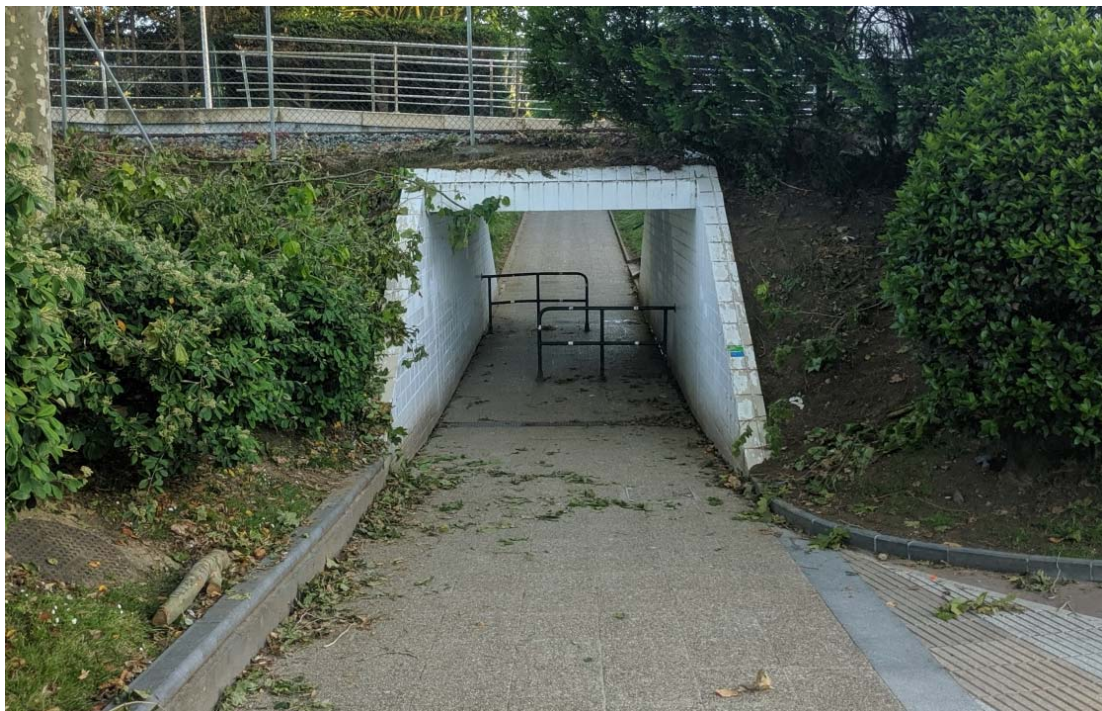
Paso inferior peatonal existente
