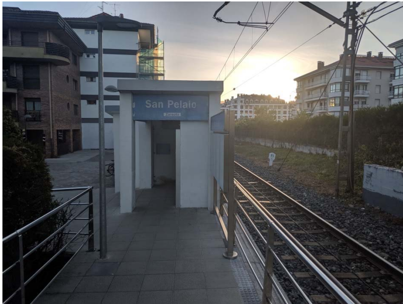
Acceso al apeadero desde el andén
