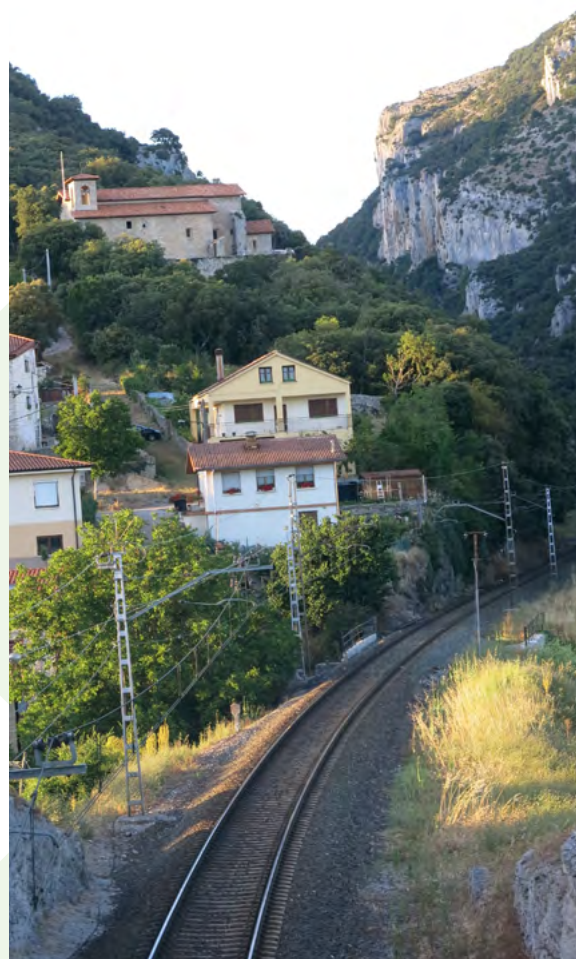
Infraestructura ferroviaria. Fuente: Gobierno Vasco
