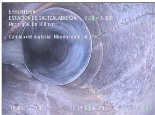
Fotografía: 4_4a, Nº Video: 0 5m, Cambio del material. Nuevo material (PVC)
