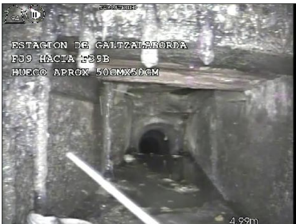
Fotografía: 7a, Nº Video: 0 0,7m, Llegada al punto deseado
