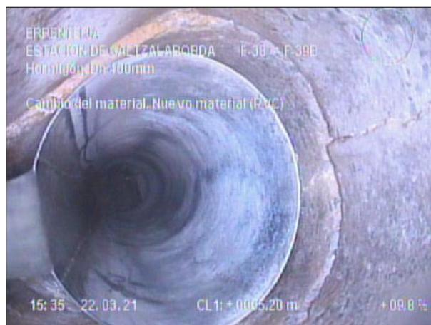
Fotografía: 4_4b, Nº Video: 0 5m, Cambio del material. Nuevo material (PVC)
