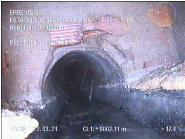
Fotografía: 2_2a, Nº Video: 0 2,1m, Pozo intermedio OCULTO
