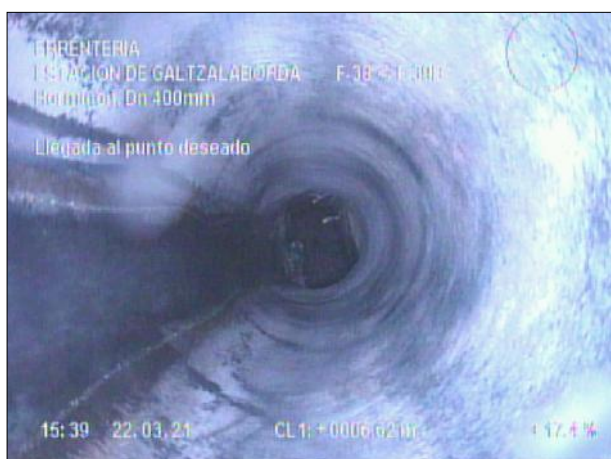
Fotografía: 5_5a, Nº Video: 0 6,6m, Llegada al punto deseado
