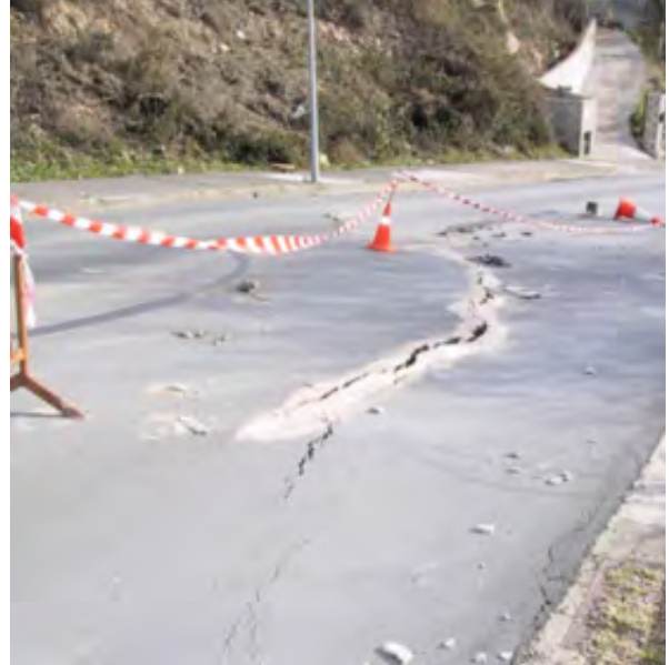
29. Irudia. Arrailak asfaltatutako errepide batean. Ikusten da arrailak konpondu arren berriz ireki direla.
