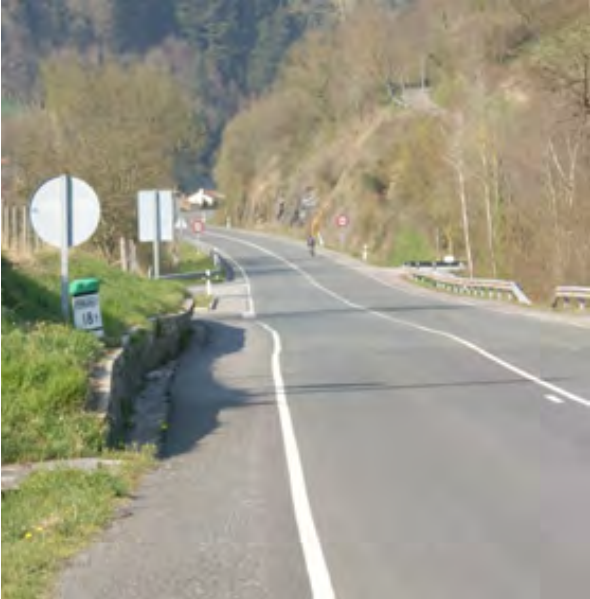
28. Irudia. Bazterbideko lerroa eta horma okertuta.
