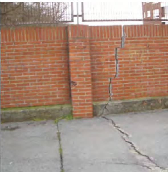
30. Irudia. Arrailak zoladuran eta adreiluzko horma batean.
