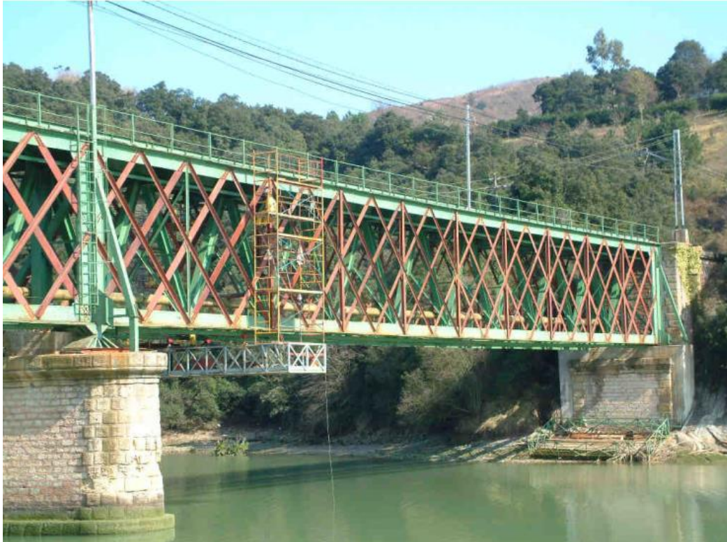
12. irudia. Jatorrizko profilen eta profil berrien tonalitate desberdinak. 2003ko sendotze-obrak.
