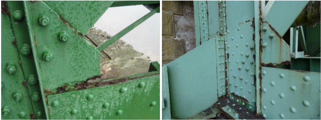
34. irudia. Berme-muntagaren lotura-kartela 2. estribuaren gainean, ibaian behera. Ezkerreko irudia 2011n hartua da, eta eskuinekoa 2020an.
