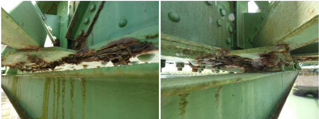
35. irudia. Diagonalaren eta beheko kordoiaren arteko lotura-kartelak 2. baiko 8. moduluan, sekzio-galera handiekin.
