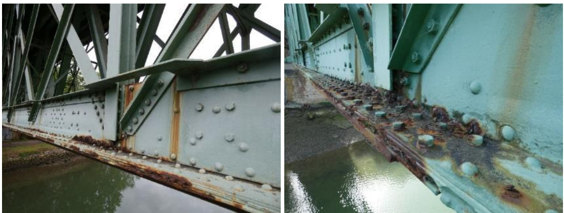
29. irudia. Korrosioak beheko kordoiaren arimaren eta hegalarren arteko lotunean. Ezkerraldean, 1. baako 8. modulua, ibaian gora; eskuinaldean, 2. baako 5. modulua, ibaian behera.
