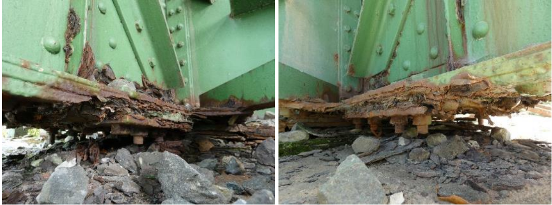
18. irudia. Herdoil-pilaketa alboko saretak bermatzeko aparatuetan, 2. estribuaren gainean.
