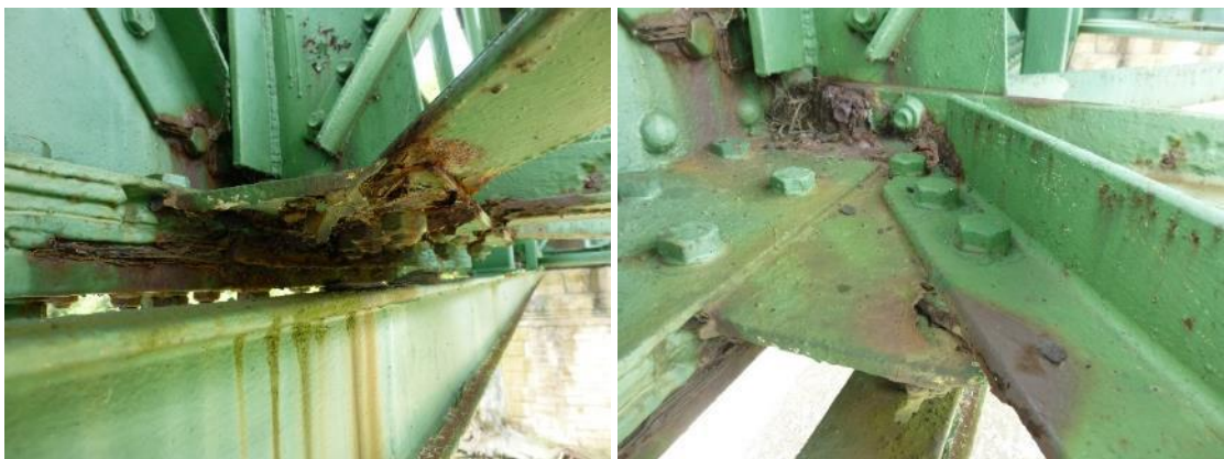
36. irudia. Diagonalaren eta beheko kordoiaren arteko lotura-kartela 2. baiko 7. moduluan, sekzio-galera handiekin.
