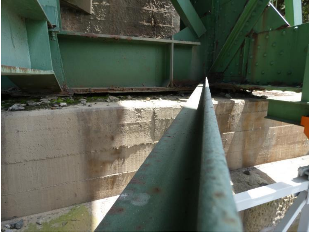
11. irudia. Hormigoizko habe etzana, erdiko sareta 2. estribuaren gainean bermatzeko.
