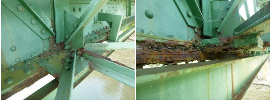
37. irudia. Diagonalaren eta beheko kordoiaren arteko lotura-kartela, aurrez sendotua, 2. baiko 6. moduluan, korrosio handiekin.
