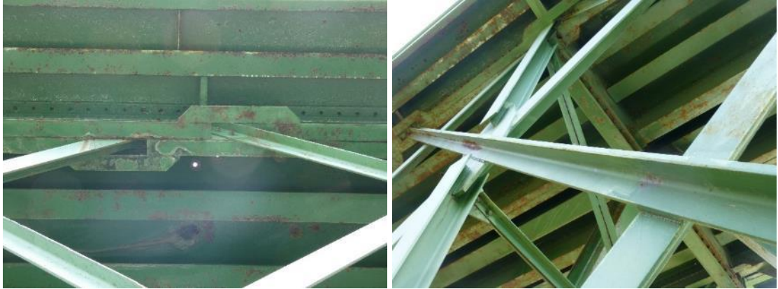
31. irudia. Gainazaleko korrosioa alboko saretetan. Ezkerraldean, 2. baoko 5. moduluaren goiko kordoia, ibaian gora. Eskuinaldean, 2. baoko 8. moduluaren diagonala, ibaian behera.
