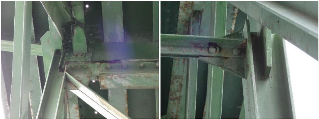
44. irudia. Korrosio puntualak goiko zeharkako habeetan, ezkerrean, eta tarteko tirantean, eskuinean, 1. baoko 9. moduluan.
