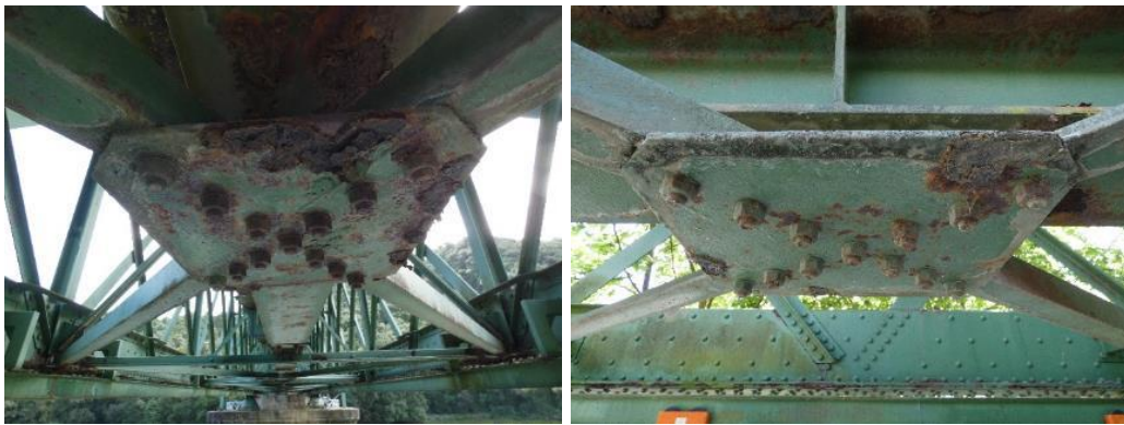
38. irudia. Diagonalen gurutzaguneko kartela gainazaleko korrosioekin, hidroxido-paketa puntualen batekin batera. Ezkerrean, 1. baiko 6. modulua eta, eskuinean, 1. baiko 2. modulua.
