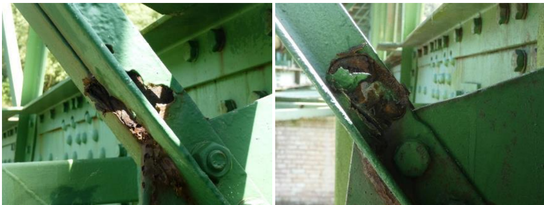
41. irudia. Korrosioaren ondoriozko zuloak dituzten diagonalak beheko kordioarekiko lotunean. Ezkerrean, 2. baiko 6. modulua eta, eskuinean, 1. baiko 5. modulua.
