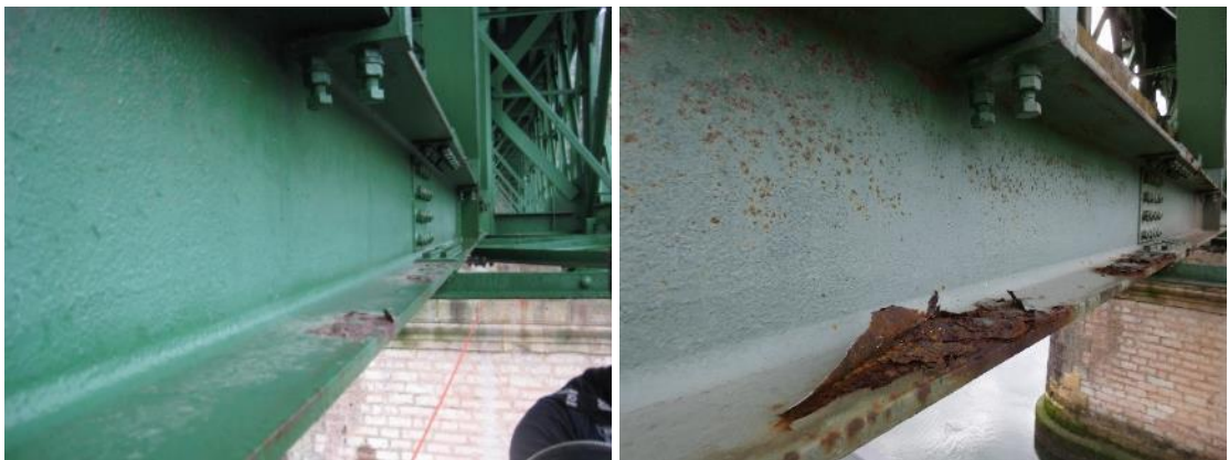
24. irudia. 1. baiko 8. moduluaren beheko kordia. Ezkerreko irudia 2011n hartua da, eta eskuinekoa 2020an.
