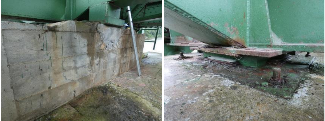
20. irudia. Ezkerraldean, hormigoizko emendatzea, 1. pilaren gainean ekialdeko aurpegian altxatuak dituela. Eskuinaldean, neoprenoaren xafla perimetralak hidroxido-paketeekin.
