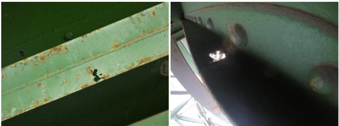
48. irudia. Korrosioaren ondoriozko zulo puntualaren xehetasuna, 1. baiko 3. moduluko lauza ortotroparen luzetarako zurrungailuan.
