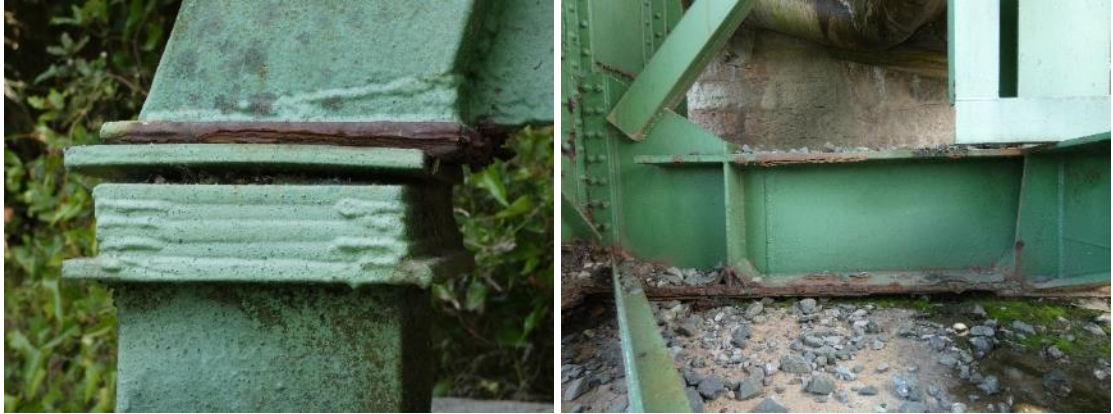
46. irudia. Ezkerrean, berme-falta goiko kordoiaren txarrantxan edo eskoran, 2. estribuan, ibaian beheara. Eskuinean, korrosioak, hidroxido-paketeekin batera, 2. estribuaren beheko zeharkako habean, ibaian beheara.
