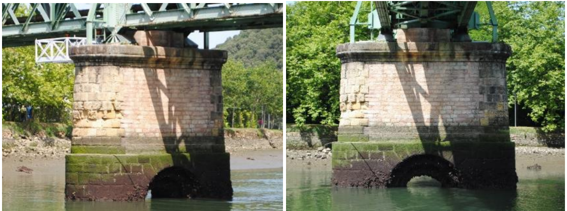
19. irudia. Ezkerraldean, material-galera hegoaldeko zubi-branka erdizirkularren harlanduetan, baita hareatzea ere goiko harlanduetan. Eskuinaldean, patina biologikoak, patina beltzak eta hezetasunak pilaren ekialdean.
