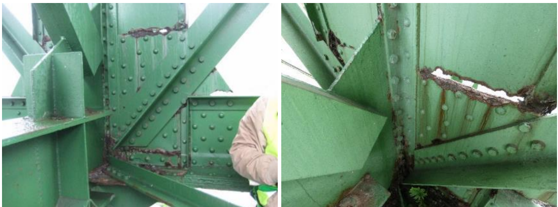
33. irudia. Berme-muntaga 1. pilaren gainean, ibaian behera. Ezkerreko irudia 2011n hartua da, eta eskuinekoa 2020an.
