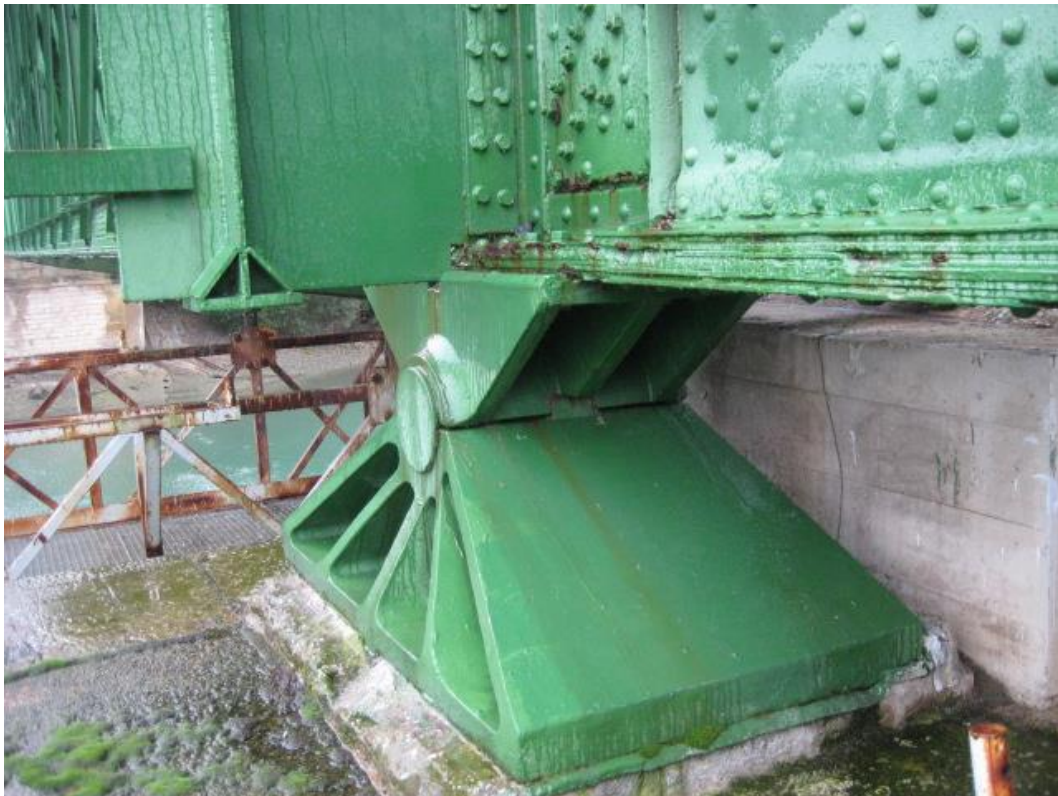
8. irudia. 1. pilako ezkerreko berme-aparatu.
