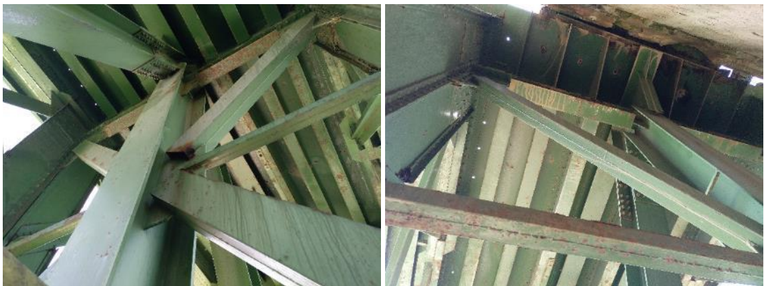
45. irudia. Pilaren zeharkako txarrantxak, ezkerrean, eta 2. estribua, eskuinean, gainazaleko korrosioekin.
