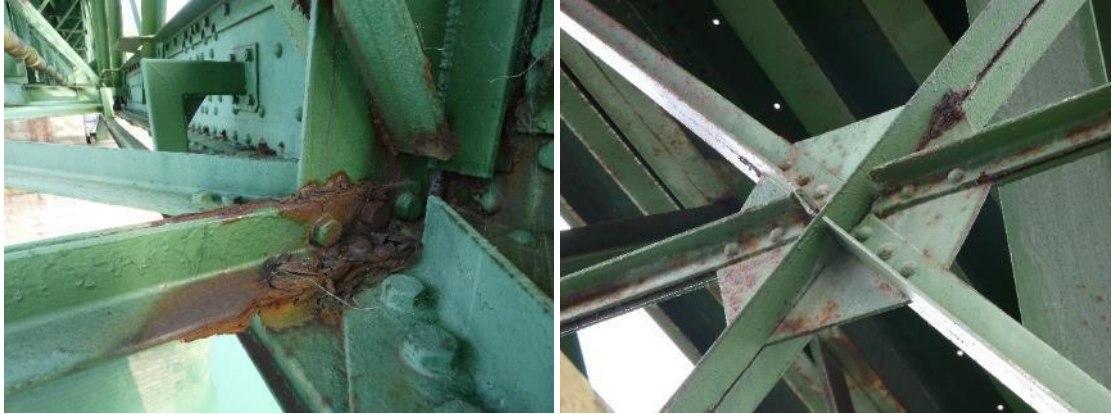
43. irudia. Korrosioak txarrantxa-sistema bertikalaren lotura-karteletan. Ezkerrean, beheko kordioarekiko lotura-kartela, 2. baoko 3. moduluan, eta, eskuinean, erdiko lotura-kartela, 1. baoko 8. moduluan.
