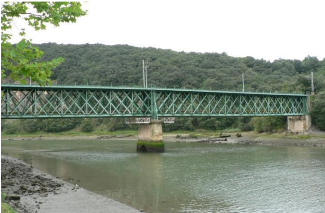
Figura 2. Alzado derecho desde margen izquierda.
