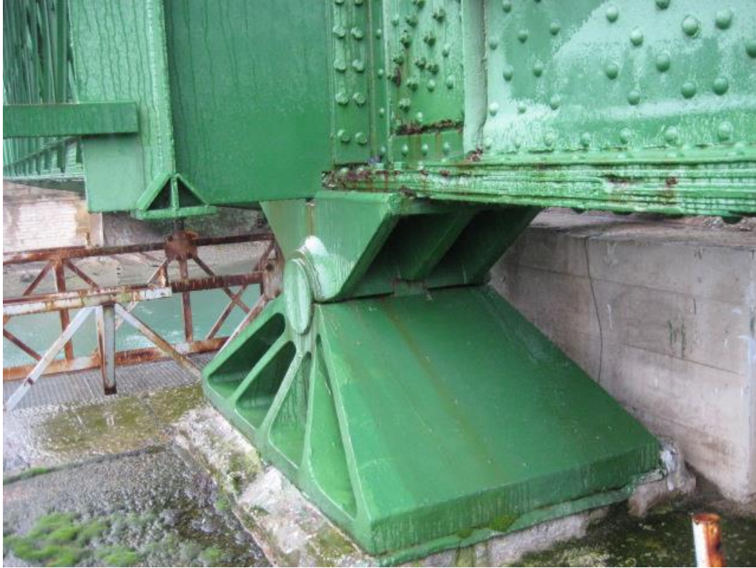
Figura 8. Aparato de apoyo izquierda de pila 1.
