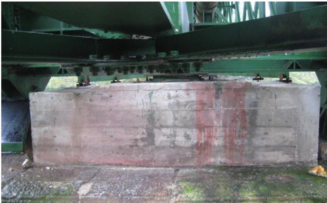
Figura 7. Cargadero de hormigón de pila 1 desde vano 2.
