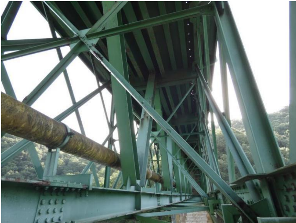
Figura 10. Vista de la celosía central ejecutada según el proyecto de reparación de 1989.
