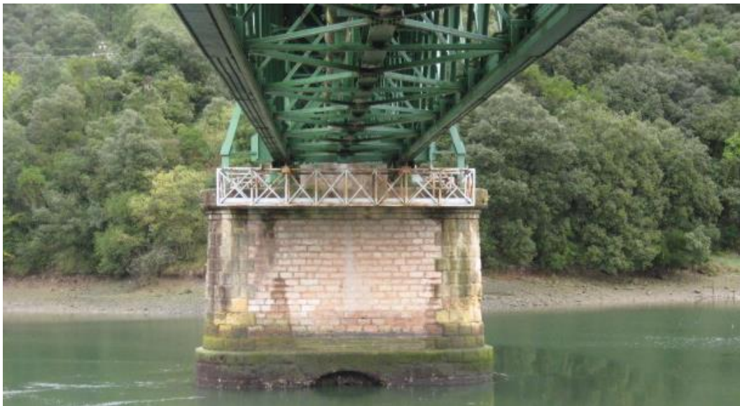
Figura 5. Alzado de pila 1 desde estribo 1.
