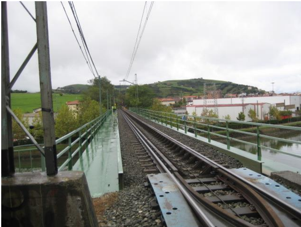
Figura 9. Vista de la plataforma en sentido PK decreciente desde el estribo 2.
