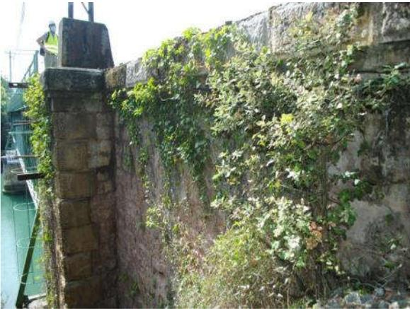
19\_ muro en vuelta aguas arriba con vegetación enraizada
