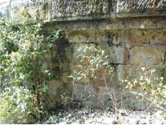
18\_lavado de juntas, vegetación enraizada y pátina biológica en muro en vuelta aguas arriba
