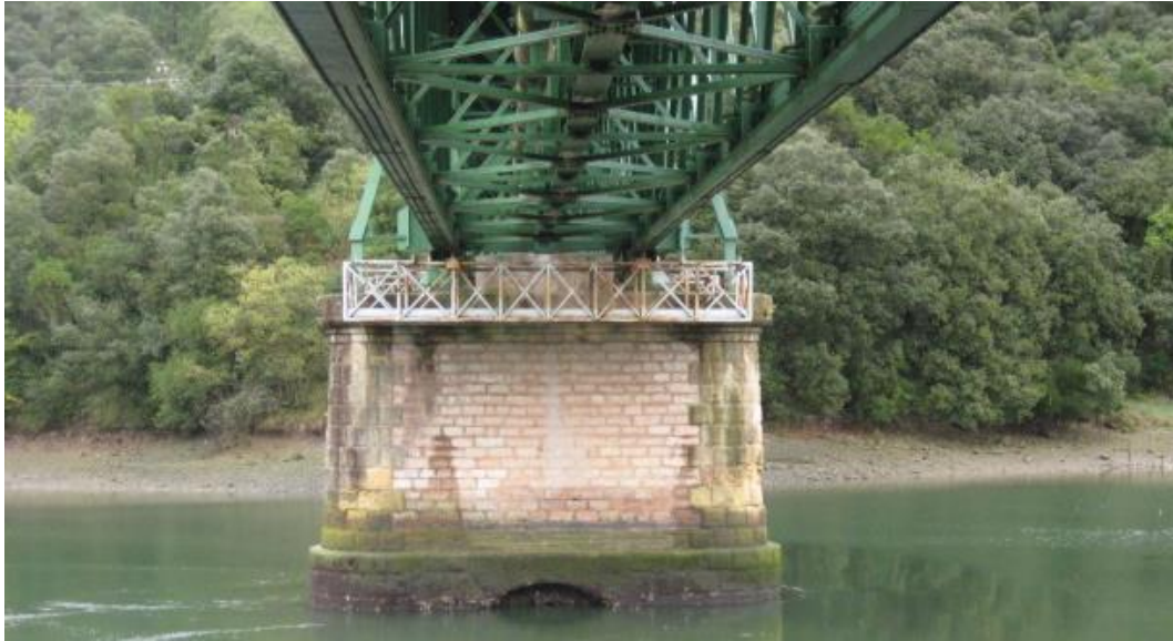
Figura 9. Alzado de pila 1 desde estribo 1.
