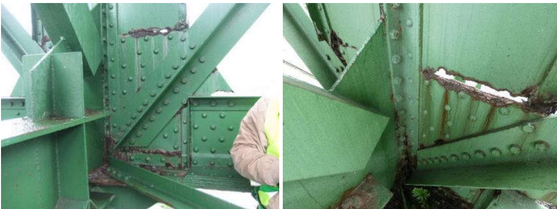
Figura 20. Montante de apoyo aguas abajo sobre la pila 1. Imagen tomada en 2011, izquierda, y en 2020, derecha.
