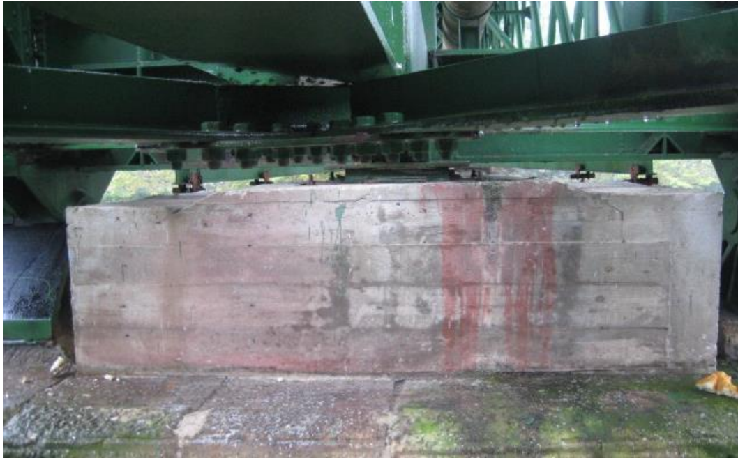
Figura 11. Cargadero de hormigón de pila 1 desde vano 2.
