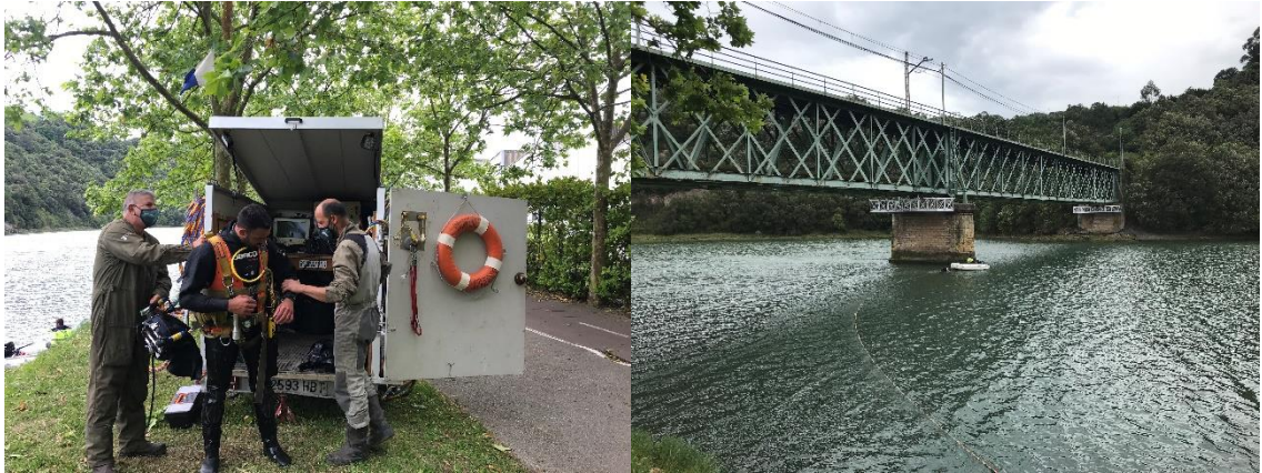
Figura 55. Izquierda, preparativos previos a la inspección y derecha, el buzo acompañado de la embarcación durante los trabajos.
