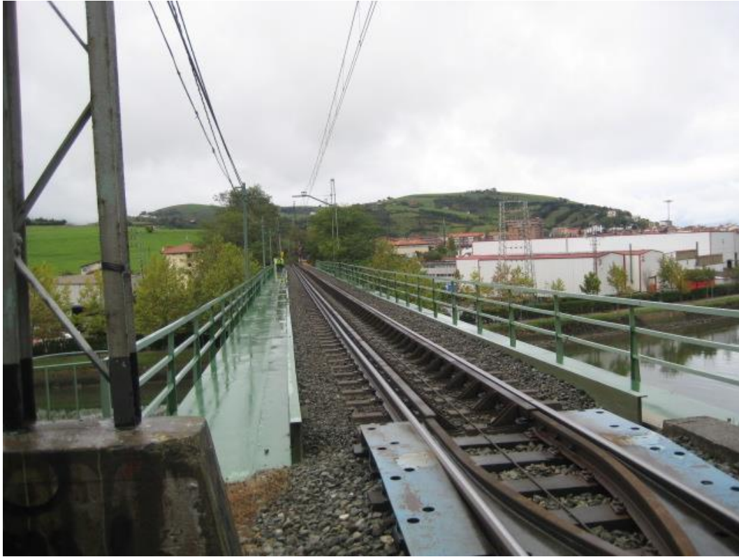
Figura 13. Vista de la plataforma en sentido PK decreciente desde el estribo 2.
