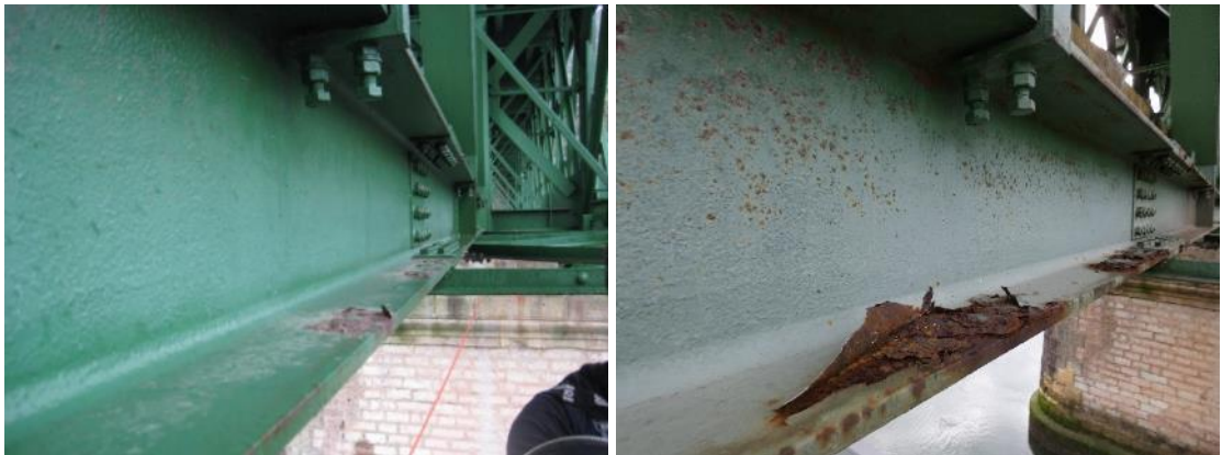
Figura 24. Cordón inferior del módulo 8 del vano 1. Imagen tomada en 2011, izquierda, y en 2020, derecha.
