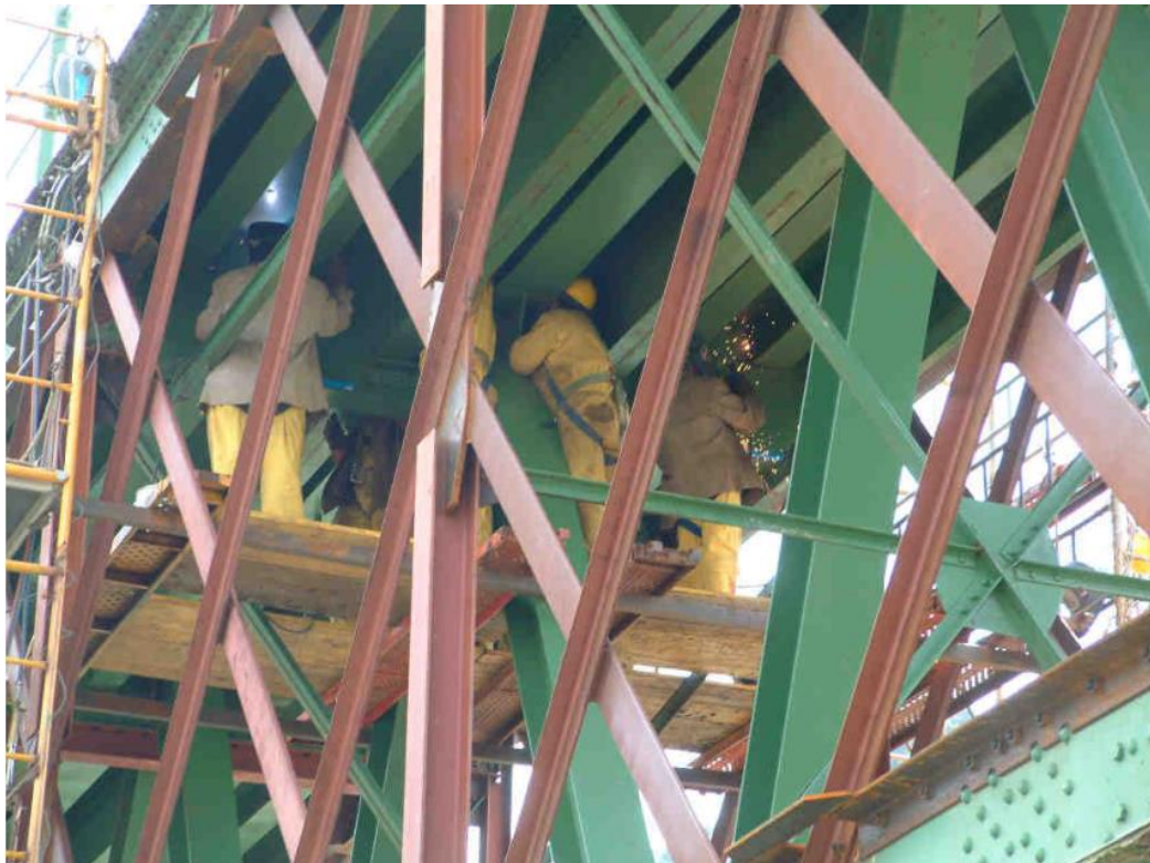
Figura 4. Andamios empleados para las reparaciones realizadas en 2003.
