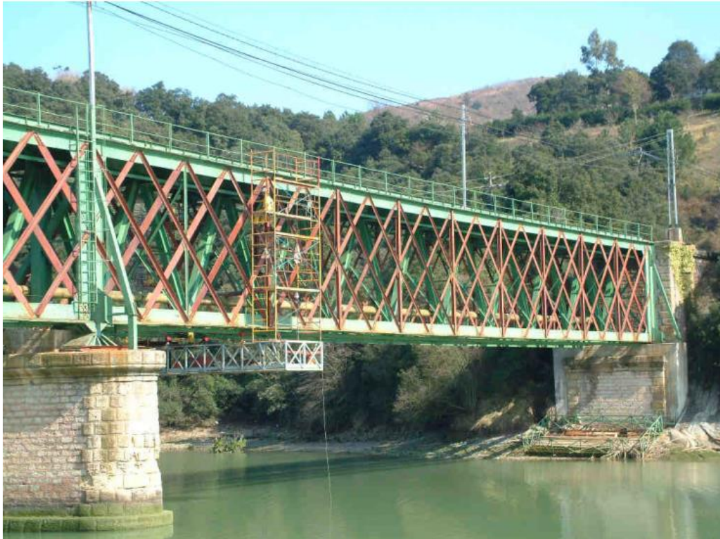
Figura 3. Diferentes tonalidades de perfiles originales y nuevos. Obras de refuerzo de 2003.
