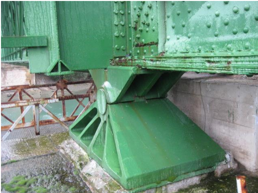
Figura 12. Aparato de apoyo izquierda de pila 1.
