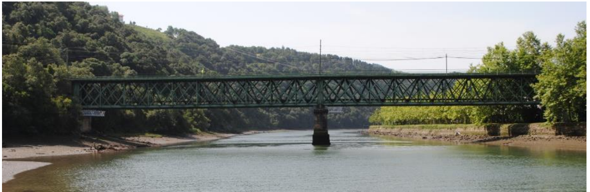
Figura 14. Alzado del puente desde aguas abajo tomada durante la inspección especial realizada.
