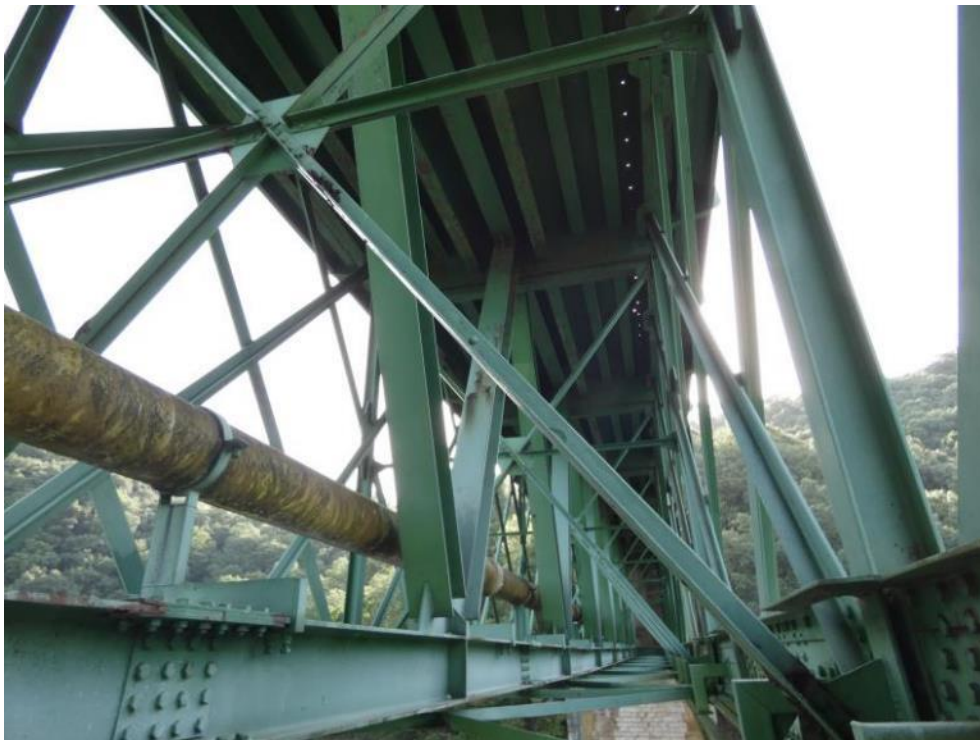
Figura 1. Vista de la celosía central ejecutada según el proyecto de reparación de 1989.
