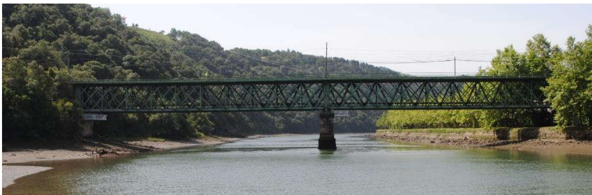
Figura 1. Alzado del puente desde aguas abajo tomada durante la inspección especial realizada.
