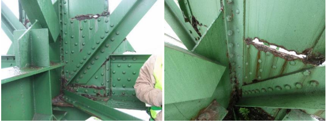
Figura 33. Montante de apoyo aguas abajo sobre la pila 1. Imagen tomada en 2011, izquierda, y en 2020, derecha.
