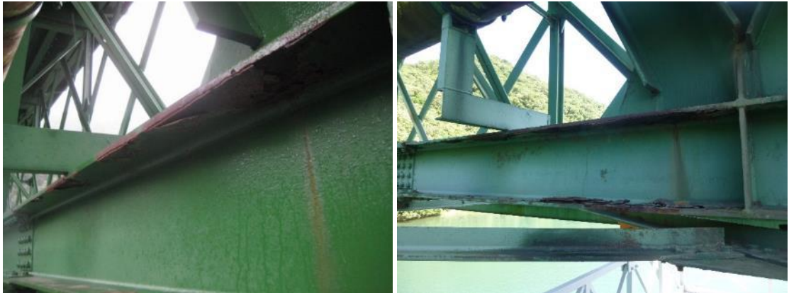
Figura 25. Cordón inferior del módulo 2 del vano 2. Imagen tomada en 2011, izquierda, y en 2020, derecha.
