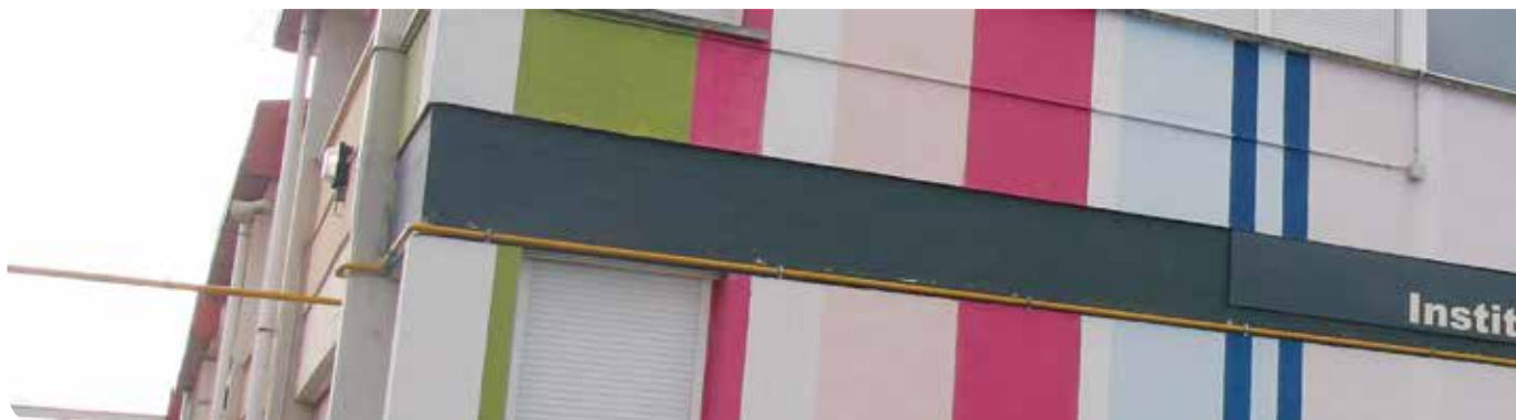
CIFP Construcción LHII Vitoria-Gasteiz
