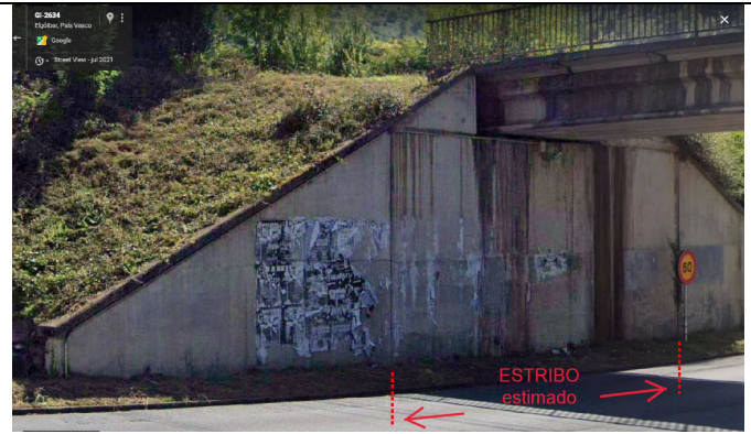
Vista de estribo existente
