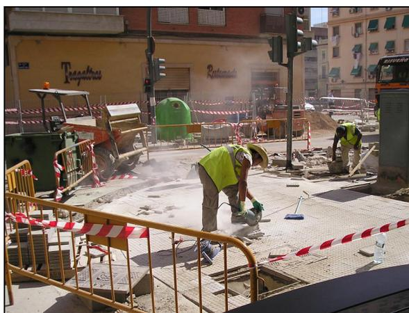
Figura 4.6. – El corte de material en seco produce una emisión alta de PM<sub>10</sub>
