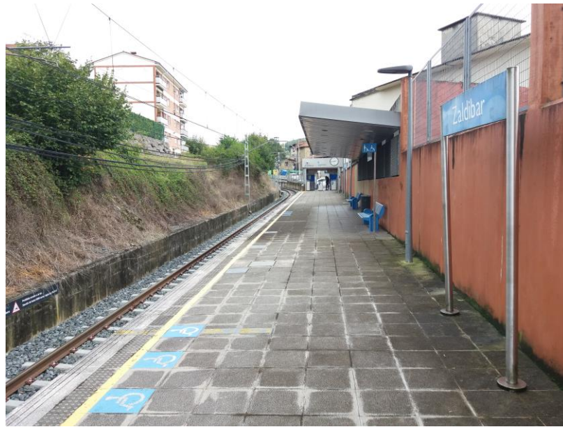
Foto 23. Vista del andén de la estación ferroviaria.
