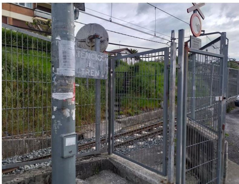
Foto 1. Vista del acceso al paso a nivel peatonal a suprimir en el mismo margen que la estación de Euskotren de Zaldibar.
