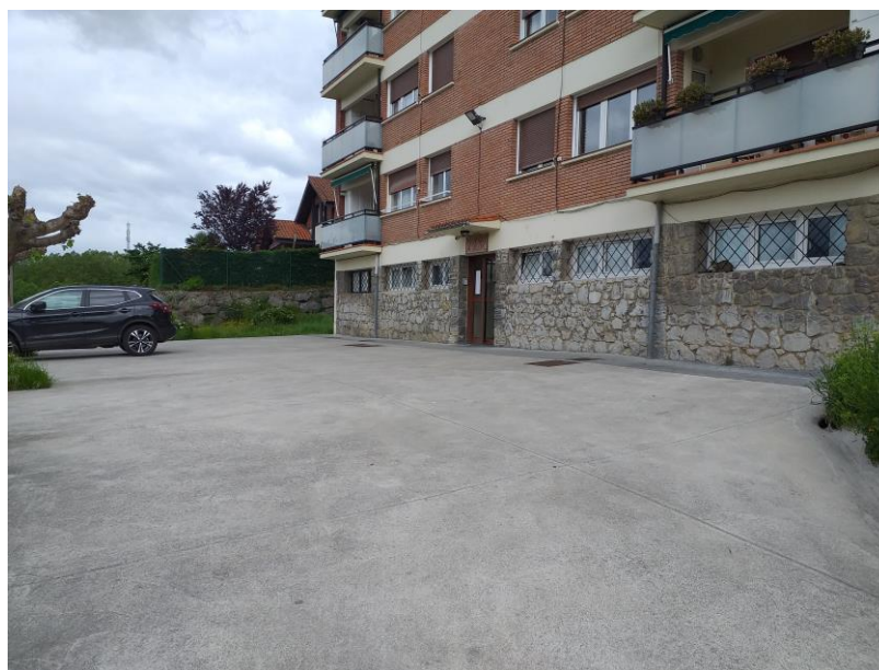
Foto 6. Vista de la parcela situada en el nº 4 de la calle Zalduarán que da acceso al paso a nivel peatonal a suprimir .
