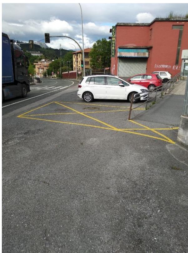
Foto 16 Vista de la zona anexa al acceso a la estación donde se realizará la actuación de la urbanización de la zona..
