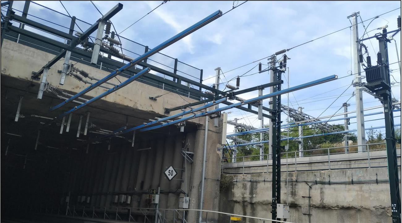
*Referencia detalle transición entre catenaria rígida y convencional en entrada al túnel de Chamartín (Madrid)*
