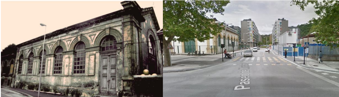
Edificio protegido situado junto al actual falso túnel de Morlans.
