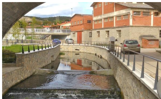
Figura 9. Estación de aforo tipo. Vertedero Crump modificado (SA04-Manantial Nanclares de la Oca). Fuente: URA.
