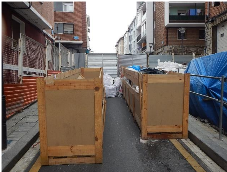
Figura 4. Residuos generados en obra en el montaje de las escaleras
