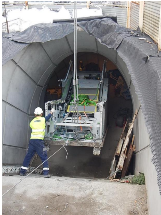
Figura 3. Envío a obra de las escaleras mecánicas en cañones
