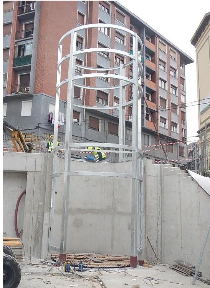
Figura 2. Montaje del ascensor en vía pública
