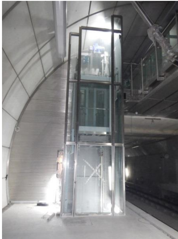
Figura 1. Montaje del ascensor en el interior de la estación
