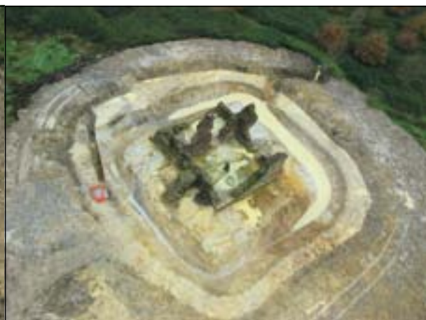
Torre de Aguirre. Izda. Foto aérea antes de la excavación del foso. 090.jpg / Dcha.: Foto aérea después de la excavación del foso.
