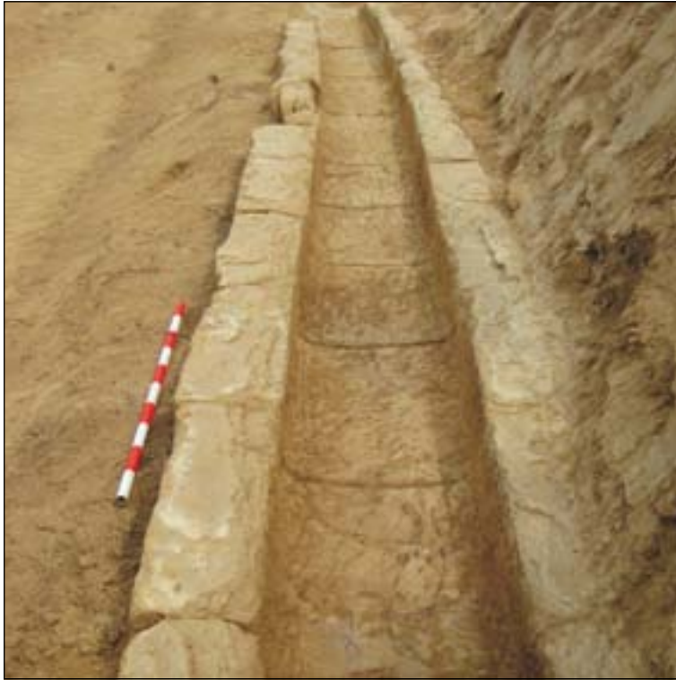
Gurutze bidea edo Machimbrao. Induskatutako harrizko kanala, 1864. urte aurreko obra hidraulikoari dagokiona.
