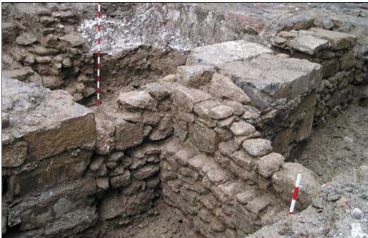
Jatorrizko eraikinari dagozkion hormen xehetasuna, Toriles eraikinean xx. mendearen hasieran eginiko zutabeek ebakiak horma horiek (Tolosa).
