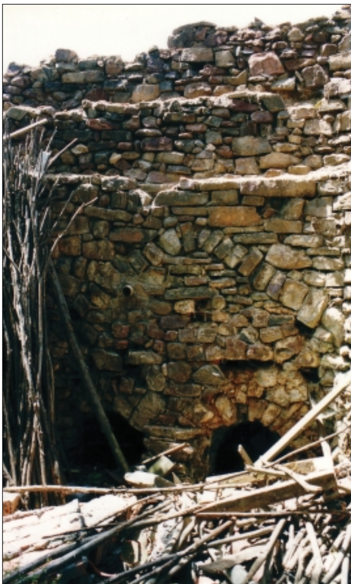
Tejería de Telleria (Arrasate). Vista frontal del horno.
