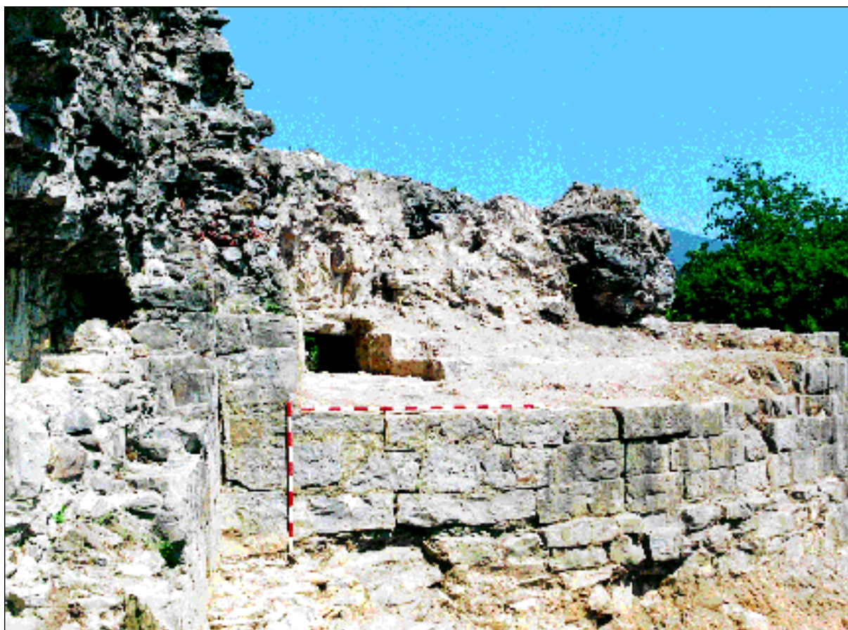
Hegoaldeko Kuboaren kanpoko aldeko altxaerako paramentuan, silarrizkoan, kontserbatutako atalen ikuspegia eta kanoi-zuloaren kanpoko alde. Gazteluzar (Irun).
