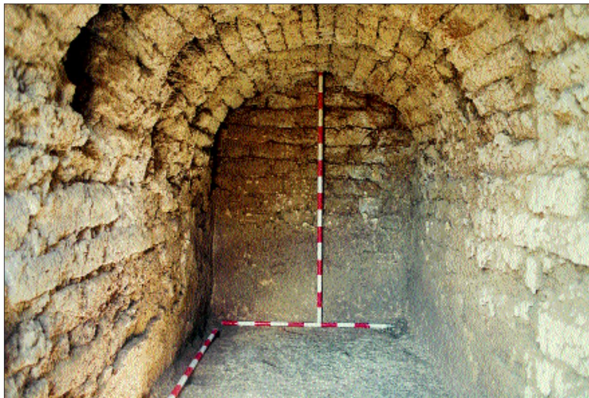
Labearren konbustio ganbarako korridore gangadunetako baten barnealdea.
