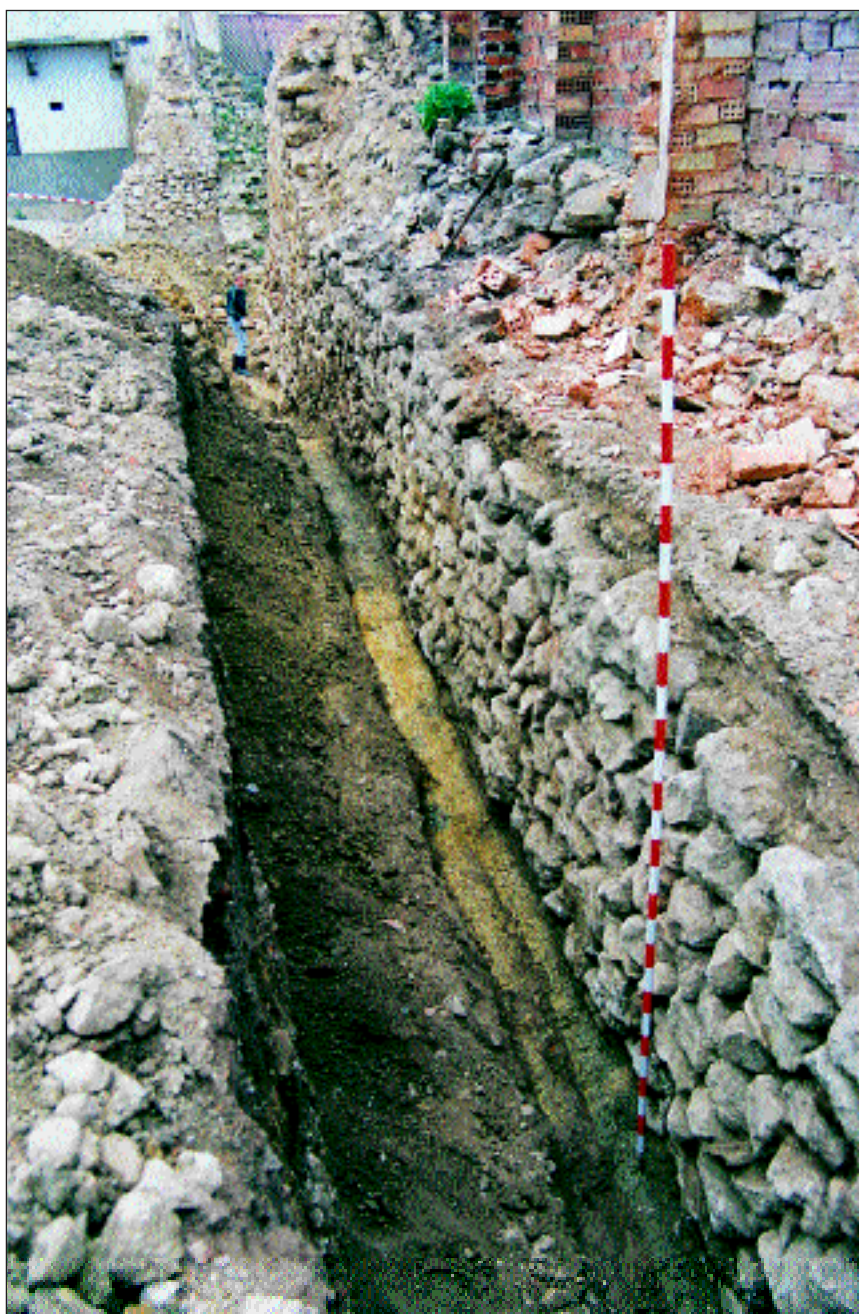
Vista general de las zanja 4 junto a los restos de la muralla.
