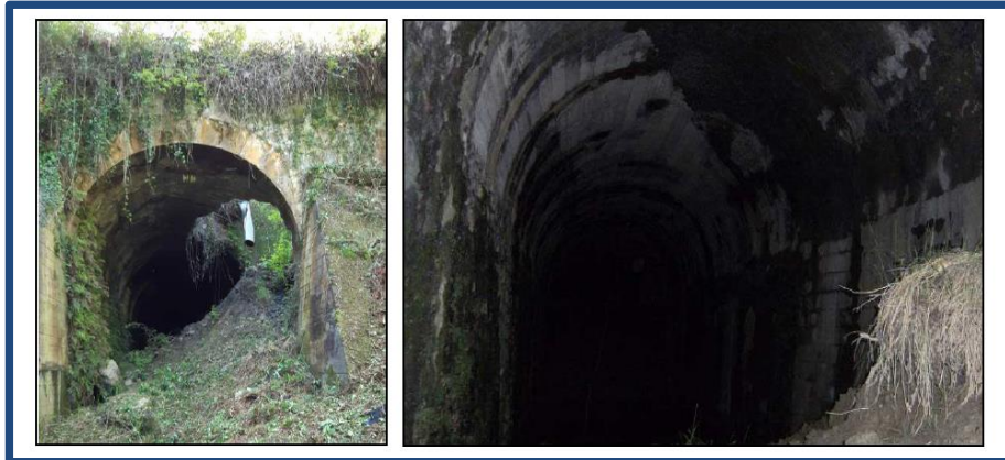
Irudia 5. ARROAKO tunela. Irteerako ahoko lehen lur-erorketa.
