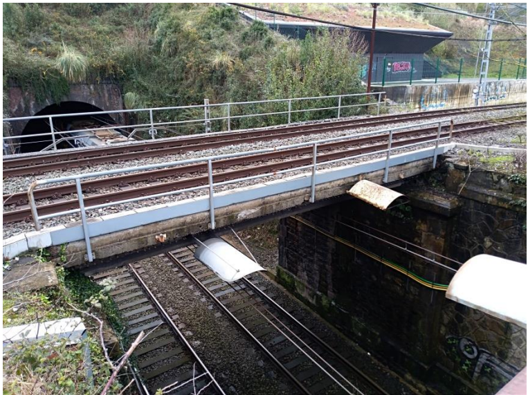
Cruce de las vías de ETS y de ADIF.
