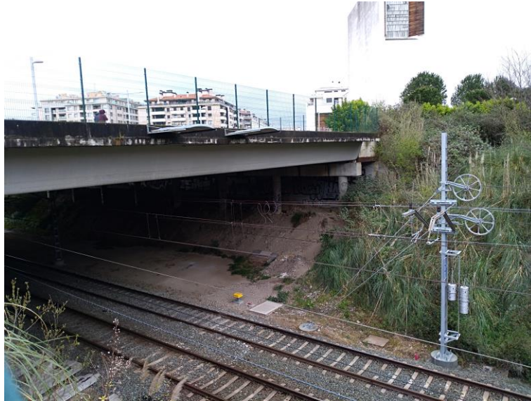
Situación de las vías de ADIF bajo la calle Gregorio Ordoñez (vista desde Av. Zorroaga).
