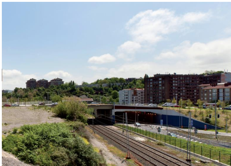
Situación de las vías de ADIF bajo la calle Gregorio Ordoñez (vista desde Av. Riberas de Loiola).
