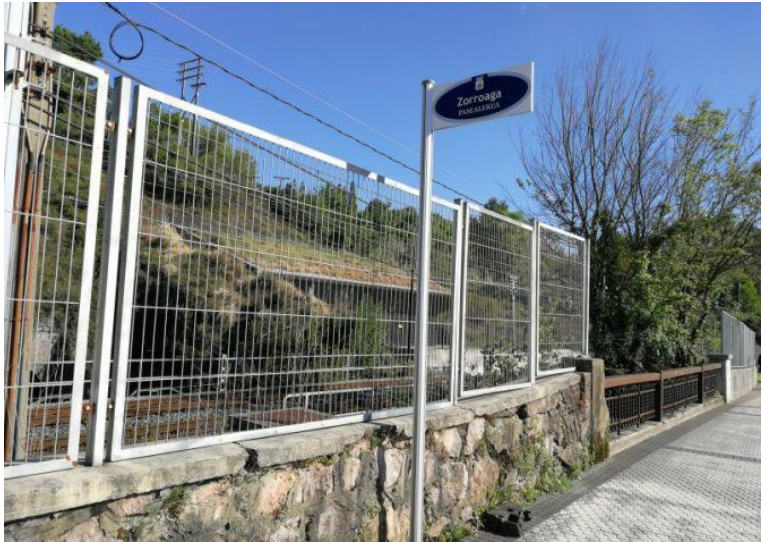
Zona de cruce de las vías de ETS y de ADIF.
