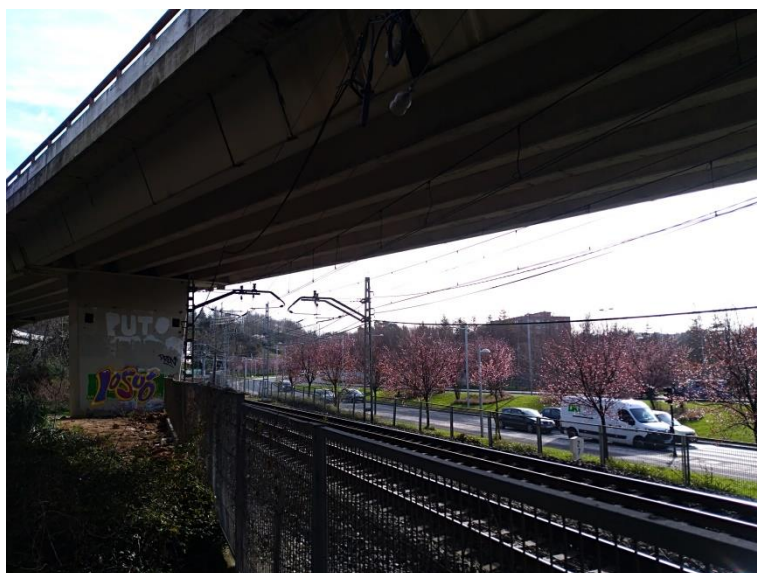
Situación de las vías de ETS bajo el viaducto de la GI-20.
