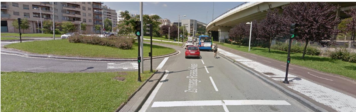
Intersección semaforizada aguas abajo de la margen derecha del Paseo de Zorroaga
