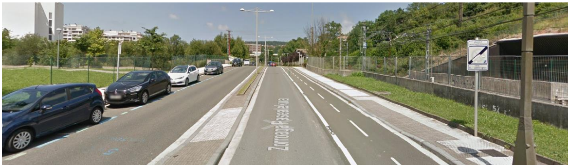
Sección tipo Paseo de Zorroaga entre las calles Toribio Alzaga y cruce con las vías ADIF – Zona 1 (vista en sentido Plaza Padre Donostia a Rotonda de Loiola)
