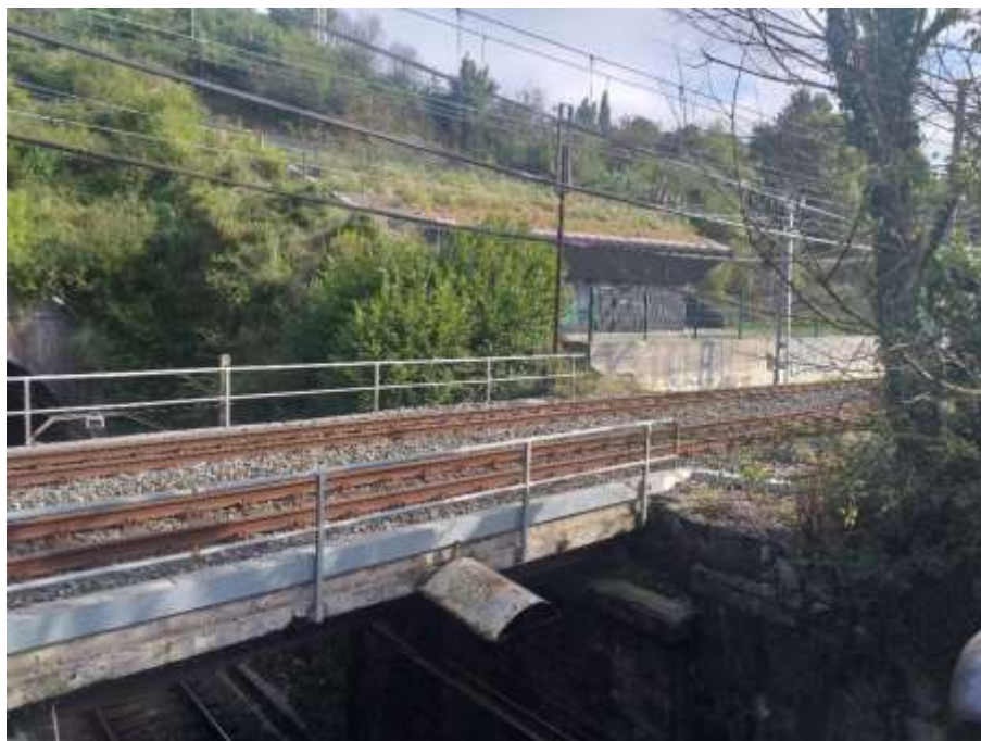
Edificio de control de la variante de la GI-131 y paso sobre vías de Adif
