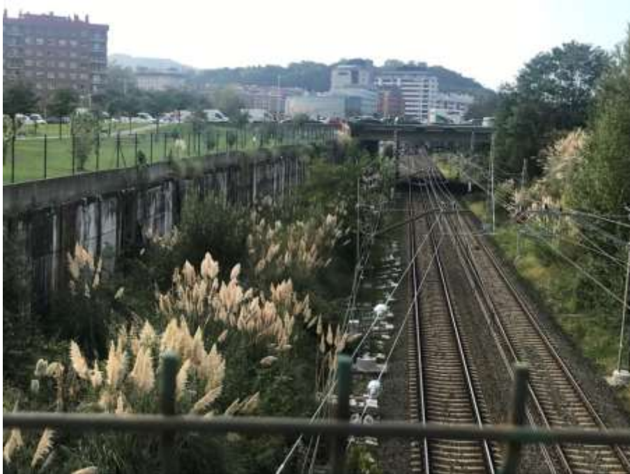
Vías de Adif. Futura cubrición
