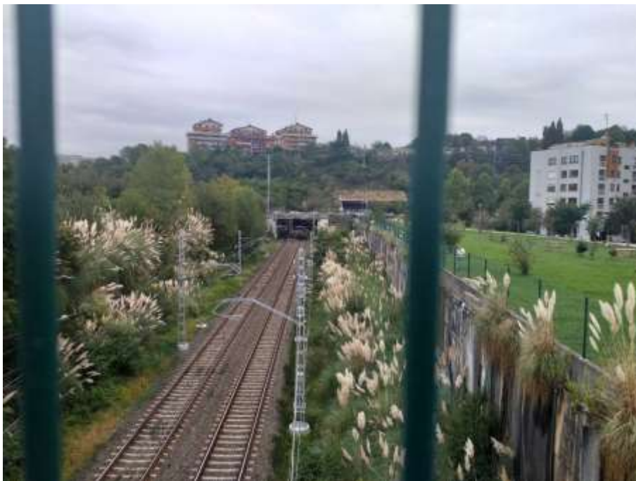
Vías Adif a cubrir. Al fondo paso del Paseo de Zorroaga a demoler.
