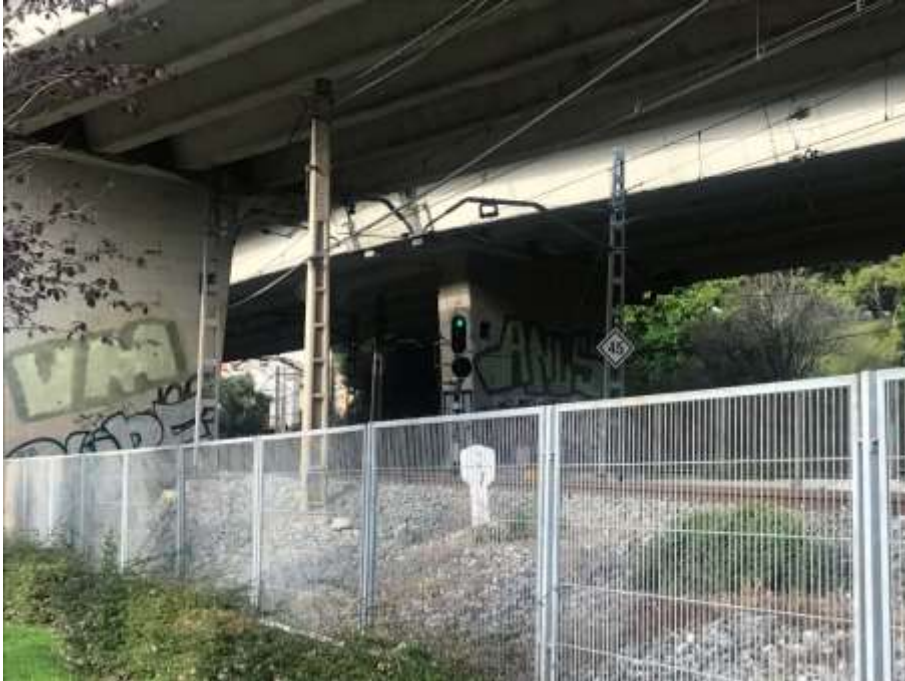
Paso de las vías de ETS bajo el viaducto de la GI-20
