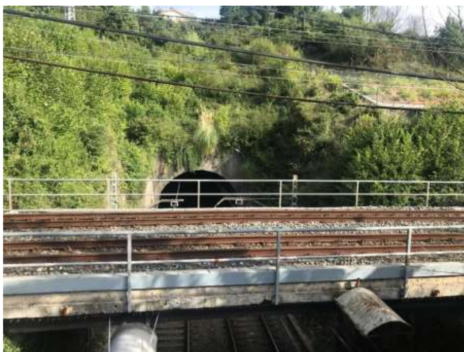
Paso de las vías de ETS sobre las vías de Adif (a demoler)
