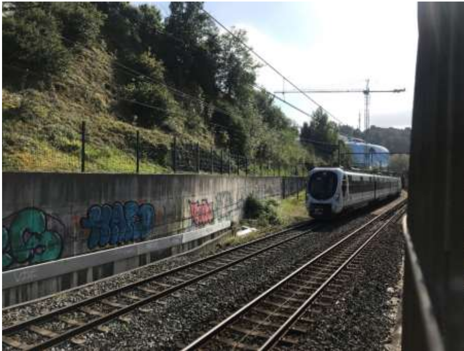
Inicio del tramo. Salida del túnel de Anoeta.
