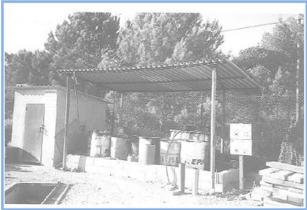
Detalle ubicación de residuos peligrosos en Punto limpio.
